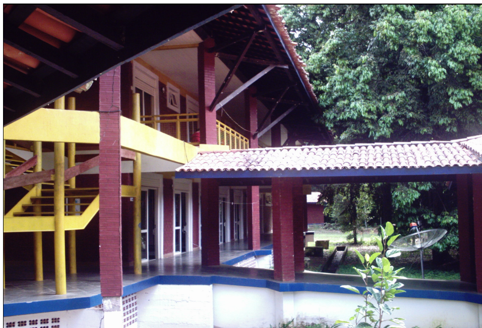
Figura 3.4. Estrutura interna da ECFPn.
