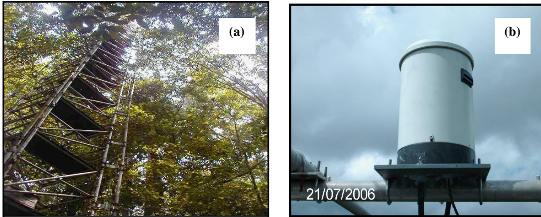
FIGURA 7 – (a) Torre Micrometeorológica de 54 m de altura na Floresta de Caxiuanã,-PA Fonte: www.mileniolba.ufpa.br , (b) Pluviógrafo do modelo TB4-L Rain Gauge da Campbell Scientific instalada na torre micrometeorológica de Caxiuanã.
