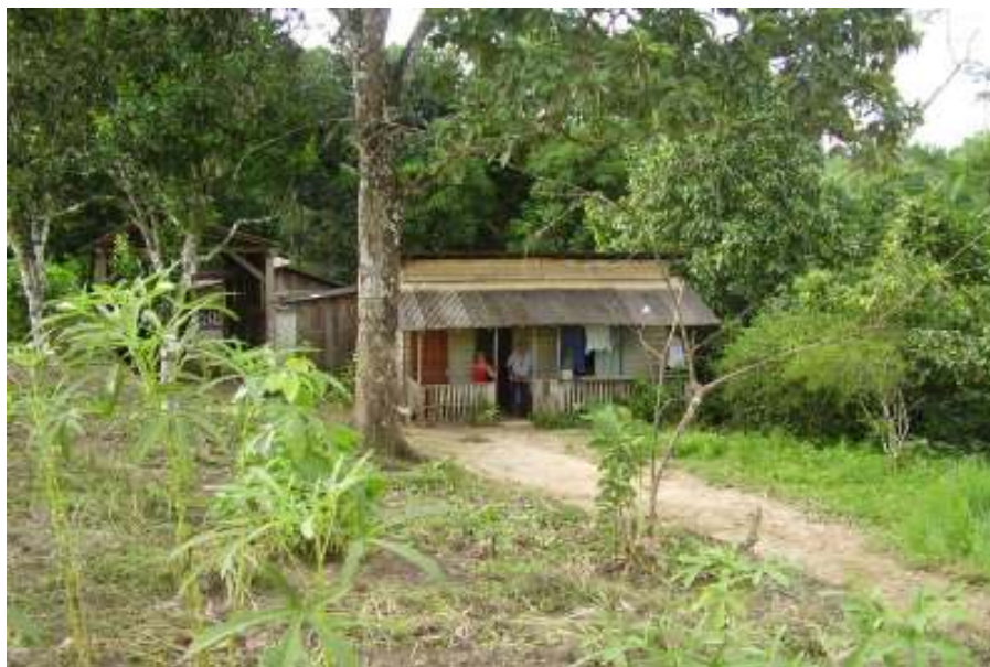
Foto 45: Típica casa de colonos construída pelo INCRA-1972. Ainda existem muitas delas na Transamazônica. (Ivone Coutinho, 2006).
