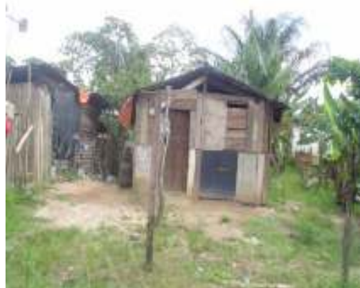
Fotografia 10 – parte externa da casa 2
