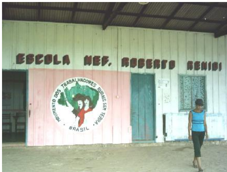
Figura 02. Vista externa da escola do assentamento João Batista II, no Município de Castanhal – Pará.
