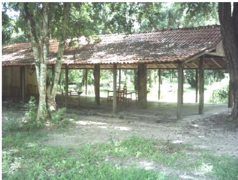
Figura 03. Vista da área da escola do assentamento Mártires de Abril, em Mosqueiro, município de Belém – Pará.
