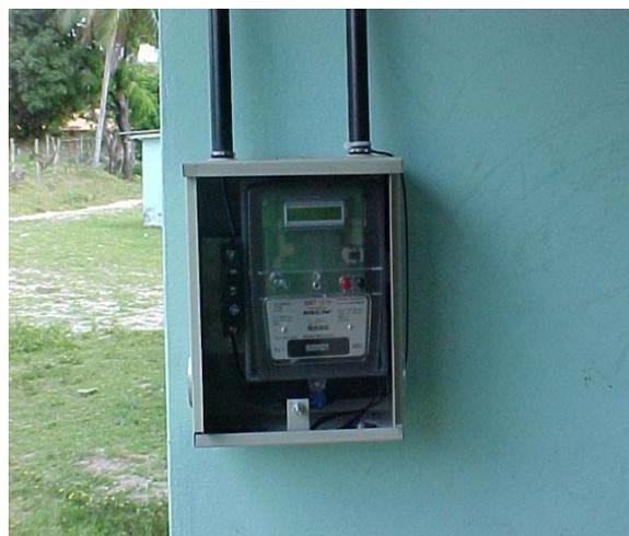
Medidor de energia (sistema pré-pago).
