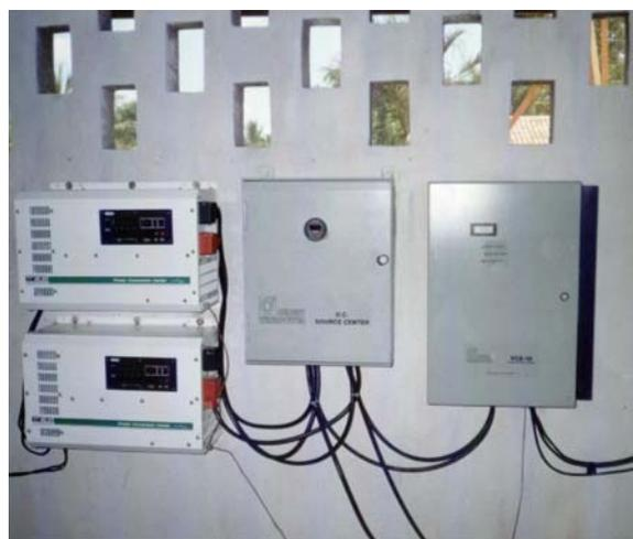
Inversores de tensão a esquerda e retificador a direita.
