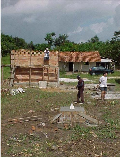
Casa de força, sendo construída e preparação das bases da torre do aerogerador.
