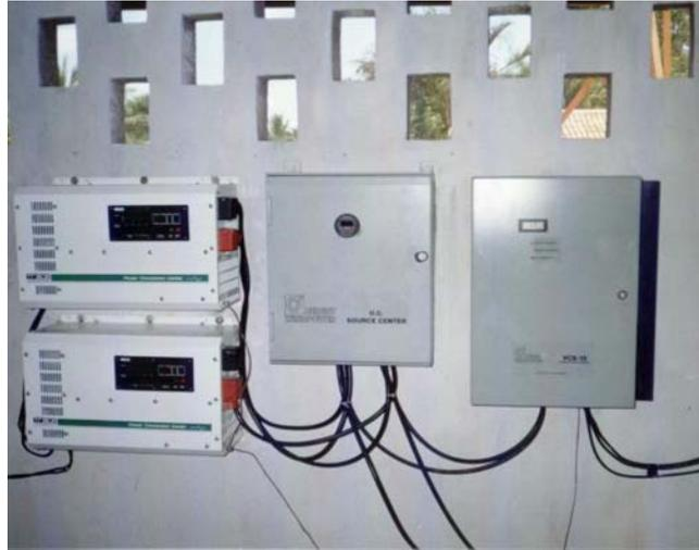
Figura 2.13 – Sistema de condicionamento de potência de Praia Grande.
