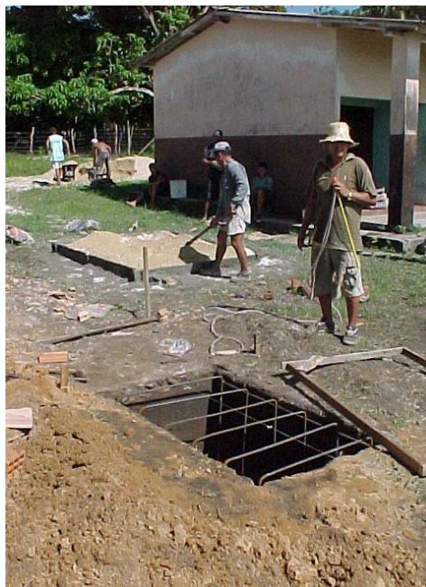
Preparação das bases de suporte da torre do aerogerador.
