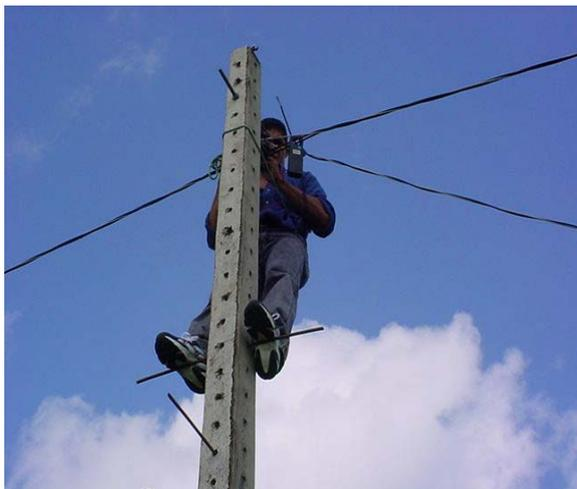
Instalação da fiação da rede de distribuição.
