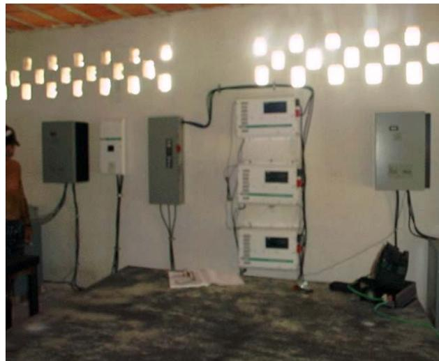
Figura 2.15 – Componentes do sistema de condicionamento de potência.
