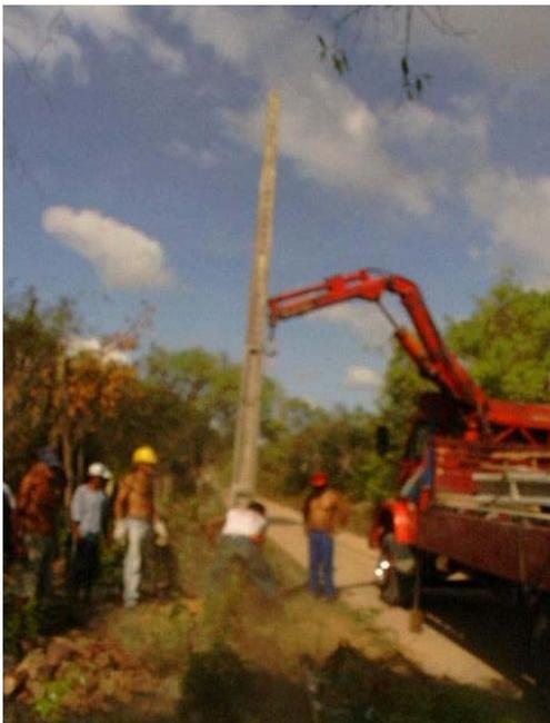
Instalação dos postes de concreto da rede de distribuição.
