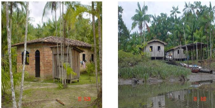
Figura 26 - Domicílios em madeira e alvenaria encontrados na comunidade de Genipaíba. Fonte: SEOP (2007)
