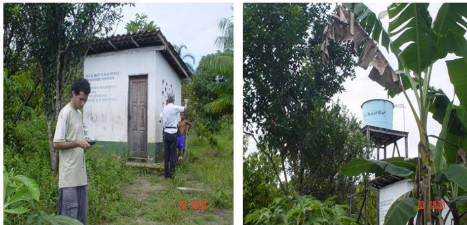
Figura 28 - Microsistema de abastecimento de água existente na comunidade de Genipaúba. Fonte: SEOP (2007)
