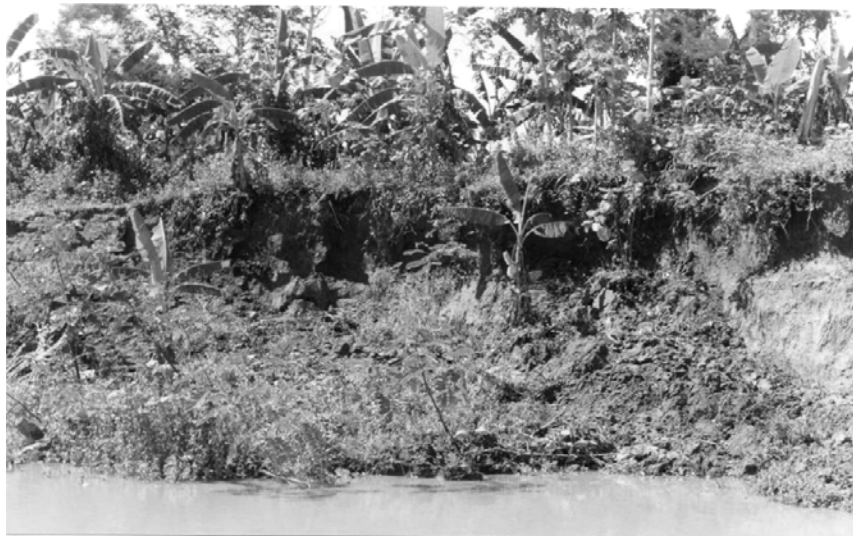
Foto 12. Procesos erosivos de las orillas en el área de estudio. Fuente: Romero-Pinedo, R.C.
