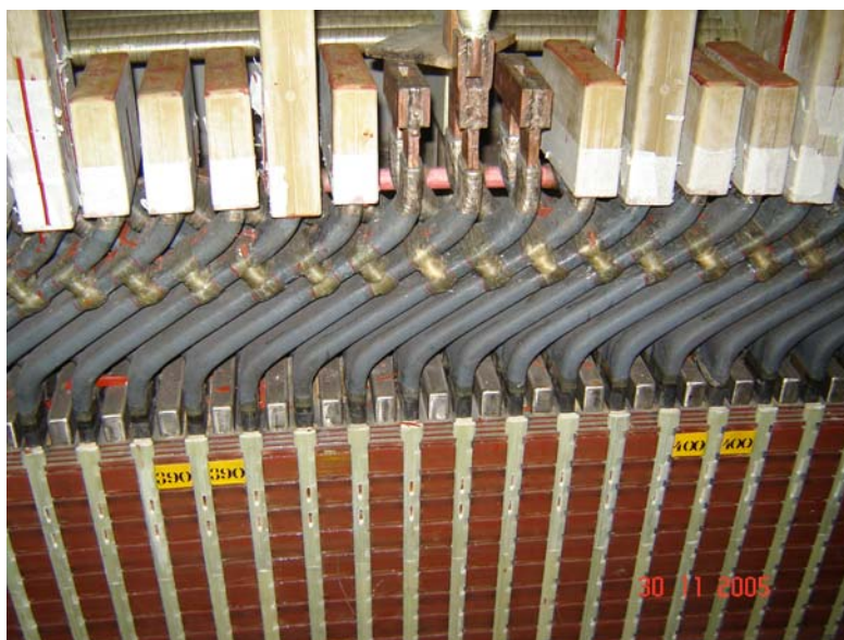
Figura 4.1 – Estrutura do estator em construção.
