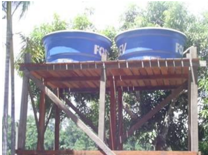
Figura 20 - Aquisição de Caixas de Água e tratamento da Água
