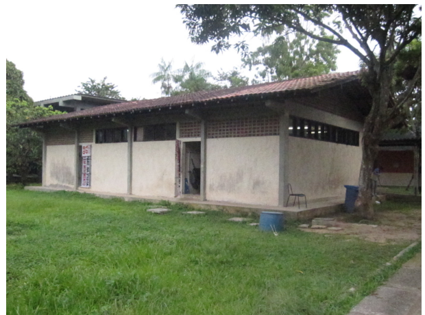
Foto 4.2- Banheiro coletivo localizado no Campus Profissional.
