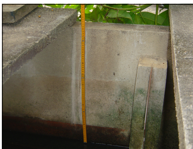
Fotografia 10: medição na lamina de água no vertedor
