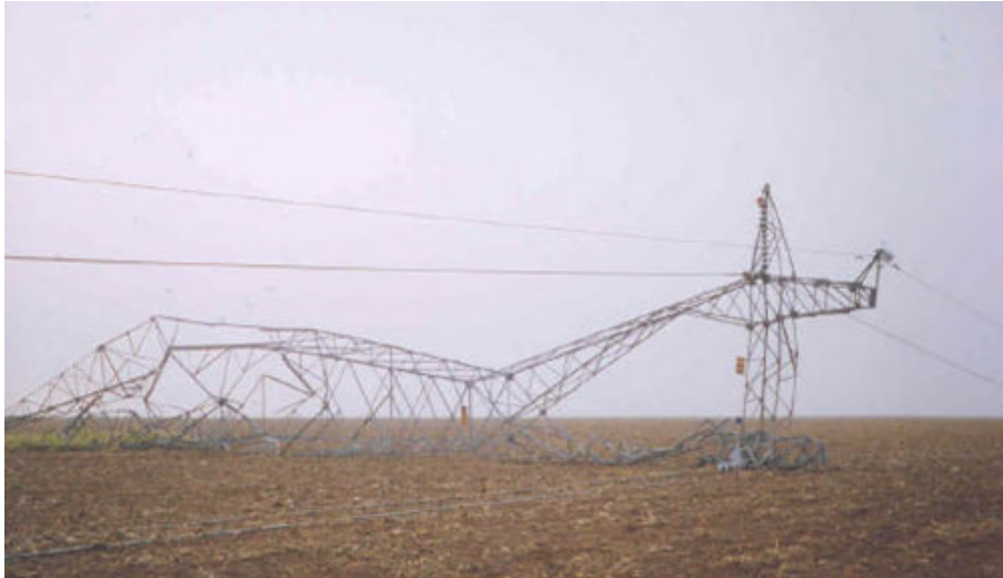
Figura 1-1 - Torre 195 colapsada, componente da LT de 230 KV Caxipó/Sinop no Estado do Mato Grosso (Caldas, 2004)
