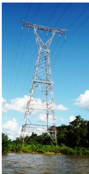
(a) Torre vista do rio Guamá
