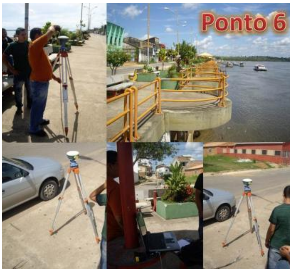
Fotografia 14 - Ponto de controle 6, às margens do Rio Tocantins.
