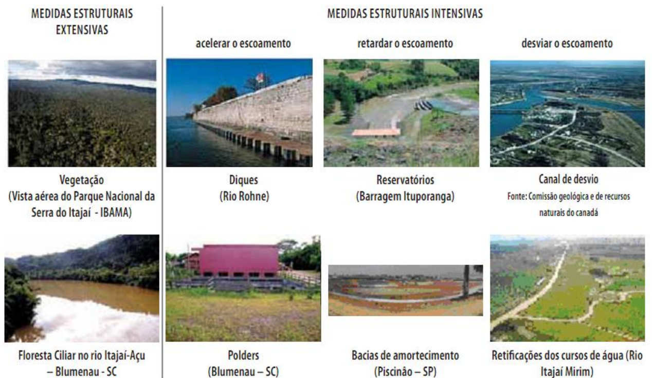
Figura 10 - Exemplos de obras estruturais. Fonte: (SANTOS, 2007)
