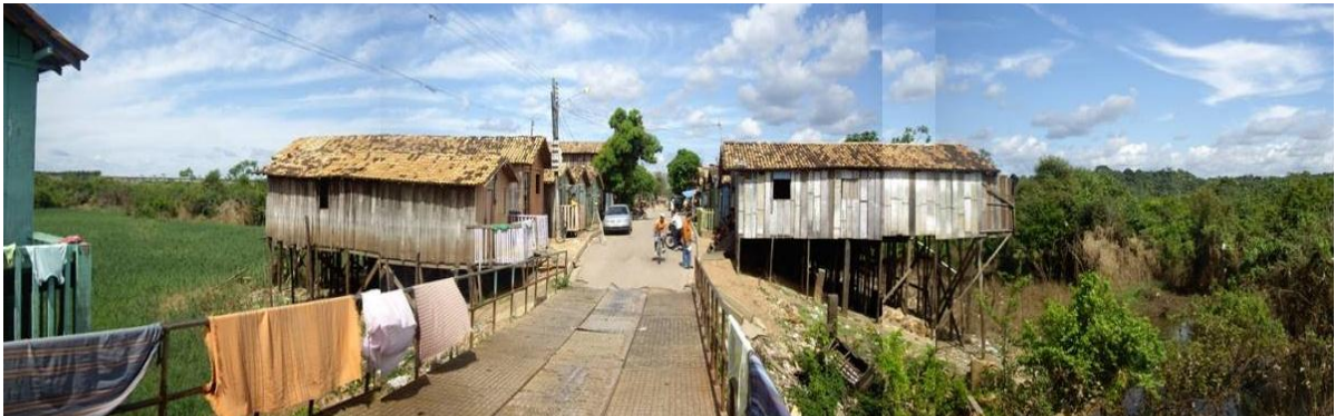
Fotografia 4 - Exemplo de moradias em área de risco em Marabá (Cabelo Seco).
