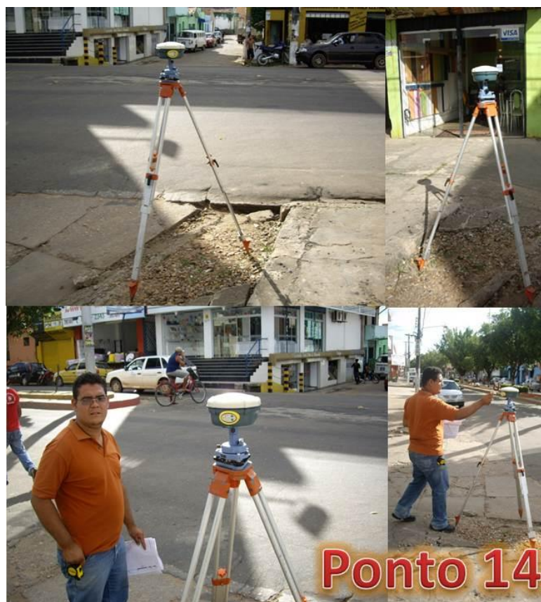
Fotografia 22 - Ponto de controle 14, localizado no cruzamento de vias públicas.
