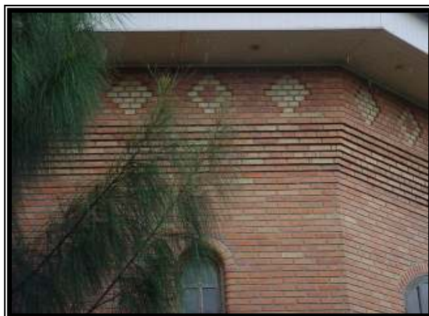
Foto 33 - Revestimento com diversas angulação e cores
