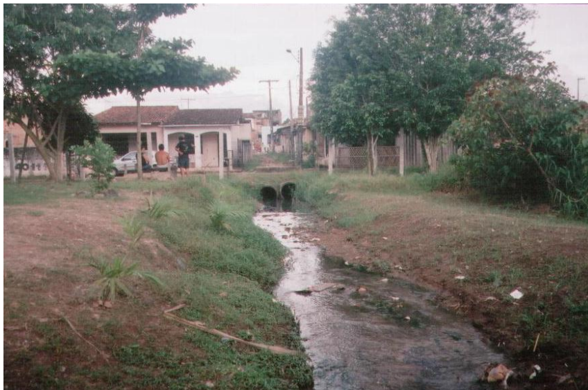
Fotografia 12 - Precariedade do sistema de saneamento básico no Bairro Castanheira, localizado nas cabeceiras do Lago Bolonha
