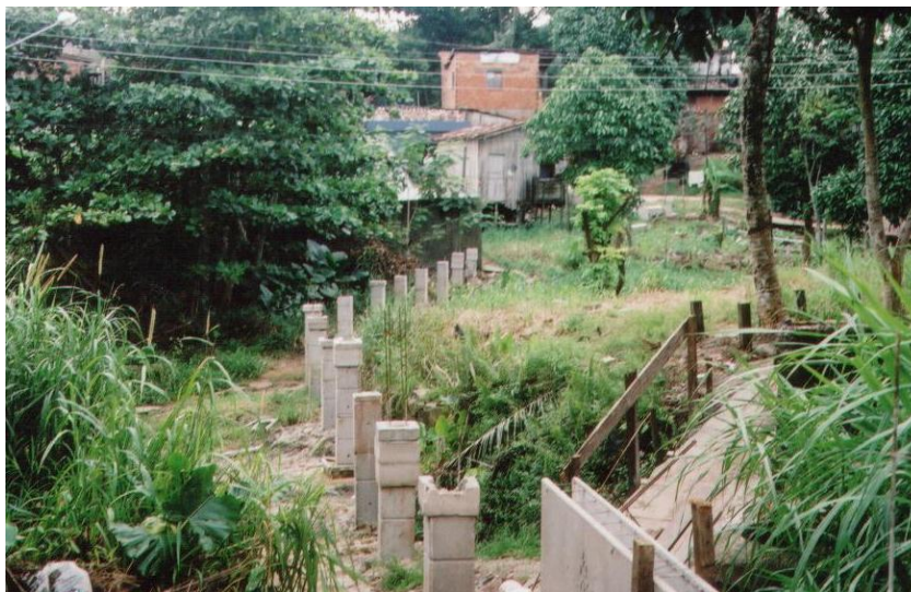
Fotografia 16 - Cerca em aramado em construção no Bairro da Guanabara
