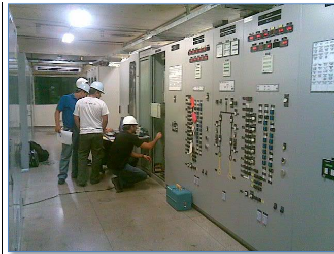
Figura 6-25 - Ensaio sendo realizados no RV da UGH 8
