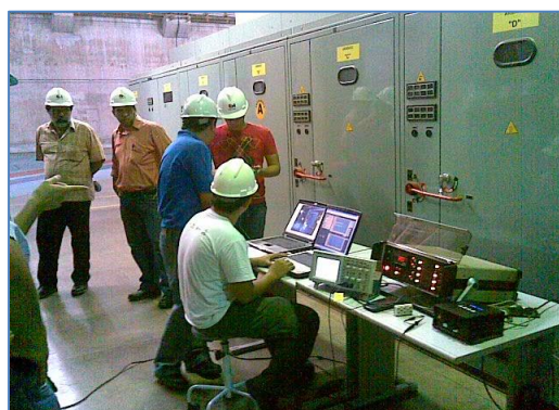
Figura 6-4 - Ensaios sendo realizados no regulador de tensão da UGH 8
