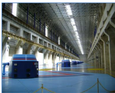
Figura 6-2 - Máquinas da segunda etapa da construção da UHE de Tucuruí
