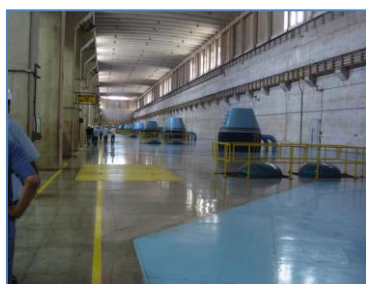
Figura 6-1 - Máquinas da primeira etapa da construção da UHE de Tucuruí
