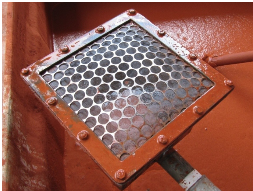
Figura 3.19 - Caixa de peneiramento pressurizada destinada à remoção de areia e/ou partículas grossas.
