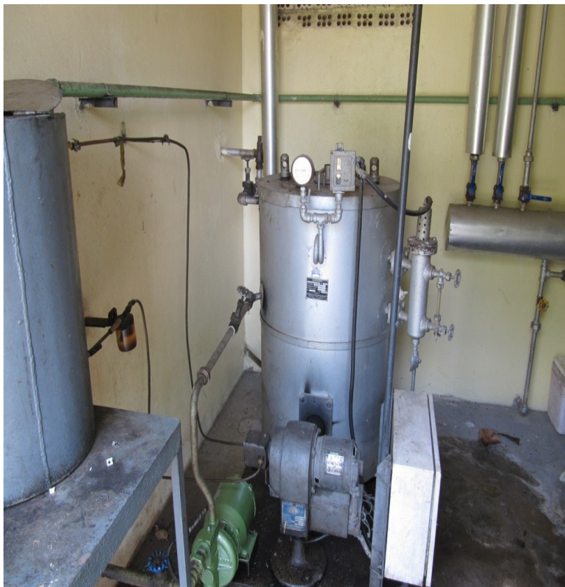
Figura 3.15 - Caldeira GERAMATIC utilizada como fonte de gases de exaustão.
