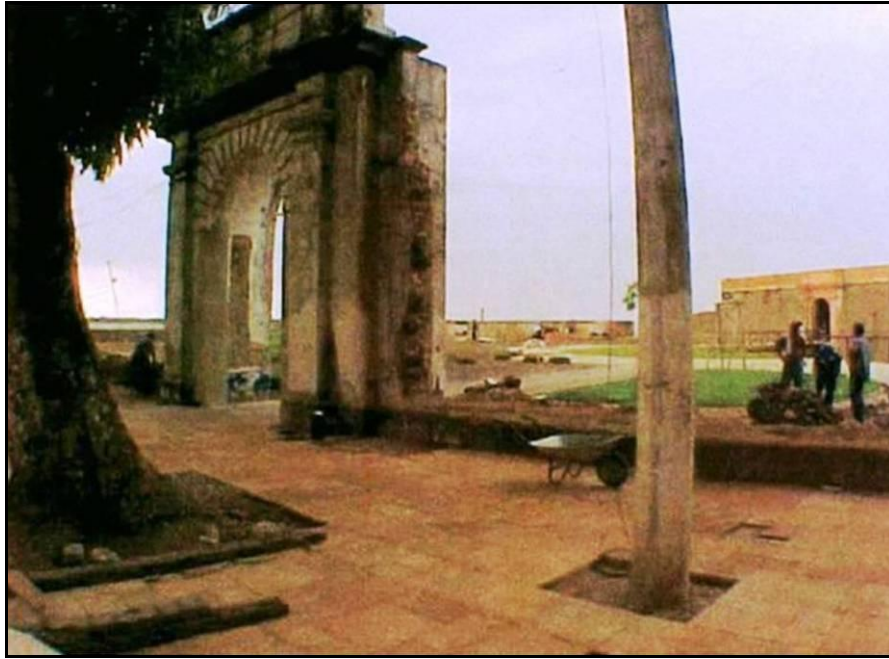
Figura 9 – Imagem do Pórtico, já sem o muro (Adaptado de Costa 2007: 97).
