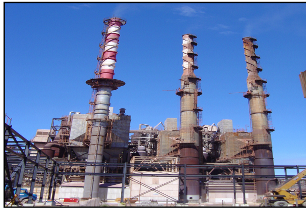
Figura III.7 - Calcinadores de alumina alfa. Fonte: ALUNORTE (2008).
