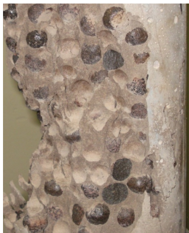
Figura 5.5 - Detalhe da maioria das roturas dos corpos de prova sem rompimento do agregado.
