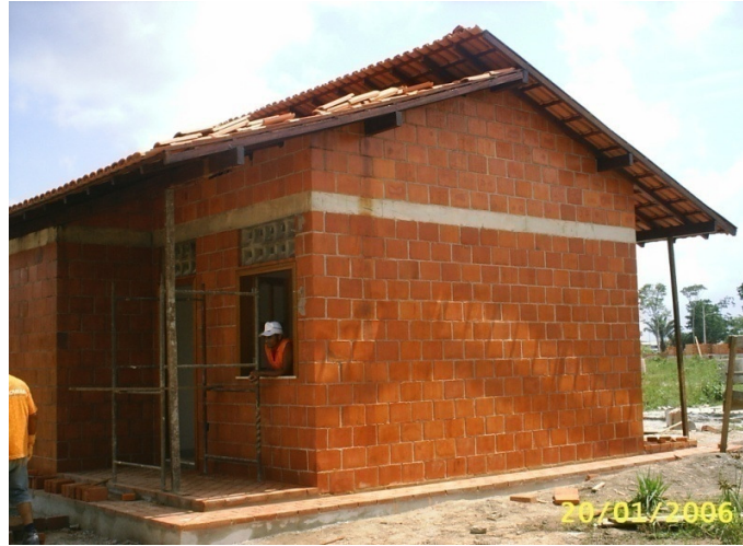
Figura 2.5 - Casa construída com resíduo do processo Bayer. Fonte: SOUZA et al. (2006).
