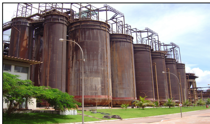
Figura III.6 - Precipitadores de hidrato de alumínio. Fonte: ALUNORTE (2008).
