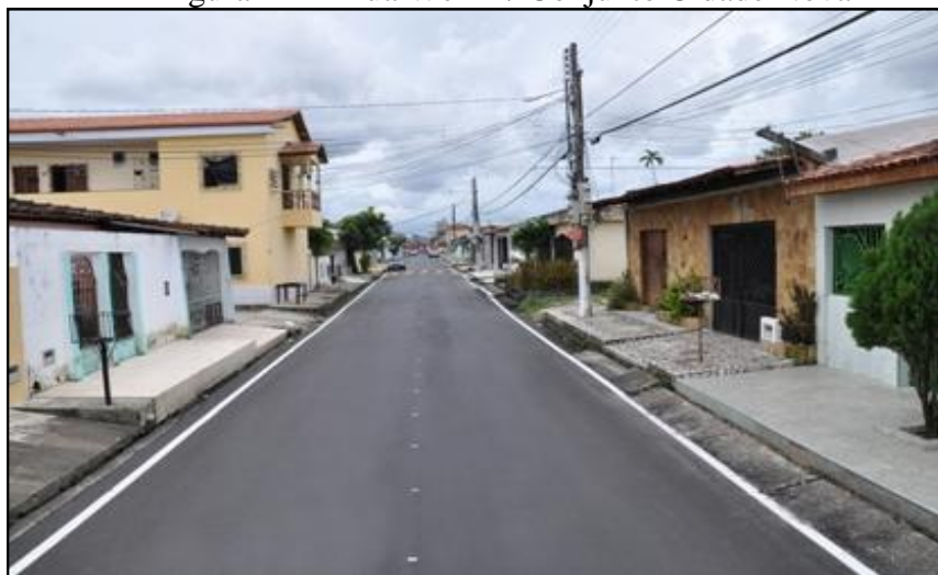
Figura 12 — Rua We 21 / Conjunto Cidade Nova
