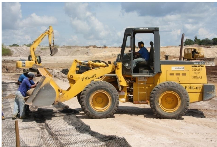
Ilustração 17 – Foto dos Servidores da COMARA durante a obra em Yauaretê.
