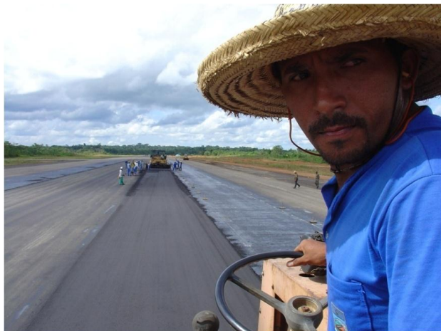
Ilustração 15 – Foto dos Servidores da COMARA durante a obra em Tírios
