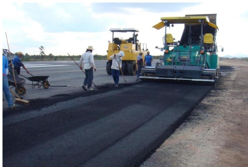
Ilustração 16 – Foto dos Servidores da COMARA durante a obra em Tírios.
