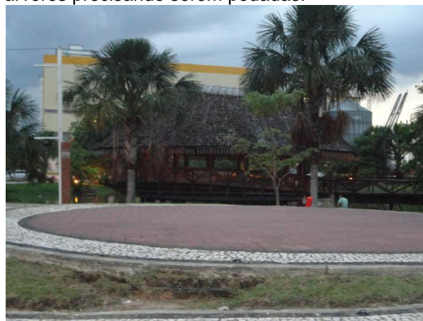
Figura 12: Piso de cimento quebrado e ao fundo árvores precisando serem podadas.
