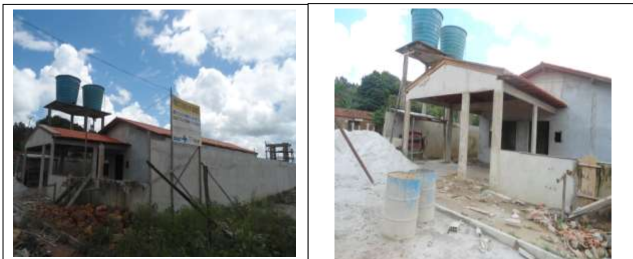
FOTO III – Posto de saúde do assentamento em construção. FONTE: Pesquisa de campo, 2013.
