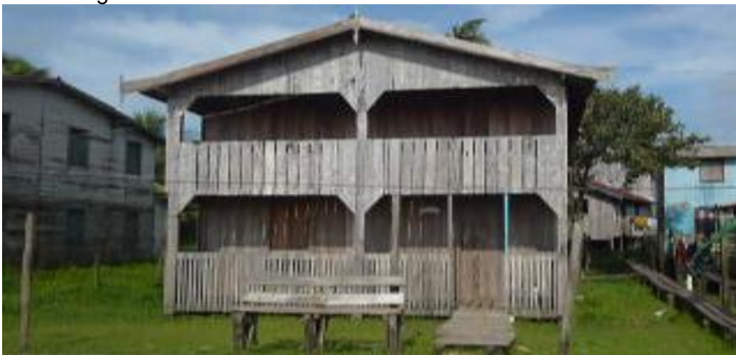
Fotografia 14 – Casas comuns na comunidade Santa-cruzense
