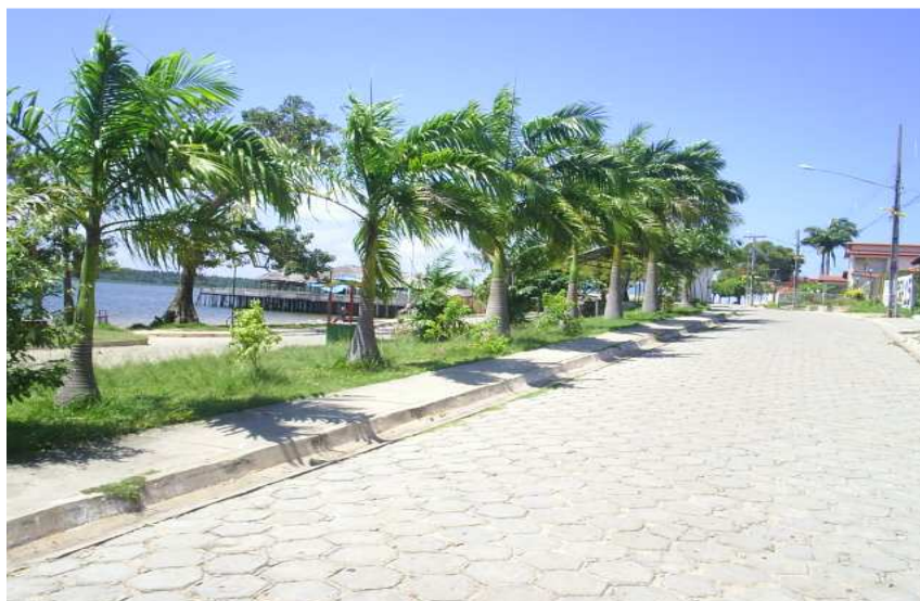
FOTO 2: REVITALIZAÇÃO DA PRAIA DA ALDEIA – Obras de infraestrutura na Praia da Aldeia promovida pelo poder público municipal no início da década de 1990 (Foto: José Carlos, Jun./2007).
