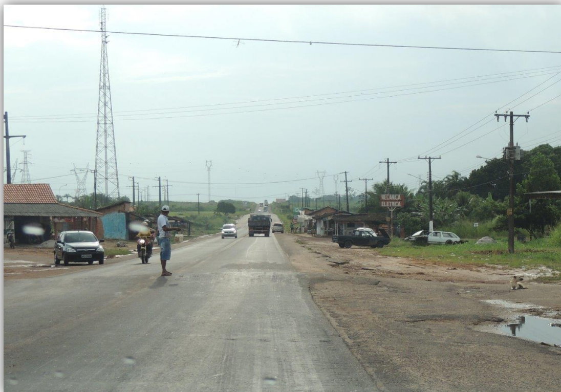
Figura 4.1: Pedestre Promovendo Vendas no Meio da Rodovia BR 316, em Agosto de 2013.
