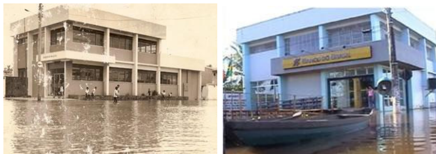
Figura 2.11. Prédio da agência do Banco do Brasil na cidade de Alenquer inundado em 1989 e em 2006, respectivamente. Fonte: MONTE (2006).
