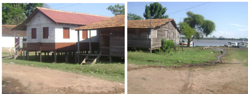
Figura 4.7. Ocupação irregular em condições de riscos, às margens do Surubiú. Fonte: MARQUES (2008).
