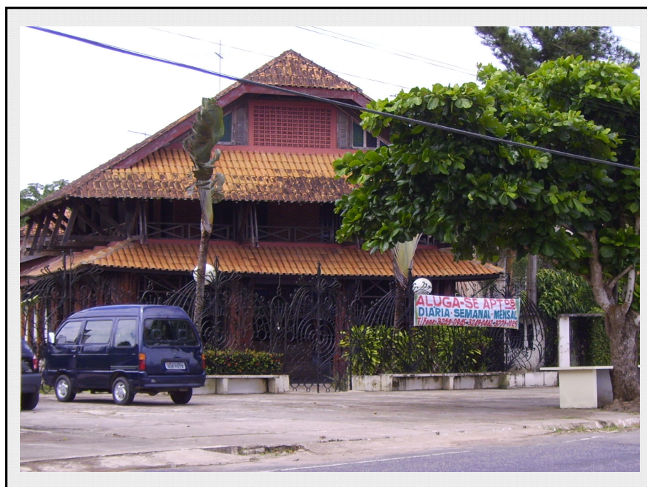
FOTO 19: Casarão com faixa de aluguel de quartos no muro. Foto: Costa, 2006.
