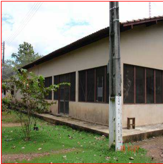
Foto 17. Área externa do alojamento
