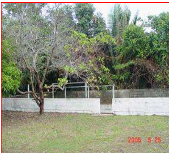
Foto 19. Área externa do alojamento
