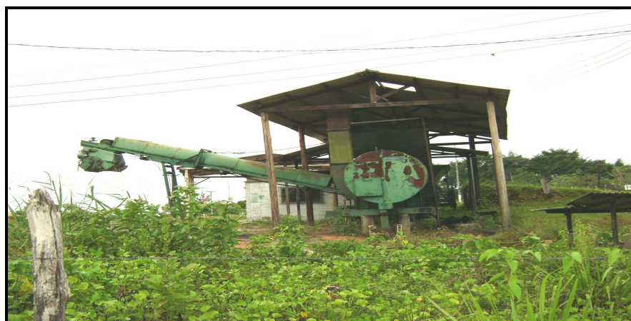
Figura 06: Usina de asfalto de Barcarena.
