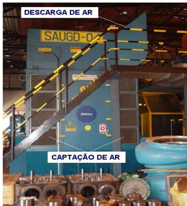
Figura 3.4 – Captação e Descarga de Ar do Gerador
