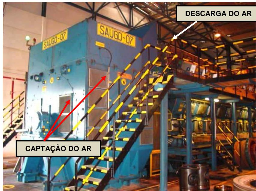
Figura 3.6 – O Gerador e a Captação e Descarga do Ar
