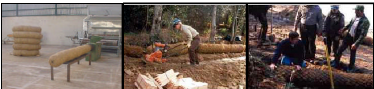
Figura 1.6 – Utilização e aplicação de mantas de fibra de coco para o controle de erosão. (Fonte: Revista POEMATEC, 2003)
