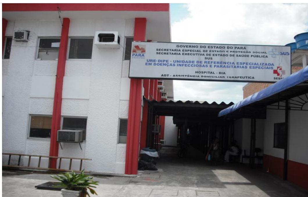
FIGURA 03: entrada principal da UREDIFE
