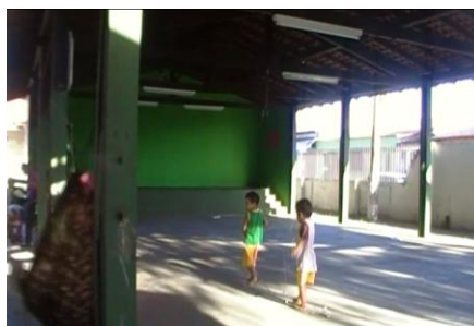
Figura 4. Vista parcial do barracão.
