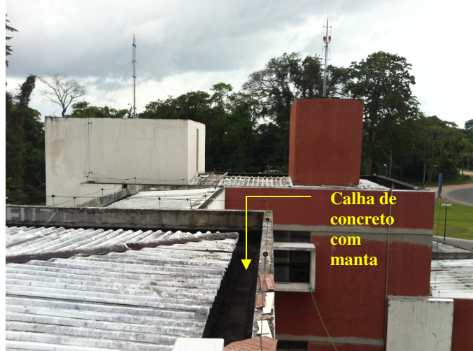
Figura 51 – Calha de concreto fazendo o fechamento de parte da envoltória
