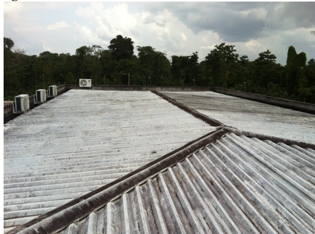
Figura 48 – Detalhe da cobertura do bloco 1 do CEAMAZON
