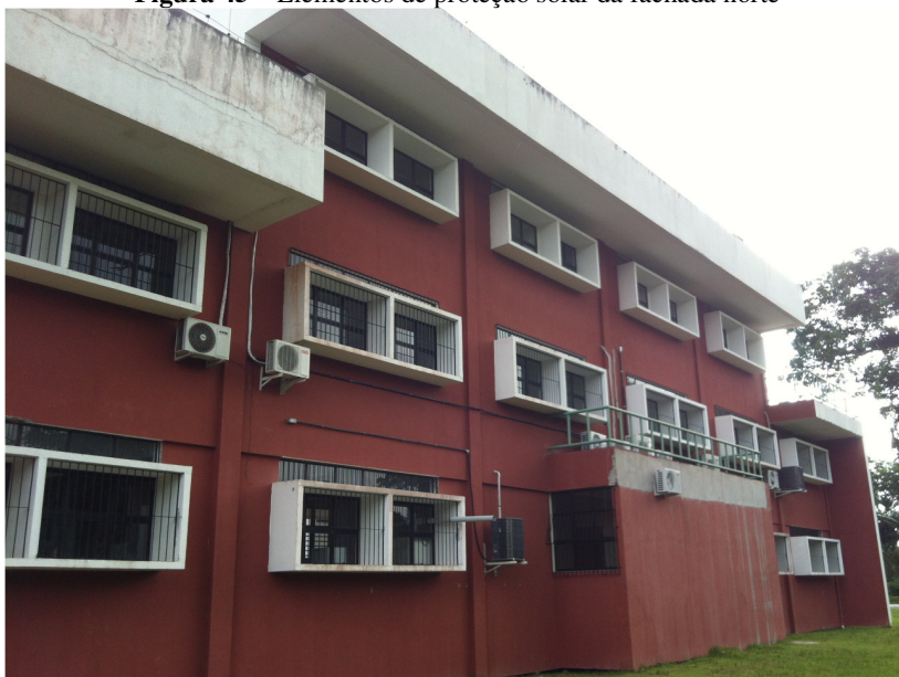
Figura 45 – Elementos de proteção solar da fachada norte
