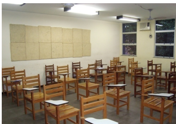
Figura 5.14 - Painéis de sisal (4,45 m 2 de área) colocados na parede do fundo da sala.
