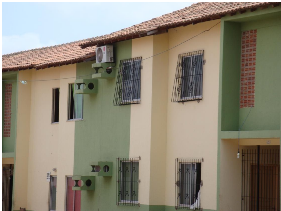
Figura 44 – Destaque dos Elementos da Fachada do Conjunto Habitacional. Fonte: Melo (2014).
