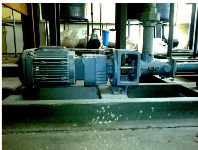
**Figura 16:** Sistema de bombeamento (bomba dosadora)
