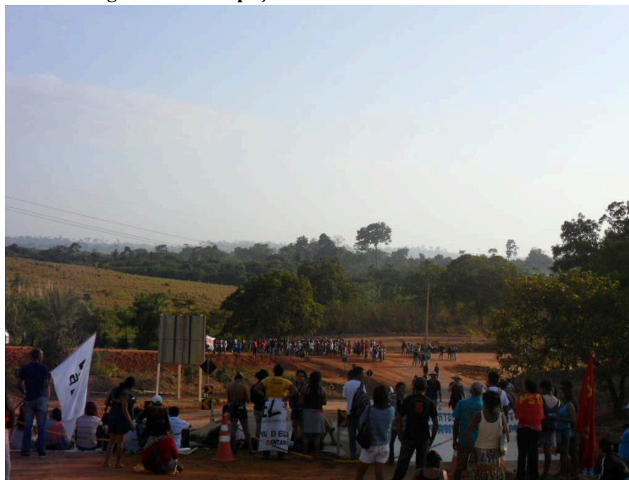
Fotografia 13 - Ocupação no canteiro de obras Belo Monte
