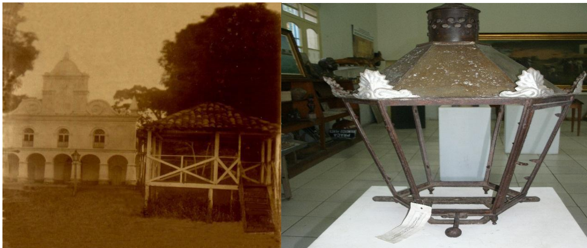
Figura 3: Poste que dependia de pessoas para acendê-lo (à esquerda) e sistema de iluminação pública rudimentar (à direita)
