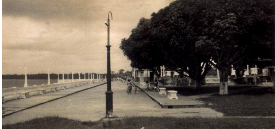
Figura 4: Poste de ferro referente ao sistema de iluminação pública movida a carbureto
