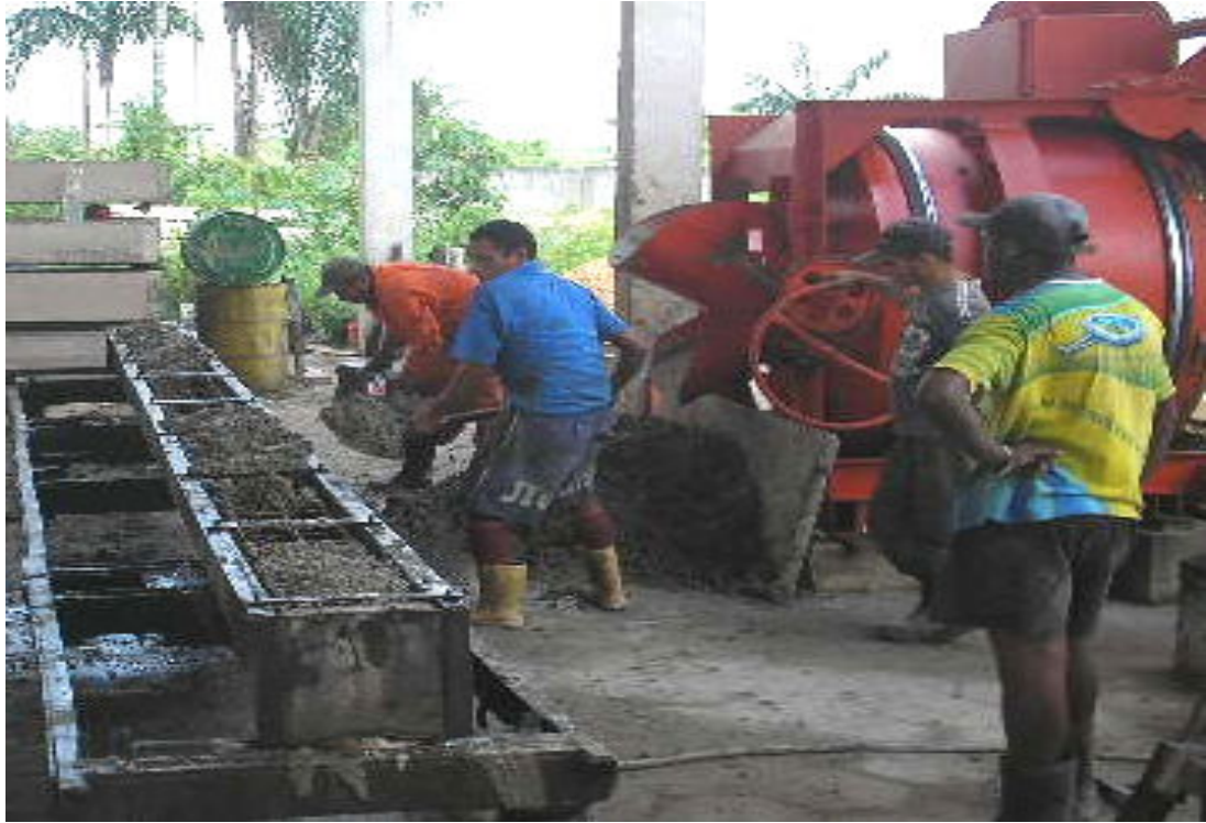
Figura 30: Lançamento do concreto nas fôrmas e vibração das mesmas.
