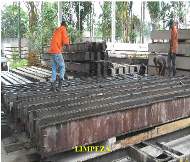
Figura 27: Preparação das fôrmas. Fonte: Barbosa, 2007.
