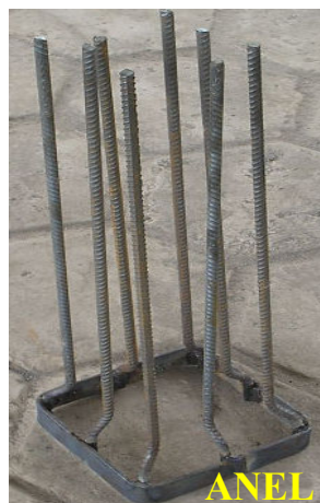
Figura 19: Resultado final do processo de serralheria – anel. Fonte: Barbosa, 2007.
