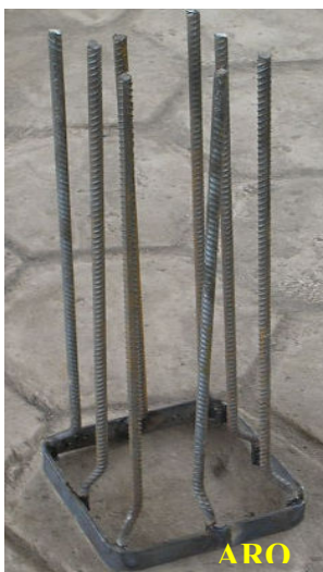
Figura 38: Ilustração de um anel com dimensões 20 x 20 cm. Fonte: Barbosa, 2007.
