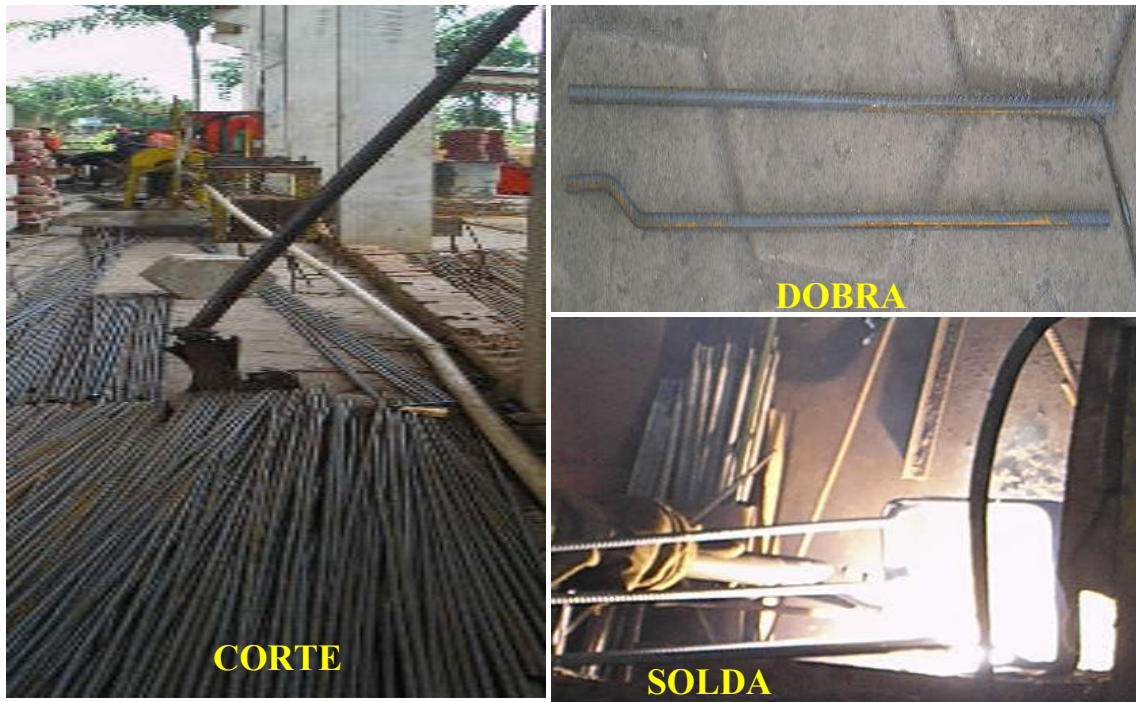
Figura 18: Segundo processo da serralheria com o corte, dobra e solda dos vergalhões no aro. Fonte: Barbosa, 2007.
