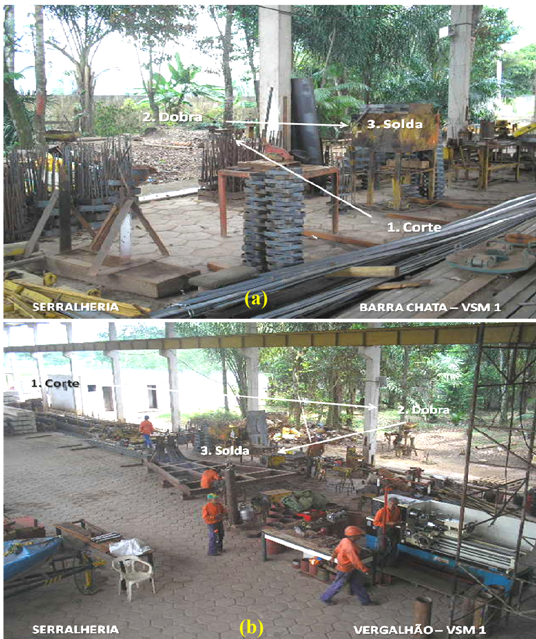
Figura 39: Deslocamentos quanto ao processo de corte, dobra e solda da barra chata (a) e corte, dobra e solda dos vergalhões (b).
