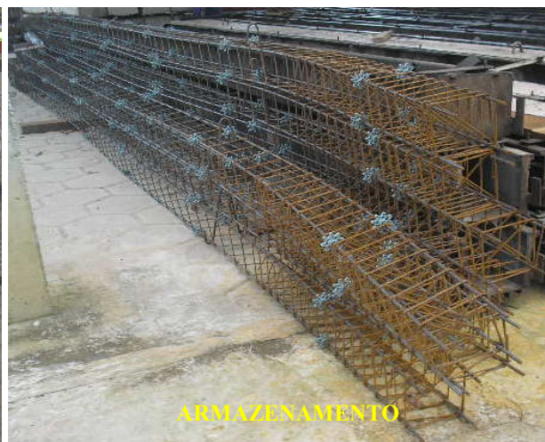
Figura 25: Montagem e armazenamento de armaduras.
