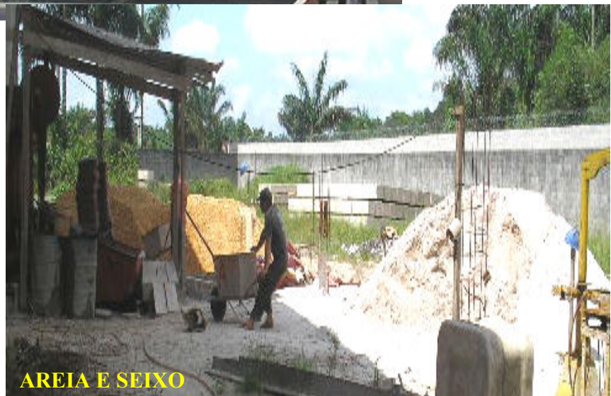
Figura 29: Carregamento da betoneira. Fonte: Barbosa, 2007.
