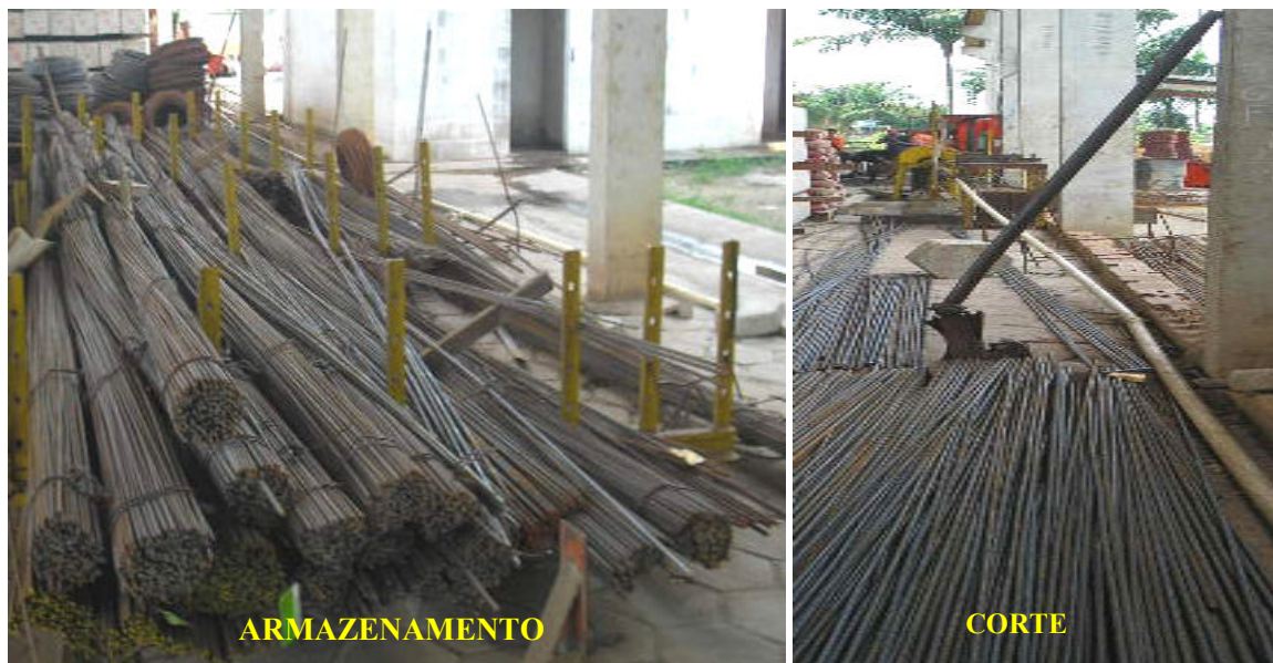
Figura 21: Armazenamento da matéria-prima e local de corte para fabricação das armaduras. Fonte: Barbosa, 2007.
