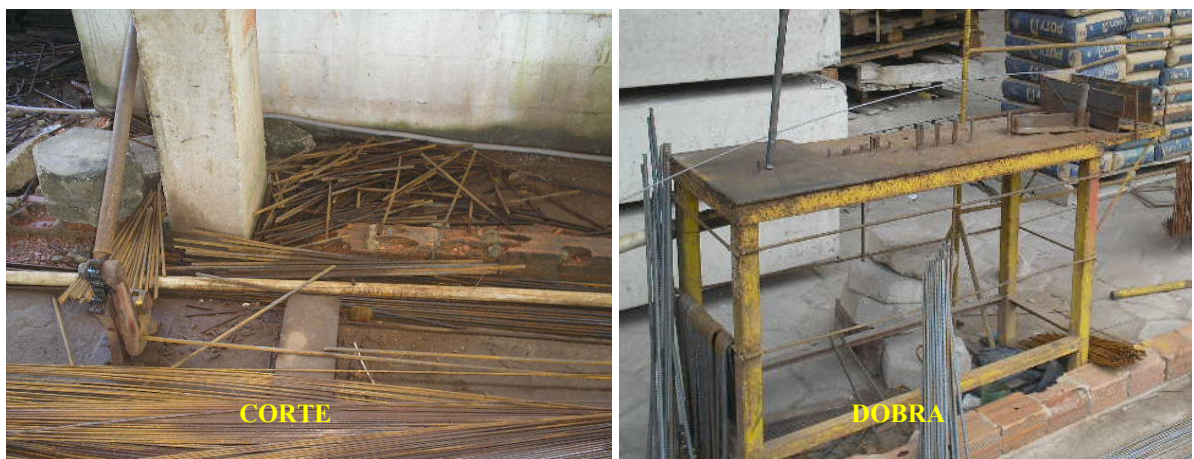
Figura 23: Local de corte e dobra para fabricação das alças. Fonte: Barbosa, 2007.
