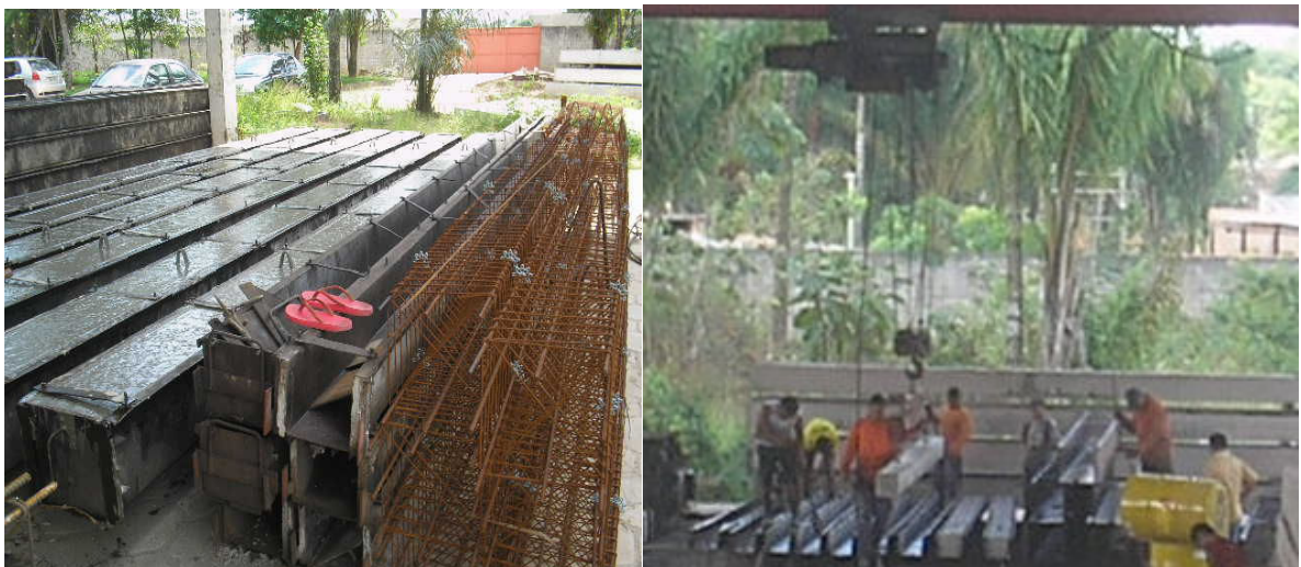
Figura 31: Fôrmas em processo de cura do concreto e içamento das estacas.
