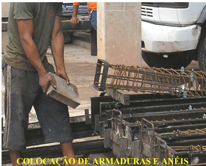
Figura 28: Montagem das fôrmas. Fonte: Barbosa, 2007.
