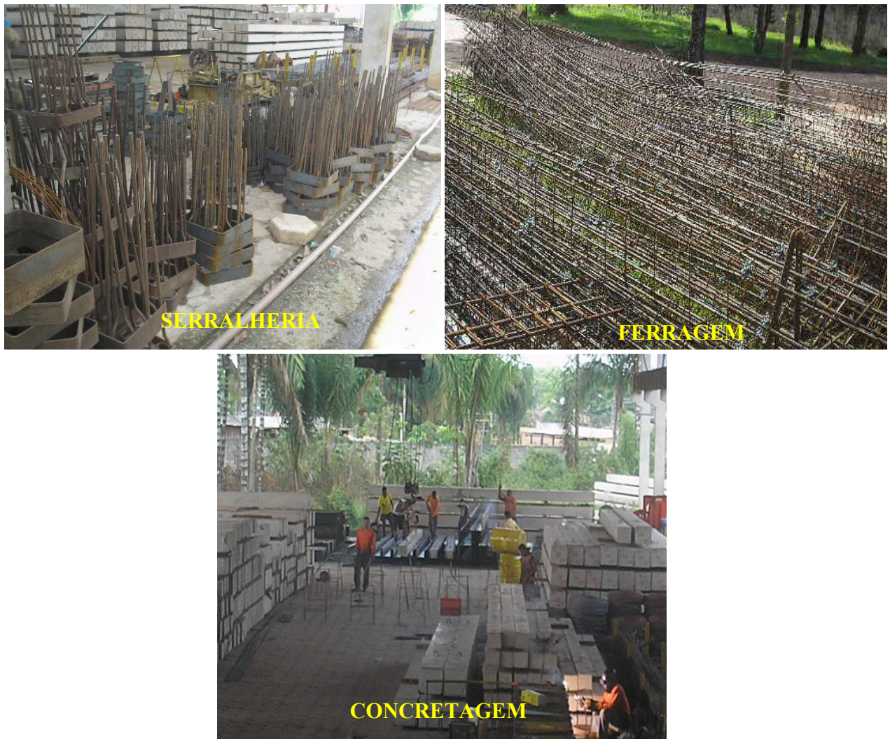
Figura 33: Estoques dos processos de produção de estacas pré-moldadas. Fonte: Barbosa, 2007.
