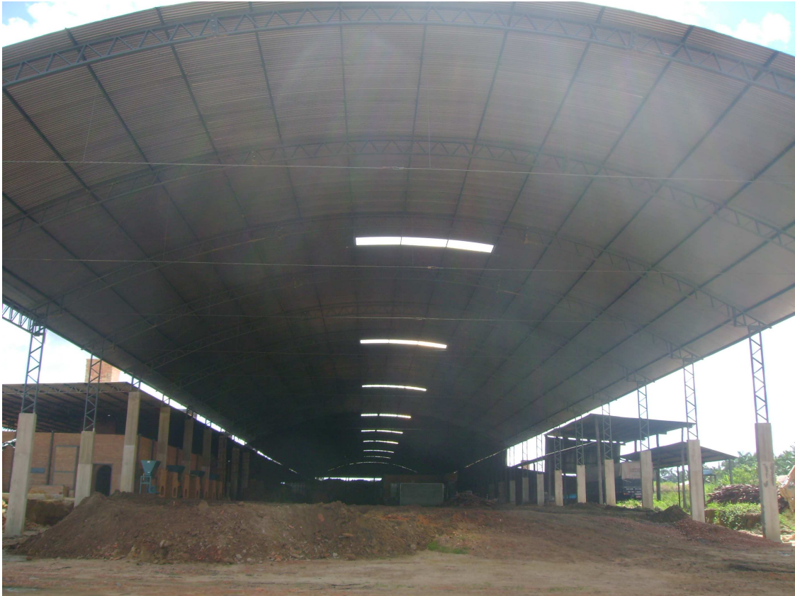
FIGURA 8.10 – Galpão construído na cerâmica Gama LTDA para estocagem de biomassa Fonte: Cerâmica Gama LTDA
