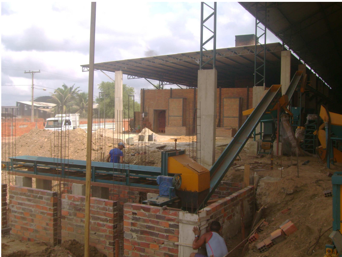
FIGURA 8.13 – Construção do silo do automatismo de queima Fonte: Cerâmica Gama LTDA
