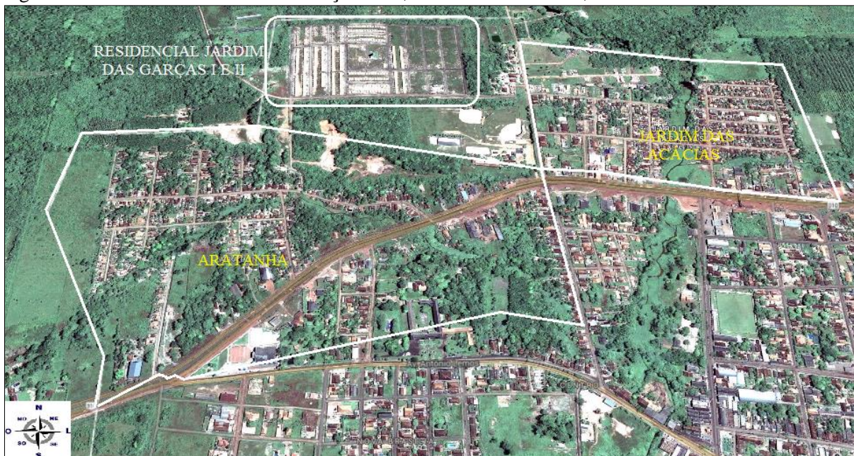
Figura 27 – Residencial Jardim das Garças I e II, Santa Isabel do Pará, Pará.
