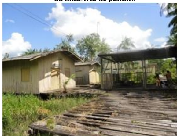
Figura 14 - Imagem dos prédios auxiliares da indústria de palmito
