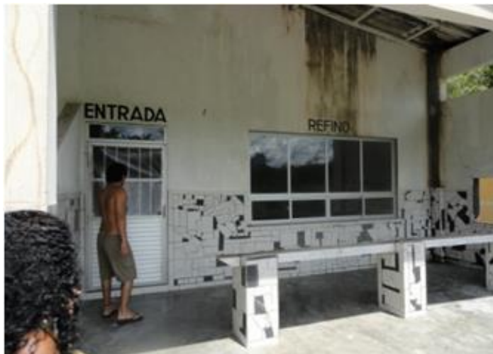
Figura 12 - Imagem do prédio principal da indústria
