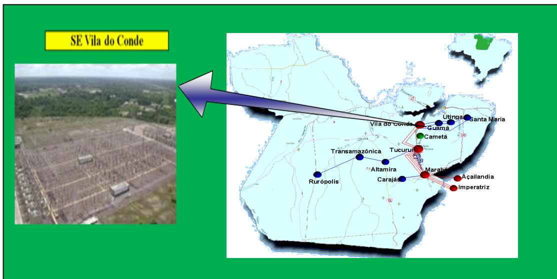
Fig.01. Subestação Vila do Conde–Eletronorte
