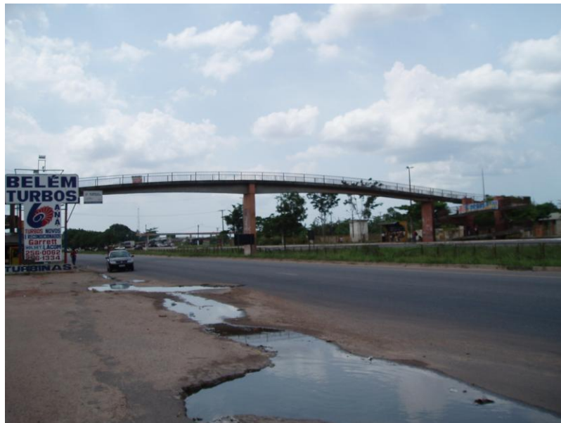
Fotografia 62 – Marituba – BR 316 - Passarela com rampa (fotografia anterior).
