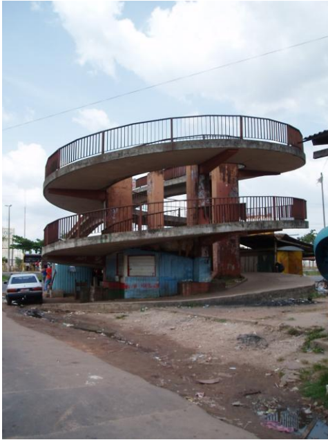
Fotografia 61 – Marituba – BR 316 – Rampa de passarela.
