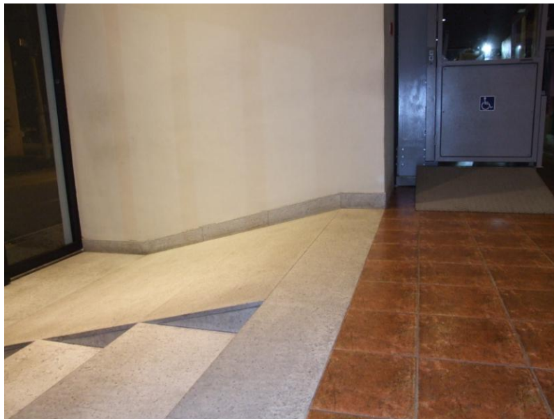
Fotografia 37 – Belém - Pólo Joalheiro - Piso antiderrapante, rampa e elevador especial.
