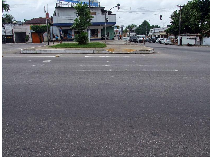
Fotografia 11 – Belém - Av.João Paulo II – Calçada rebaixada (canteiro entre pistas).
