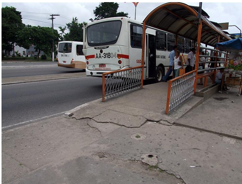
Fotografia 29 – Belém (S. Braz) - Av. José Bonifácio – Parada com piso elevado.
