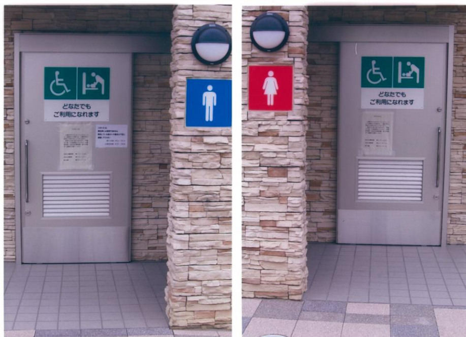
Fotografia 92 – Japão – Cidade de Hamamatsu – Banheiros para pessoas com necessidades especiais.
