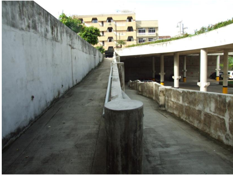
Fotografia 5 – Belém (centro) - Largo da Palmeira - Rampa para o estacionamento.
