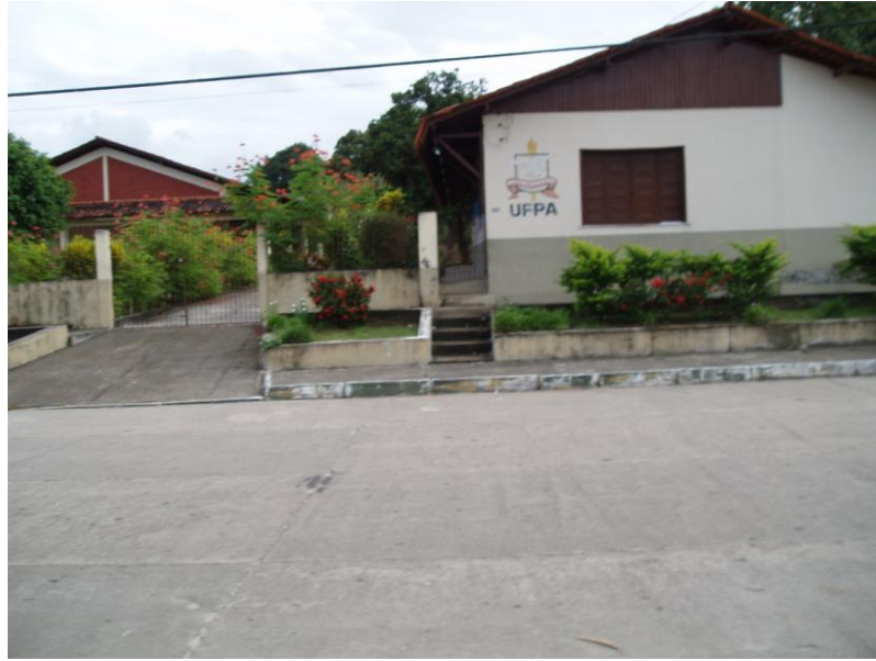
Fotografia 79 – Capanema – Rampa, degraus e desnível na calçada.
