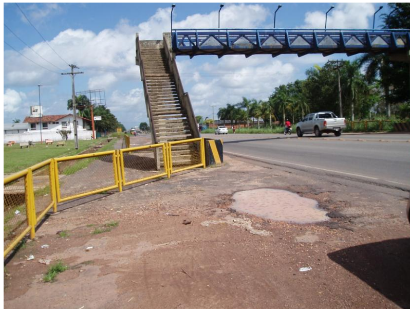
Fotografia 64 – Marituba – BR 316 – Passarela com rampa.
