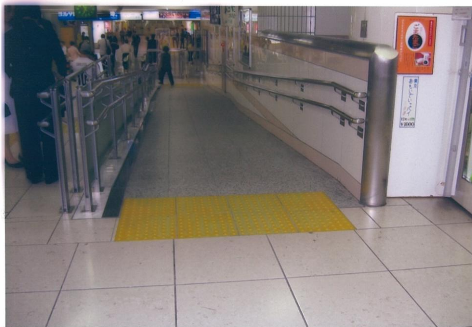
Fotografia 90 – Japão – Estação de Tokyo – Rampa para cadeiras de rodas.
