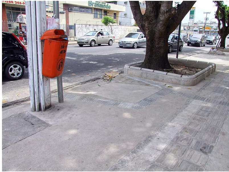
Fotografia 23 - Belém - Av Gov. José Malcher – Rebaixamento e piso diferenciados.
