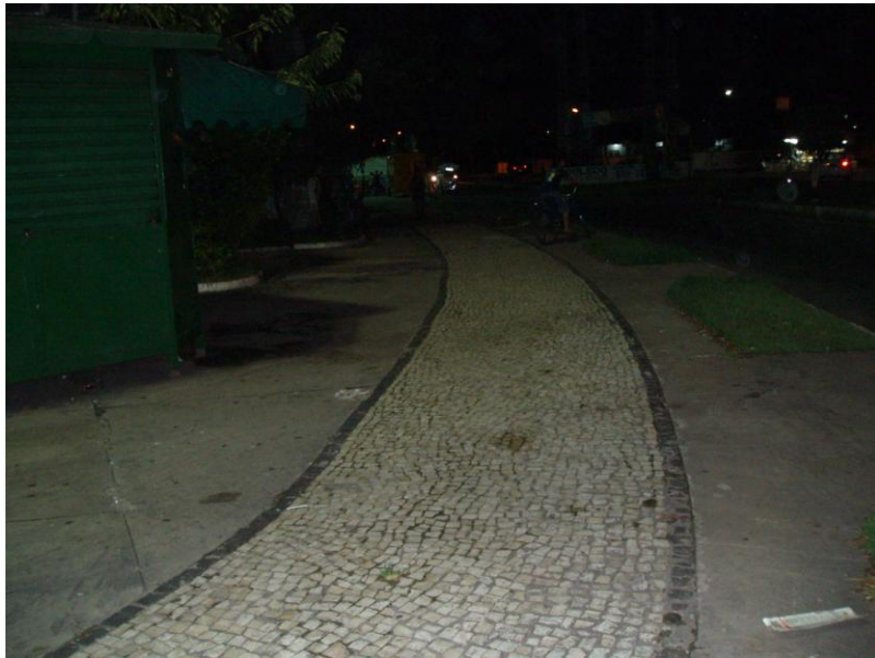
Fotografia 68 – Ananindeua – Piso diferenciado em uma praça.
