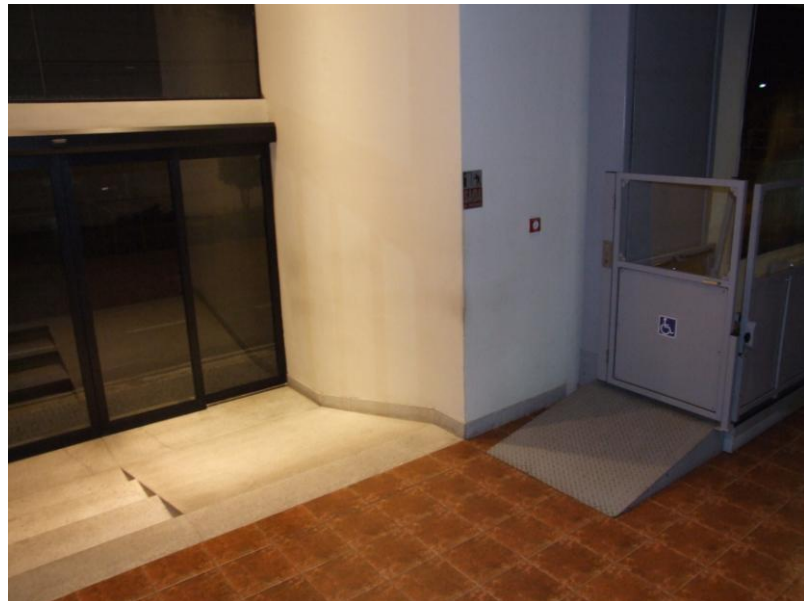
Fotografia 36 – Belém - Pólo Joalheiro – Degraus, rampa e elevador especial.
