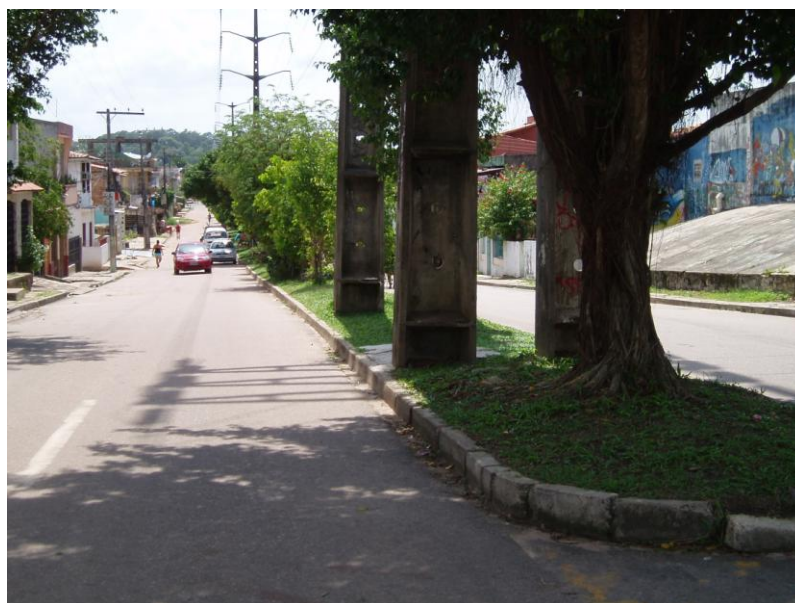
Fotografia 32 – Belém - Trav. Barão do Triunfo – Calçadas e canteiro inacessíveis.
