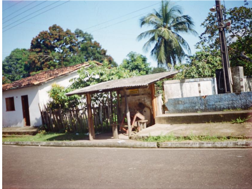
Fotografia 75 – Marapanim – Calçadas desniveladas.
