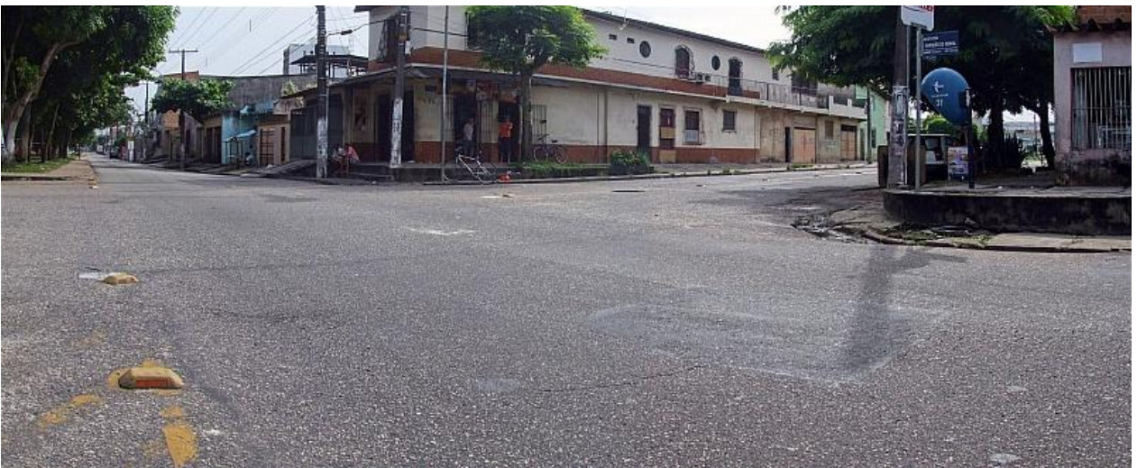
Fotografia 51 (panorâmica) – Belém - Av. Marquês de Herval – Calçadas altas e desniveladas.
