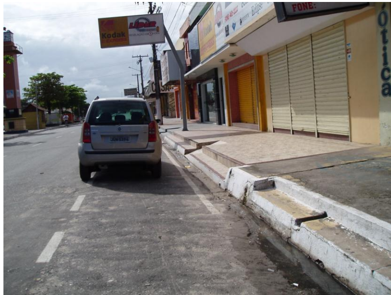
Fotografia 76 – Capanema – Degraus nas calçadas.
