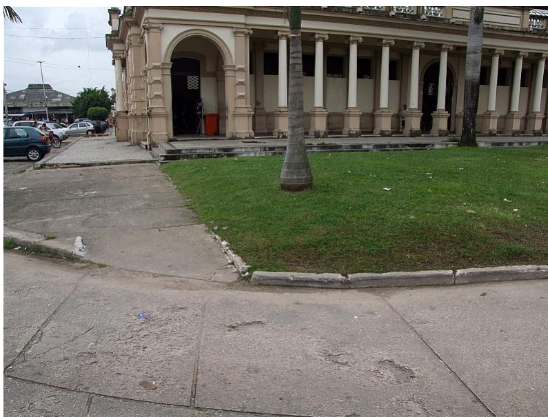
Fotografia 30 – Belém (S. Braz) - Piso acessível e degraus na calçada.
