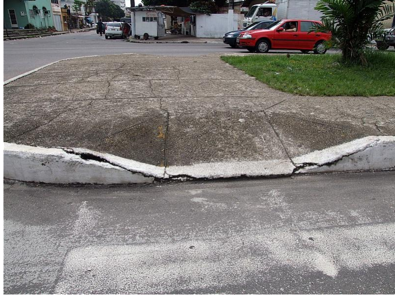
Fotografia 9 – Belém - Av. João Paulo II - Calçada rebaixada (canteiro entre pistas).
