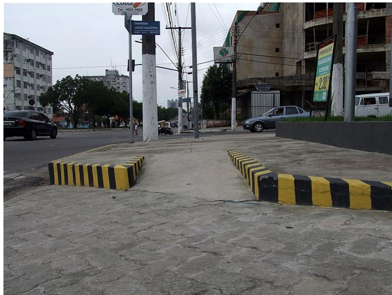
Fotografia 10 – Belém - Av. João Paulo II - Calçada rebaixada.
