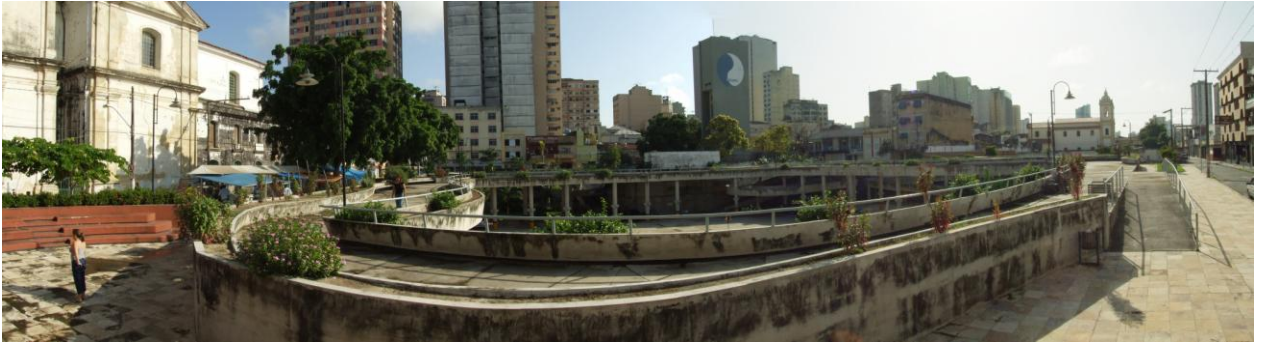
Fotografia 49 (panorâmica) – Belém - Largo da Palmeira – Calçadas e rampas.
