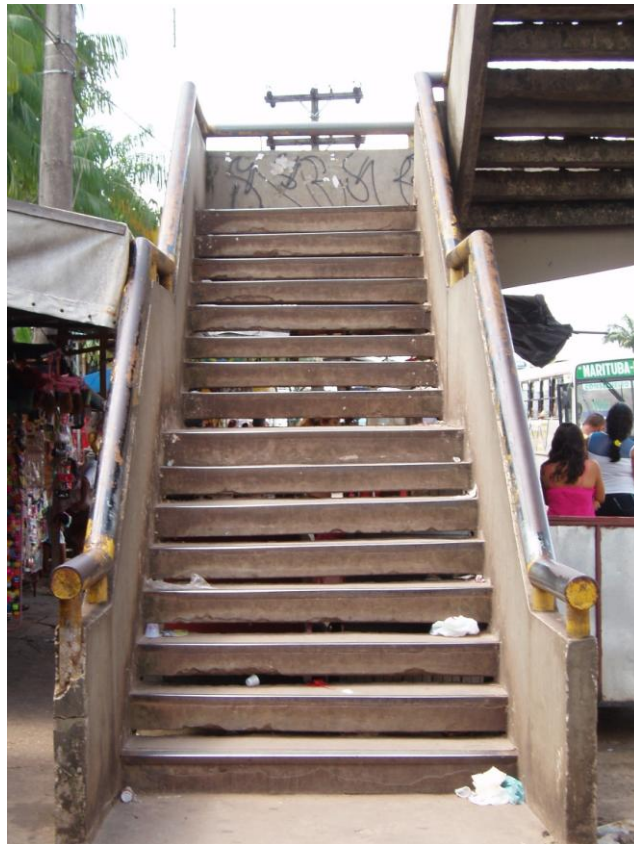
Fotografia 66 – Ananindeua – BR 316 – Escada de uma passarela.
