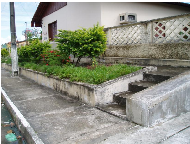
Fotografia 78 – Capanema – Calçada em desnível e com degraus.
