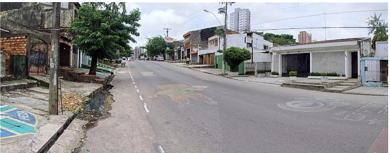
Fotografia 60 (panorâmica) – Belém - Av. Conselheiro Furtado – Calçadas desniveladas.
