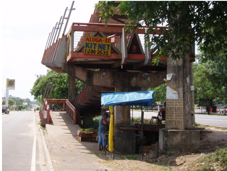
Fotografia 63 – Marituba – BR 316 - Rampa de uma passarela.
