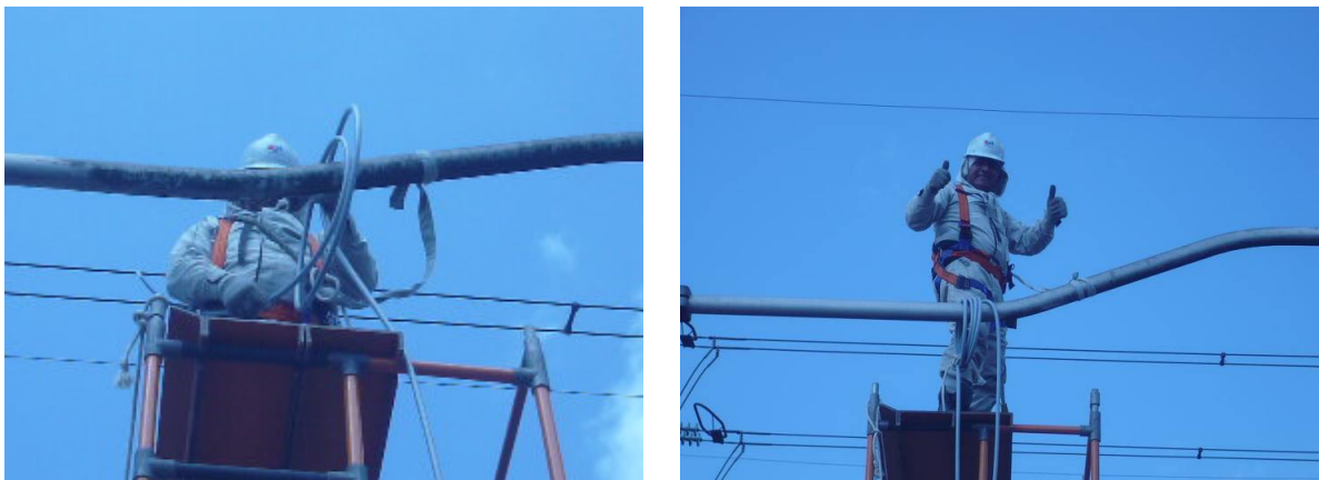
Figura 37 – Instalação do laço sensor de fibra ótica ao barramento energizado
