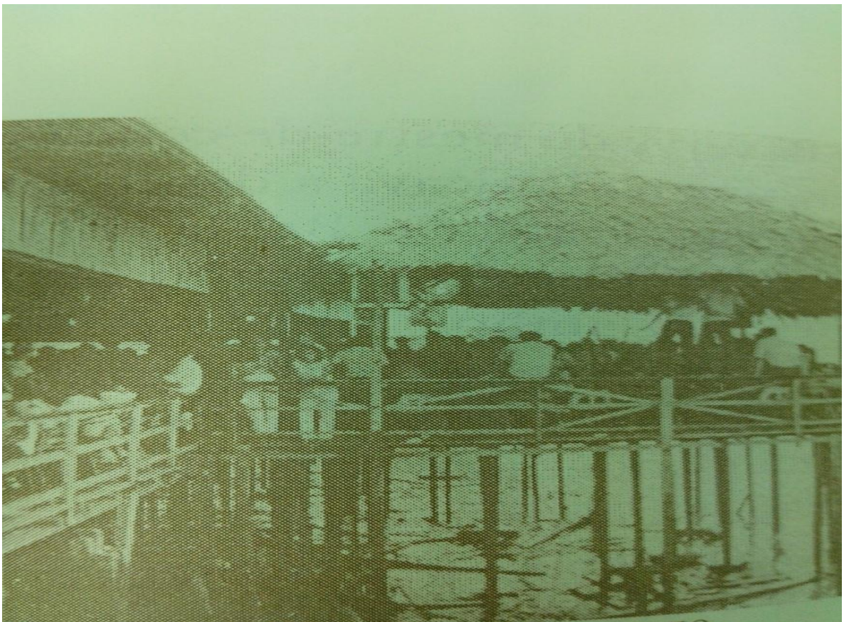
Vista da palafita do Palácio dos Bares sobre o rio Guamá – parte de trás do bar. Fonte: LARÊDO, op. cit. p. 254.
