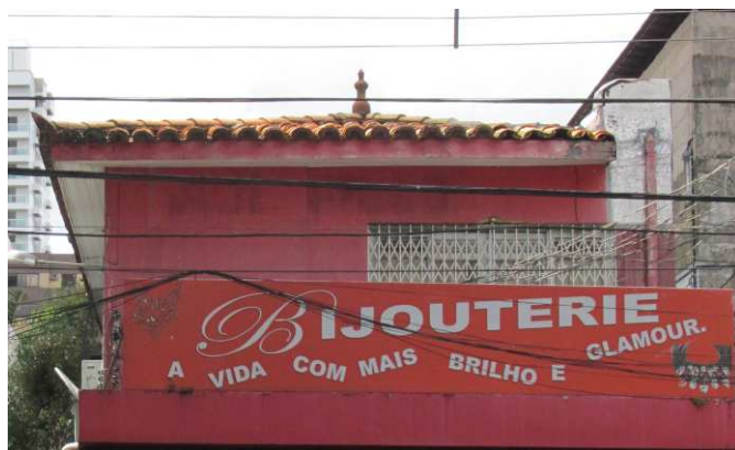
DET. 02: A edificação possui cobertura com telha capa canal, com rabo de andorinha e um pináculo, além disso, o beiral possui forro de PVC. A esquadria presente no 1º pavimento é de madeira e vidro, estilo veneziana, com grades de ferro sanfonadas. Foto: Bianca Barbosa do Nascimento, 2014.
