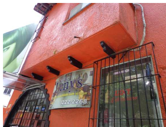
DET. 04: Cachorros presentes abaixo da extrusão de uma das paredes da fachada principal. É possível preceber também a textura chapiscada da parede. Foto: Bianca Barbosa do Nascimento, 2014.
