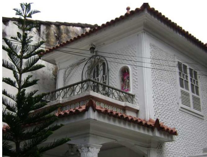
DET. 01: Detalhe da sacada da edificação. O guarda corpo é simples, parte em alvenaria com azulejos e parte com gradil de ferro com ornamentação simples. Foto: Bianca Barbosa do Nascimento, 2014.
