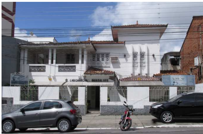
FOTO 01: Fachada principal da residência nº 2128. Atualmente, o uso da edificação está destinado ao funcionamento de um laboratório de análises clínicas.
