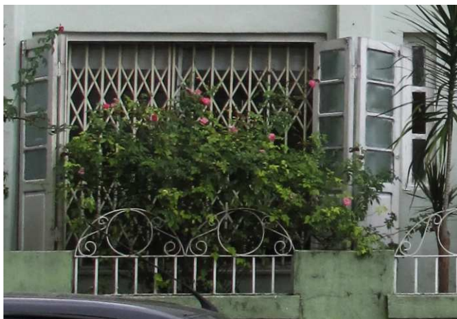
DET. 04: Janela de madeira e vidro com grade sanfonada, além da presença de um esquadria fixa de madeira e vidro à direita da imagem.
