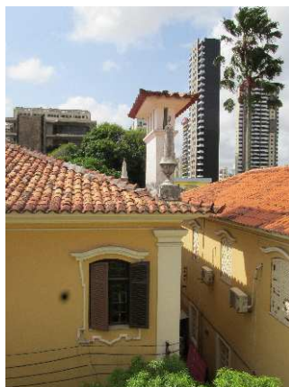
DET. 15: Detalhe da chaminé e de um dos pináculos presentes na cobertura do prédio pioneiro.
