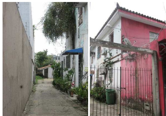
DET. 03 e 04: Imagens da lateral do edifício. O lote possui um recuo posterior, sendo que nos fundos desse terreno há uma edícula. A edificação também possui outras esquadrias posicionadas na fachada lateral, que podem variar entre balancins de ferro e vidro e janelas de madeira e vidro. Todas essas esquadrias possuem grades de ferro para eventual proteção. Fotos: Bianca Barbosa do Nascimento, 2014.
