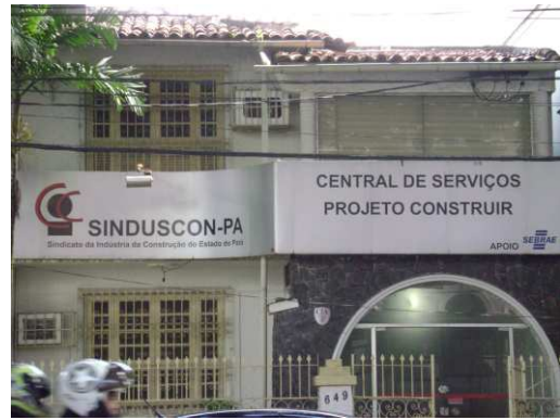
DET. 03: Detalhe da parte da fachada principal, onde é possível notar a composição de cobertura com telha capa canal, o arco de acesso com parede texturizada e parte das esquadrias de madeira e vidro, com quatro folhas, estilo persiana.
