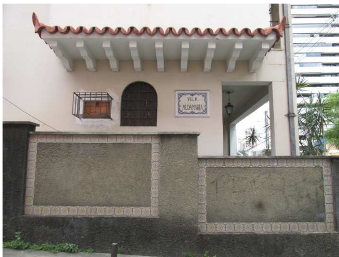
DET. 05: Parte da fachada lateral com elementos que remetem a arquitetura neocolonial, com os azulejos presentes no muro e na parede lateral, na sequência de cachorros abaixo dos detalhes com telha capa canal.
