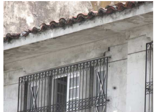
DET. 08: Ornamento feito com argamassa, que se assemelha com uma moldura, presente acima da esquadria de madeira e vidro.
