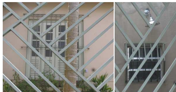
DET. 04: Diferentes tipos de esquadrias presentes na edificação. À esquerda, uma esquadria de quatro folhas, de madeira e vidro, estilo veneziana. E à direita, uma janela basculante com estrutura de alumínio e vedação em vidro.
