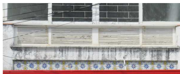
DET. 04: Azulejos presentes abaixo de uma das esquadrias da fachada principal.
