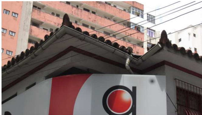
DET. 01: A cobertura é feita com telhas capa canal, possui rabo de andorinha nas extremidades. O beiral possui forro de gesso e uma calha.
