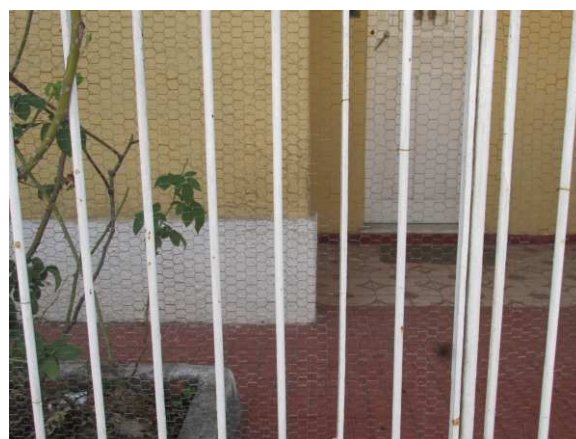
DET. 06: Embasamento com textura chapiscada na fachada principal do edifício.
