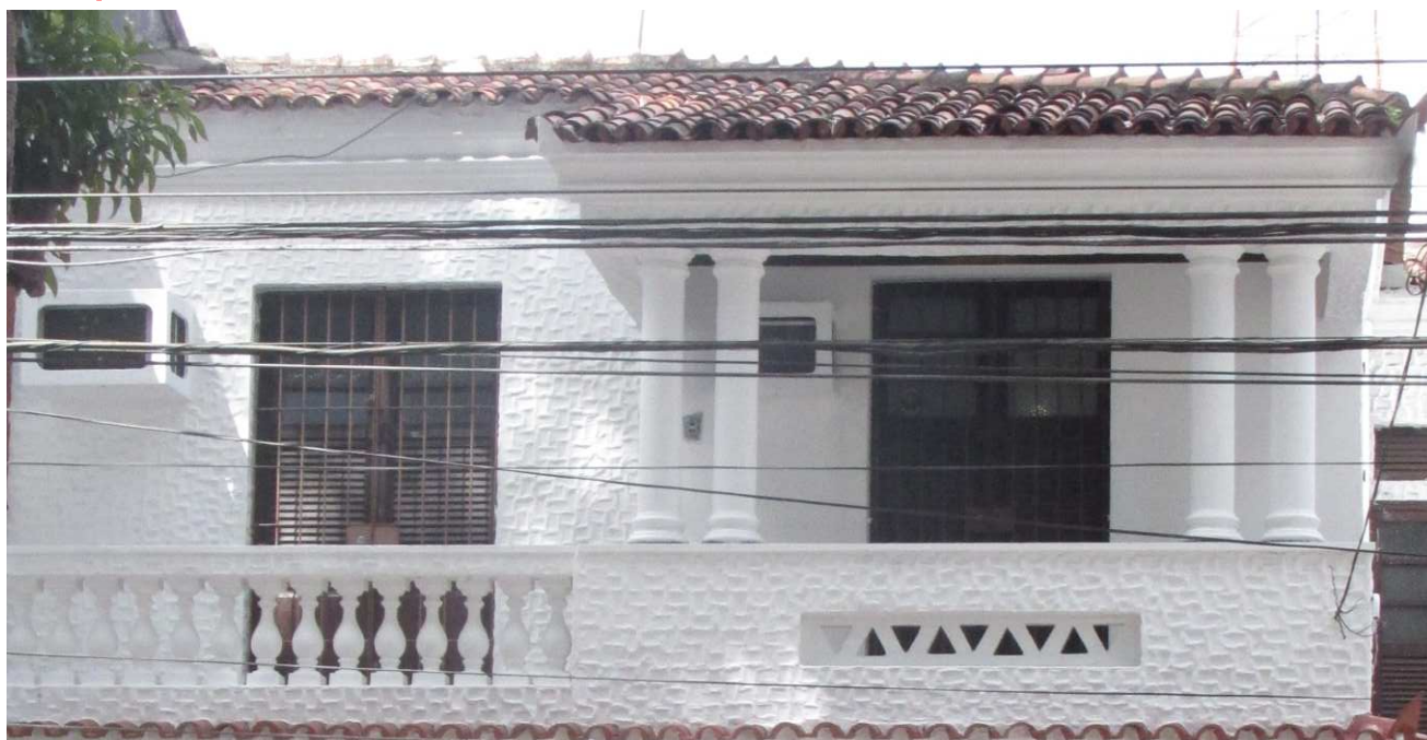
DET. 07: No 1º pavimento da residência há uma varanda e uma sacada. O guarda corpo da varanda possui elementos geométricos vazados, enquanto o da sacada é composto por uma balaustrada.
