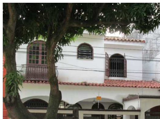
DET. 02: Detalhe de parte da fachada principal, onde há esquadrias de madeira e vidro, além de um balancim. A edificação possui um pequena sacada com guarda corpo em ferro boleado. Também é possível notar a composição de cobertura com telhas capa canal
