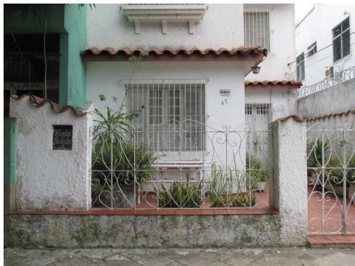
DET. 04: Muro chapiscado com gradio de ornamentação simples e ornamentação com telha capa e canal. Foto: Bianca Barbosa do Nascimento, 2014.
