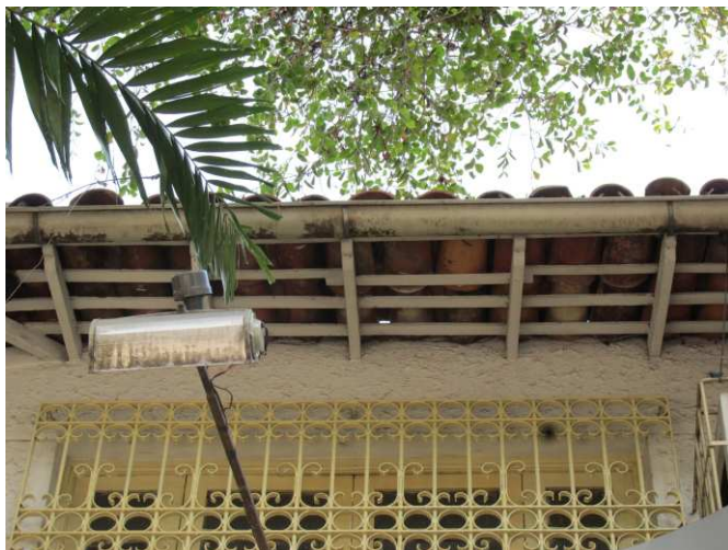
DET. 06: Detalhe de parte do beiral da cobertura de telha capa e canal, onde estão localizados dos cachorros de madeira.
