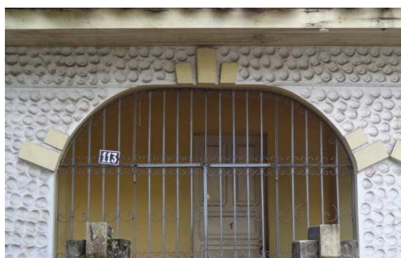
DET. 04: Detalhe em argamassa que remete a rusticidade da pedra, presente na arcada. Foto: Amanda de Paula Bentes Pessoa, 2014.
