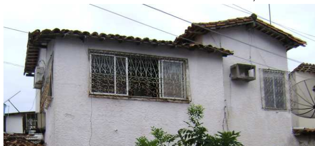
DET. 02: Detalhe de parte da cobertura, onde é possível perceber a composição da cobertura. As esquadrias utilizadas na residência são em maioria de alumínio e vidro. A maior parte delas possui gradil de ferro. As janelas são de correr e possuem de duas a quatro folhas.
