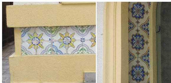
DET. 06 e 07: Detalhe dos azulejos citados acima. No DET. 06, os azulejos presentes no embasamento, e no DET. 07, os azulejos presentes nos arcos da residência.
