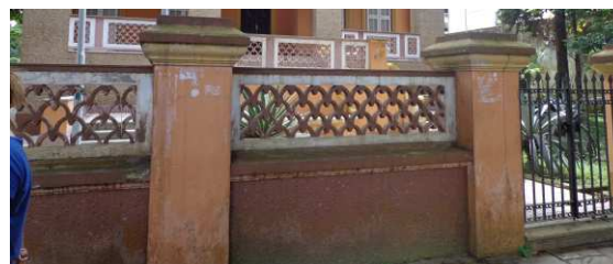
DET. 11: Detalhe de parte do muro da edificação. O muro possui elementos vazados em argamassa, além do gradil de ferro com ornamentação simples.
