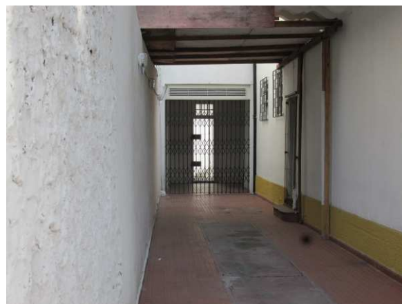
DET. 03: Detalhe do recuo lateral da edificação, que serve como garagem da residência.
