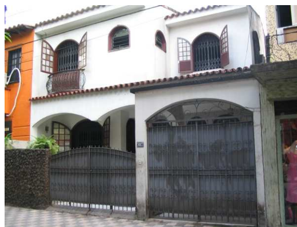
DET. 03: Imagem da edificação feita há dez anos atrás, antes da intervenção que modificaria o muro. Foto: Acervo DPHAC, 2004.
