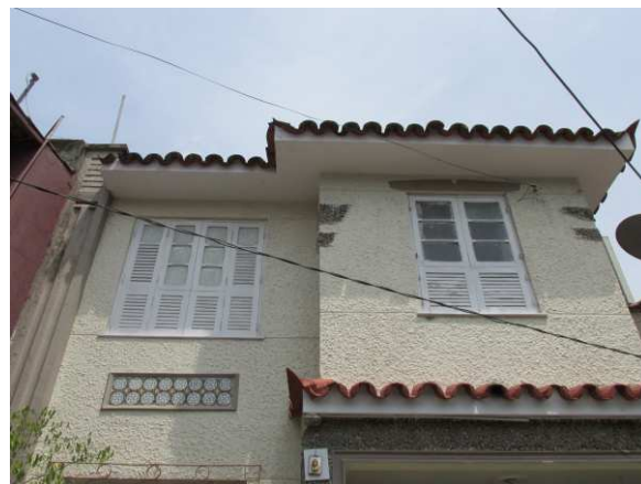
DET. 06: Detalhe das esquadrias presentes na fachada principal. Elas são de madeira pintada de branco, estilo venezianas, sendo uma delas com duas e a outra com quatro folhas. Também é possível ver o detalhe do beiral que é revestido com um forro de argamassa. Foto: Bianca Barbosa do Nascimento, 2014.
