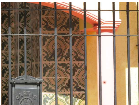
DET. 01: Coluna toscana apoiando uma varanda na parte térrea da edificação.
