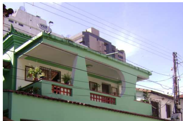
DET. 02: Varanda de edificação com pilares mais característicos da arquitetura moderna, e com guarda corpo de alvenaria e cobogós. Foto: Felipe Moreira Azevedo, 2013.
