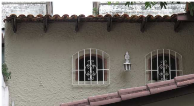
DET. 06: Detalhe de uma parte da parede externa chapiscada, com a presença de duas esquadrias de arco abatido com gradil, e uma arandela. Também é perceptível o uso de telha capa canal na cobertura.
