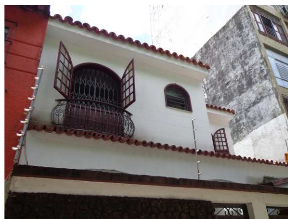
DET. 04: Detalhe de parte da fachada principal, onde é possível ver a grade sanfonada presente na esquadria.
