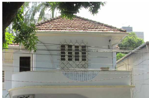
DET. 03: A cobertura da residência é feita com telha francesa. As janelas utilizadas são de madeira e vidro, estilo venezianas, com duas folhas, além da grade de ferro treliçada. A edificação também possui uma sacada, cujo guarda corpo é de alvenaria com detalhes em gradil de ferro.
