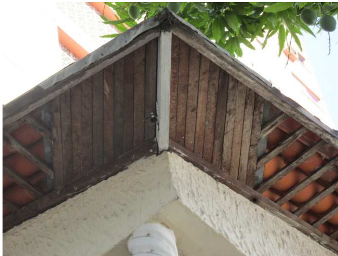
DET. 05: Parte do beiral, que antes possuía uma vedação de madeira e que atualmente está deteriorada. Foto: Bianca Barbosa do Nascimento, 2014.
