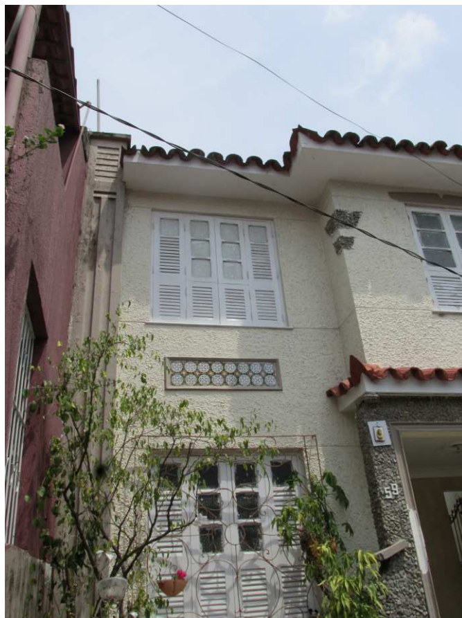
DET. 06: Detalhe das esquadrias presentes na fachada principal. Elas são de madeira pintada de branco, estilo venezianas, sendo uma delas com duas e a outra com quatro folhas. Também é possível ver o detalhe do beiral que é revestido com um forro de argamassa. Foto: Bianca Barbosa do Nascimento, 2014.
