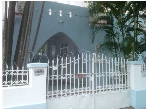
DET. 04: Detalhe do muro da edificação que é de alvenaria e possui ornamentação com gradis de ferro simples pintado de branco. Foto: Acervo DPHAC, 2012.
