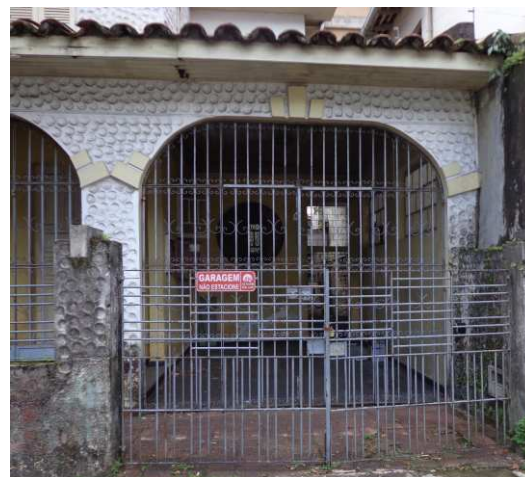
DET. 09: A casa apresenta gradil vazado e simples, tanto no muro, quanto na própria edificação. Presença de garagem e recuo lateral.
