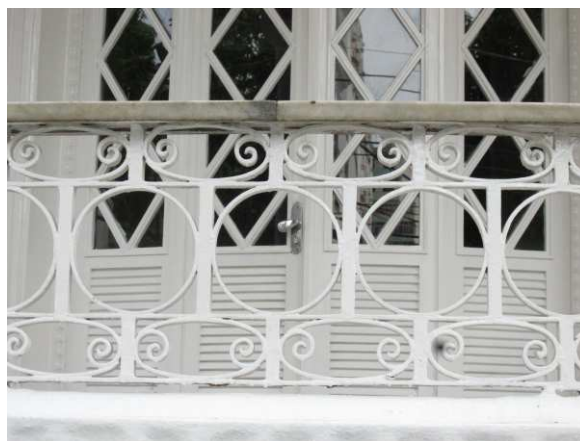
DET. 11: Detalhe do gradil de ferro, pintado de branco, presente no guarda corpo da sacada. Foto: Bianca Barbosa do Nascimento, 2014.
