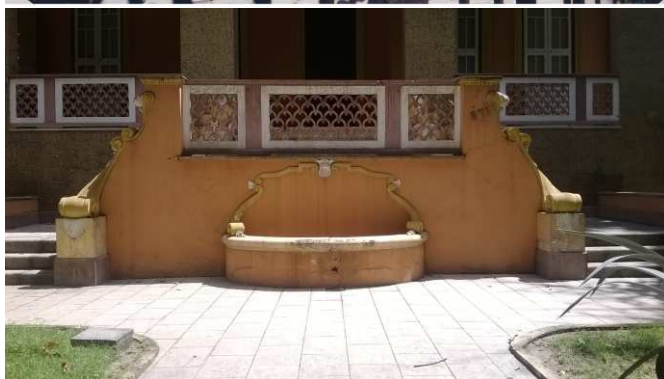
DET. 05 e 06: Detalhe da fonte presente na fachada da edificação. Antes da reforma feita para a adequação ao seu uso atual, a fonte possuía um painel azulejado em tons de amarelo. Após a reforma, houve a retirada desses painéis e a fonte não possui mais as suas características originais.
