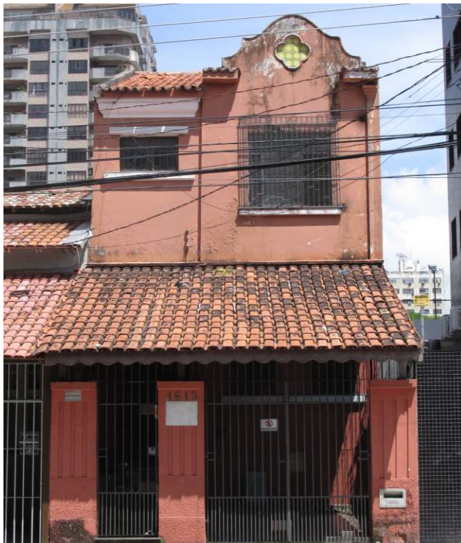
FOTO 01: Fachada principal da residência. A edificação é compacta, possui composição de cobertura com telha plan. Apenas o embasamento possui textura chapiscada, o restante das paredes tem acabamento liso na cor salmão. A residência não apresenta boas condições de conservação.
