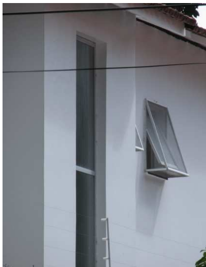
DET. 05 e 06: Diferentes tipos de janelas presentes em uma das edificações. No DET. 05 há existem esquadrias de alumínio e vidro, sendo uma delas fixa e a outra basculante. Já no DET. 06, há uma esquadria de madeira e vidro com grade sanfonada.
