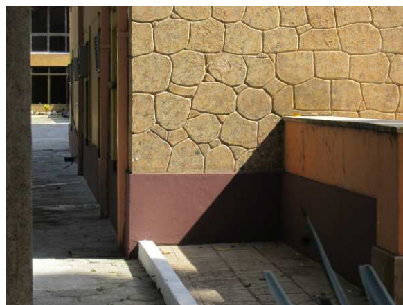
DET. 04: Detalhe de parte da parede da fachada principal onde há a aplicação de uma textura de pedras feita com cimento. Diferentemente do resto da parede, o embasamento da edificação é liso, ou seja, não possui textura.
