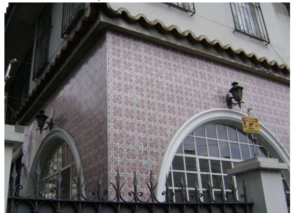
DET. 03: Na parte térrea da residência, há duas paredes azulejadas onde encontram-se dois arcos. Acredita-se que as esquadrias de ferro e vidro que fazem a vedação desses arcos, são resultantes de uma intervenção posterior ao período de construção.
