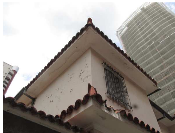
DET. 04: Detalhe de parte da fachada lateral, onde é possível ver parte da cobertura com telha capa canal e com rabo de andorinha, do beiral com argamassa e dos detalhes com telha capa canal e rabo de andorinha presentes entre o térreo e o 1º pavimento que remetem a uma composição de cobertura. Foto: Bianca Barbosa do Nascimento, 2014.
