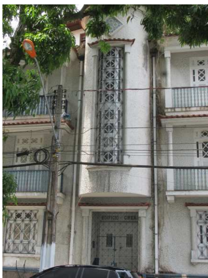
DET. 05: Torre presente em uma das fachadas da edificação. Ela possui elementos como a coluna torsa, esquadrias treliçadas e detalhes com telha capa canal e azulejos.
