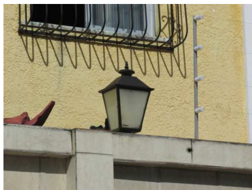
DET. 02: Arandela fixada na fachada principal, ao fundo nota-se a textura chapiscada da parede do edifício.
