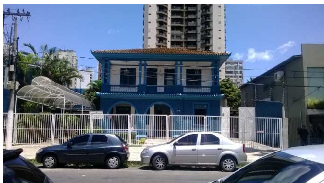
FOTO 01: Fachada principal da edificação. Foto: Bianca Barbosa do Nascimento, 2014.
