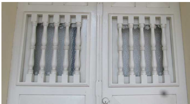
DET. 07: Detalhe presente em uma das portas de acesso à residência. O 'olho mágico português', composto por uma abertura na folha, vedada por vidro e ornamentado com pequenos balaústres. Foto: Bianca Barbosa do Nascimento, 2014.
