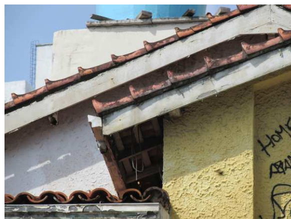
DET. 02: Detalhe da parte da composição da cobertura existente no edifício, além de parte da parede da fachada principal que possui textura chapiscada.
