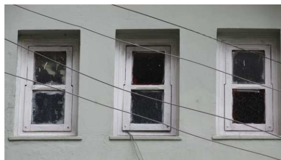
DET. 07: Detalhe das janelas basculantes de madeira e vidro, com uma folha.
