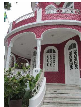
DET. 04 e 05: Detalhe da varanda presente no térreo. Além da textura recorrente da parede, existe também um embasamento de argamassa imitando pedra. Ao longo da varanda, também é possível notar a presença de colunas torças. O guarda corpo é de alvenaria e possui ornamentação com grades de ferro vazado pintado de branco. Fotos: Bianca Barbosa do Nascimento, 2014.
