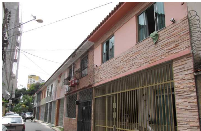
DET. 02: Casas geminadas da Vila Alda Maria vistas próximas da esquina com a Rua João Balbi. Foto: Bianca Barbosa do Nascimento, 2014.
