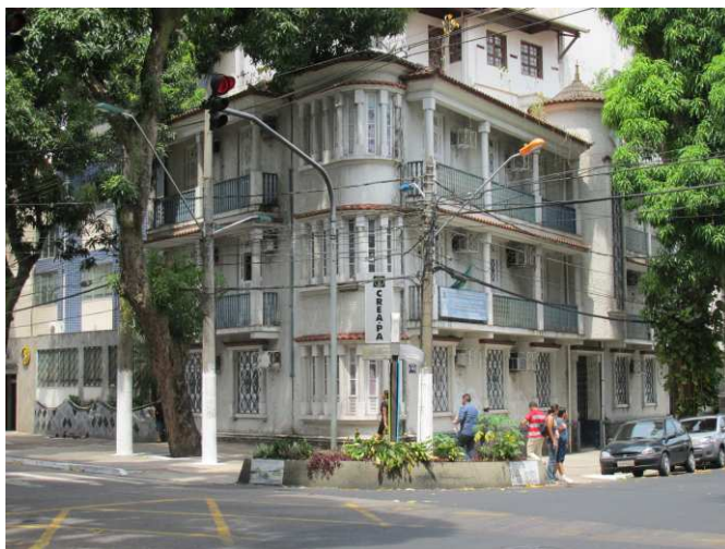
DET. 01: A edificação possui três pavimentos. Foi construída inicialmente para ser um edifício residencial multifamiliar. As suas fachadas possuem varandas contínuas e as paredes são chapiscadas.
