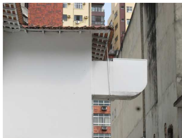
DET. 09: Estrutura criada em uma das paredes próximas do recuo lateral para atender as necessidades funcionais da edificação. Sua estrutura possui ligações com o madeiramento da cobertura do edifício.
