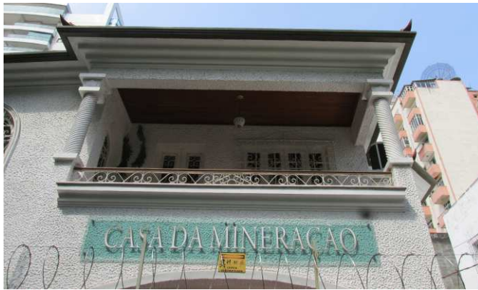
DET. 01: A varanda da edificação possui duas colunas torsas e o guarda corpo em alvenaria com gradil de ferro com ornamentação simples.
