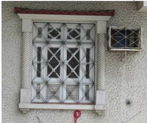
DET. 09: Detalhe de uma das janelas presentes no andar térreo. Com ela existe um gradil de ferro simples, também treliçado.
