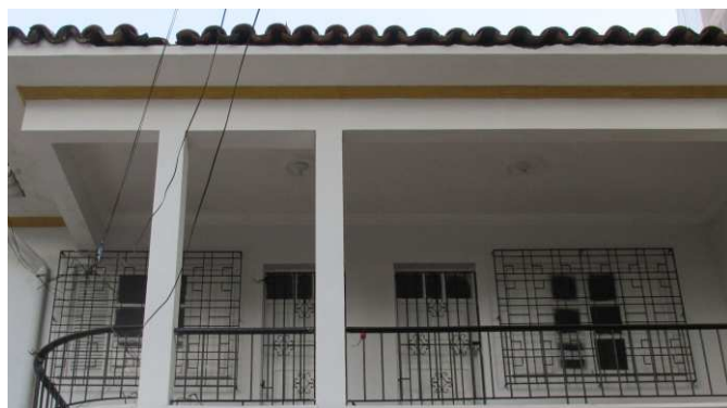
DET. 05: As esquadrias presentes na edificação são em sua maioria de madeira, pintada na cor branca, e vidro. As janelas são estilo venezianas, com quatro folhas, ambas possuem grades de ferro, com ornamentação geométrica. As portas possuem apenas uma folha Fotos: Bianca Barbosa do Nascimento, 2014.
