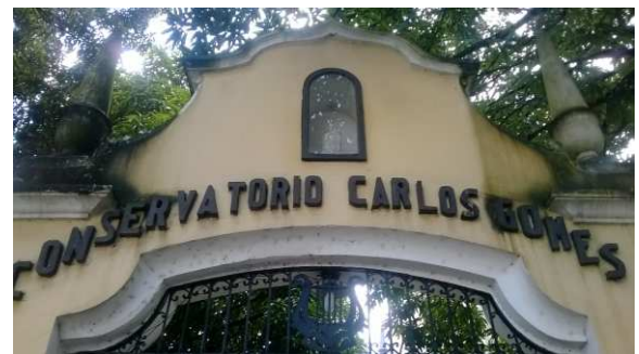
DET. 11: Detalhe da portada presente no muro. Nela está escrito o nome da instituição, além disso ela possui um nicho com uma imagem de Nossa Senhora. A portada também apresenta pináculos semelhantes aos encontrados na cobertura do prédio pioneiro
