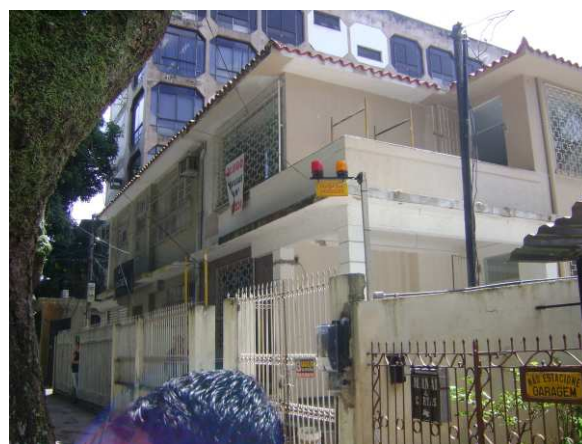
DET. 04: A edificação passou por intervenções que retiraram as suas esquadrias originais de madeira e vidro, por esquadrias fixas de vidro. As características originais que ainda predominam são a cobertura com telha capa canal e rabo de andorinha, além da sacada com guarda corpo em alvenaria. Foto: Giovana Maria do Nascimento Silva, 2014
