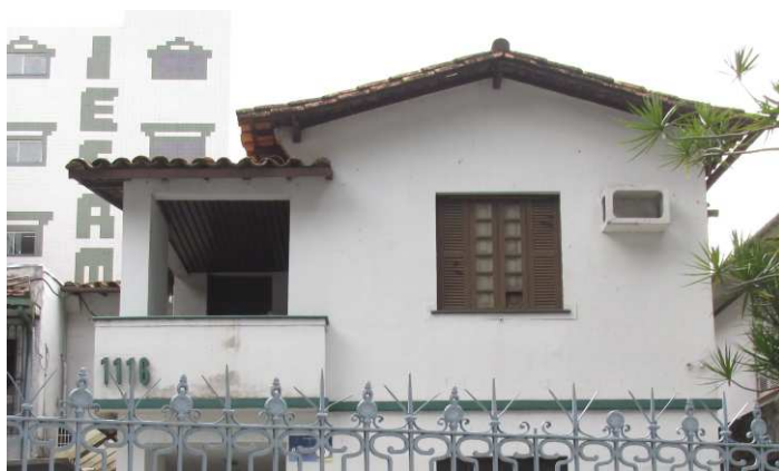
DET. 01: Detalhes de parte superior da fachada principal. A cobertura da edificação é composta por telhas capa canal com composição de cobertura. Não há elementos como rabo de andorinha ou pináculo. Quanto aos outros elementos da fachada, há uma janela de madeira, estilo veneziana, com quatro folhas e com vedação em vidro. A residência possui uma varanda com um guarda corpo simples em alvenaria. Fotos: Bianca Barbosa do Nascimento, 2014.
