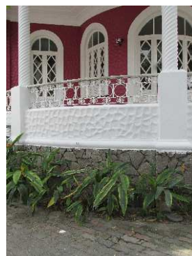
DET. 04 e 05: Detalhe da varanda presente no térreo. Além da textura recorrente da parede, existe também um embasamento de argamassa imitando pedra. Ao longo da varanda, também é possível notar a presença de colunas torças. O guarda corpo é de alvenaria e possui ornamentação com grades de ferro vazado pintado de branco. Fotos: Bianca Barbosa do Nascimento, 2014.
