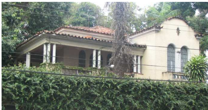
DET. 02: Detalhe da fachada voltada para a Av. Alcindo Cacela. Nela é possível perceber a composição da cobertura, o uso de telha capa canal e presença de varanda e frontão.
