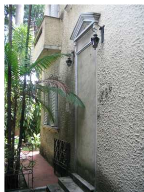
DET. 17: Intervenção realizada em uma das fachadas da residência, onde houve a vedação de um dos acessos ao interior da residência.
