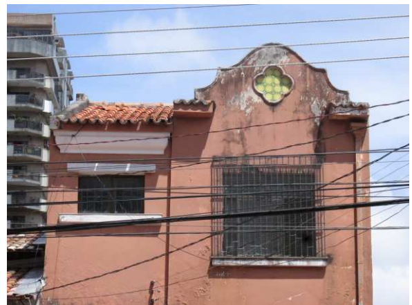
DET. 03: As esquadrias da edificação são de madeira não pintada e vidro. A porta de entrada do térreo possui almofadas e duas folhas, já as janelas presentes no 1º pavimento diferem-se em si. Uma das janelas possui duas folhas de correr e venezianas, enquanto as outras são basculantes com três folhas.
