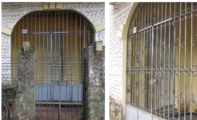
DET. 07: As portas presentes na edificação são de madeira e almofadadas, sendo que uma delas possui duas folhas.
