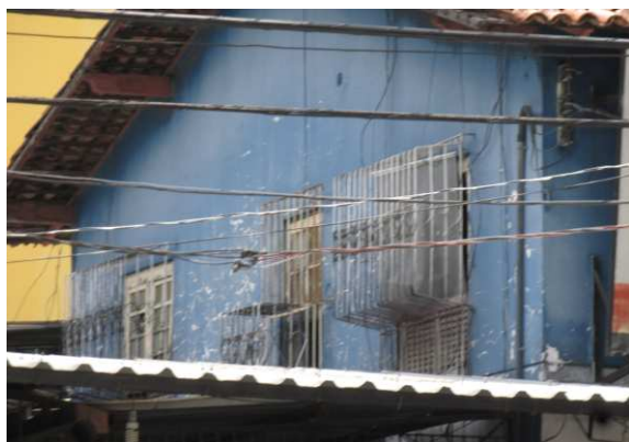
DET. 02: Parte da fachada lateral onde é possível ver algumas esquadrias de madeira e vidro, estilo venezianas com duas folhas, juntamente com o gradil de ferro simples, pintado de branco. Foto: Bianca Barbosa do Nascimento, 2014.
