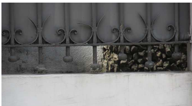
DET. 06: Indício da existência de um embasamento, formado por pequenas pedras, presente em uma das fachadas laterais.
