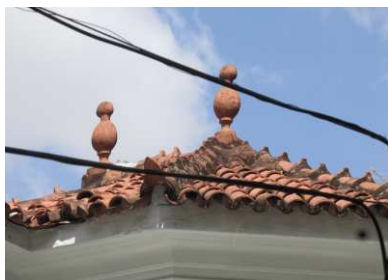
DET. 11: Pináculos presentes na cobertura da residência.
