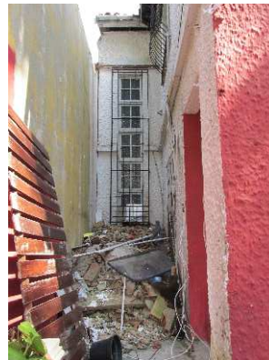
DET. 10: Esquadrias basculantes de madeira e vidro na lateral da residência. Foto: Bianca Barbosa do Nascimento, 2014.
