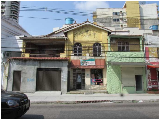
DET. 03: Atualmente, apenas parte da textura original ainda se encontra presente na fachada original. As varandas foram vedadas com grades de ferro vazadas e o arco ainda continua presente, porém atrás da porta de ferro que dá acesso a garagem.
