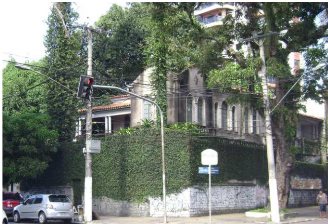
DET. 01: Esquina das Avenidas Gov. José Malcher e Alcindo Cacela, onde é possível ver as duas fachadas da residência.
