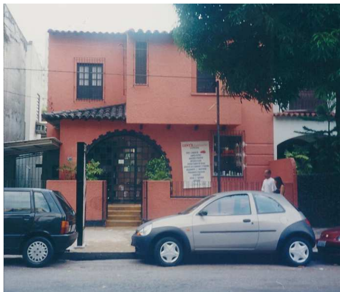
DET. 01: Imagem antiga da edificação sem as placas de propaganda, que mostram a composição de cobertura com telhas capa canal e esquadrias de madeira e vidro, com duas folhas. Foto: Acervo DPHAC, 2006.
