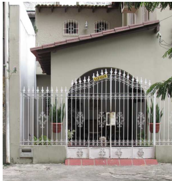
DET. 07: Acesso à garagem, onde é possível notar a existência de um recuo lateral.
