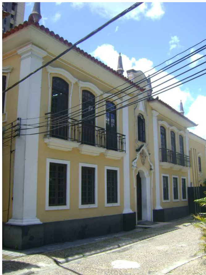
DET. 01: A edificação possui dois pavimentos. Na fachada principal, há uma sequência de seis janelas de madeira e vidro posicionadas no térreo da edificação. No 1º pavimento há uma sequência de seis portas janelas, de madeira e vidro, com uma pequena sacada, com guarda corpo de ferro, cada uma. Todas as esquadrias presentes na fachada principal possuem uma moldura. Além da moldura, a porta de entrada possui uma cártula na parte superior. Foto: Giovana Maria do Nascimento Silva, 2014.
