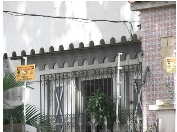
DET. 07: Ornamento presente no balanço da edificação, além de um detalhe em argamassa com um desenho semelhante ao ornamento.
