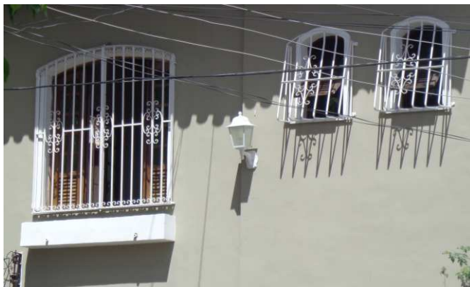
DET. 05: Presença de uma janela de madeira e vidro, estilo venezianas, e duas janelas basculantes de uma folha no 1º pavimento da residência.
