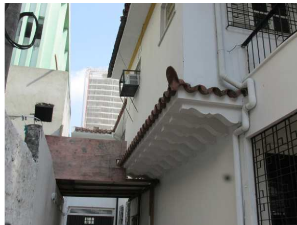
DET. 02: Ornamentos localizados abaixo do balanço da edificação. Há uma sequência de cachorros feitos com argamassa, além das telhas capa canal com o rabo de andorinha, como uma falsa cobertura.
