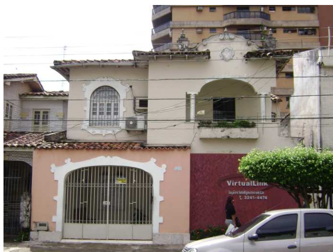
FOTO 01: Foto anterior da fachada principal, onde é possível notar as modificações realizadas na pintura externa do edifício.
