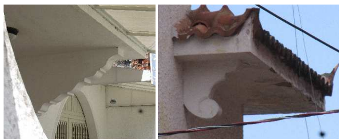
DET. 07 e 08: Mísulas presentes em diferentes fachadas da edificação.
