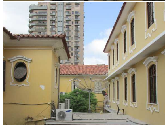
DET. 16 e 17: Relação de gabarito existente entre o prédio pioneiro e o anexo modificado. Agora os anexos se sobressaem em relação ao prédio pioneiro no quesito altura.
