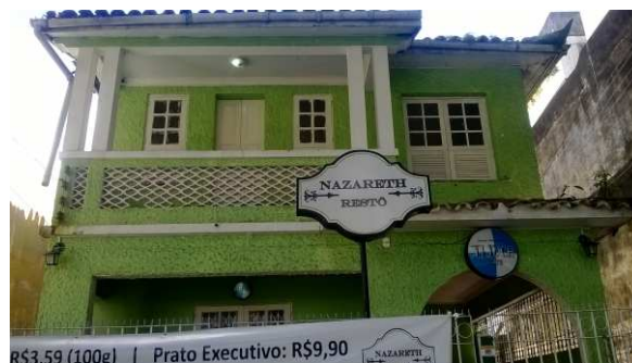
DET. 03: Detalhe da fachada da residência, onde é possível ver a composição de cobertura existente. A casa também possui uma varanda com guarda corpo de alvenaria com detalhes feitos por cobogós. A parede ainda possui sua textura chapiscada.
