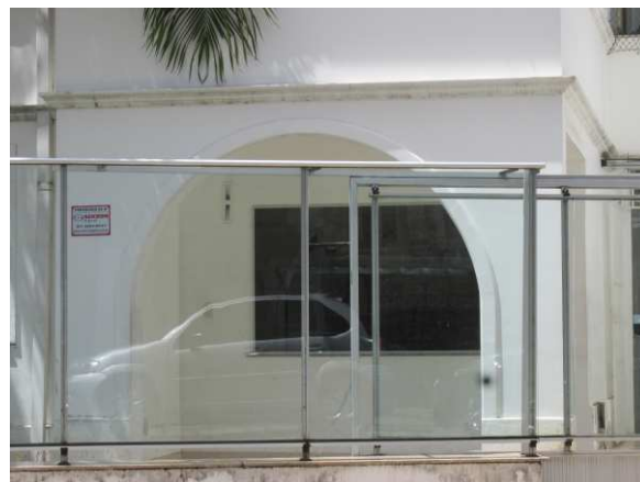
DET. 02: O arco presente na fachada principal foi mantido, e este se caracteriza como um dos poucos elementos da arquitetura neocolonial no edifício. Foto: Bianca Barbosa do Nascimento, 2014.
