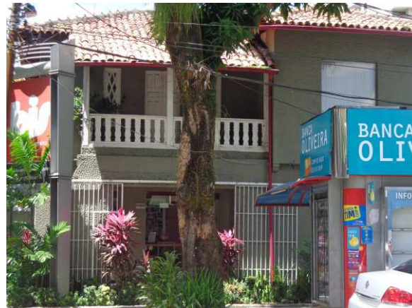
DET. 03: Na fachada principal, apenas algumas das esquadrias de madeira do 1º pavimento foram conservadas, as outras foram substituídas por esquadrias de vidro.
