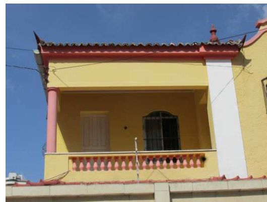
DET. 03: Detalhe da varanda presente na edificação. O guarda corpo é de alvenaria com balaústres. Há também uma coluna toscana. As esquadrias são de materiais diferentes, sendo a porta de madeira com almofadas e a janela de alumínio e vidro.
