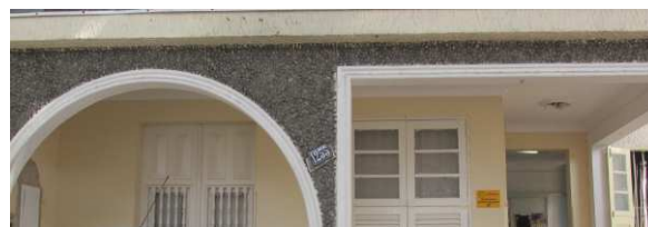
DET. 11 e 12: Os mesmos tipos de pedras presentes no embasamento do muro aparecem como revestimento da parede onde está localizado o arco e a abertura que dão acesso à entrada da edificação Fotos: Bianca Barbosa do Nascimento, 2014.
