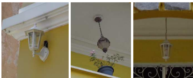
DET. 02: Diferentes tipos de luminárias e arandelas presentes na edificação. Foto: Bianca Barbosa do Nascimento, 2014.
