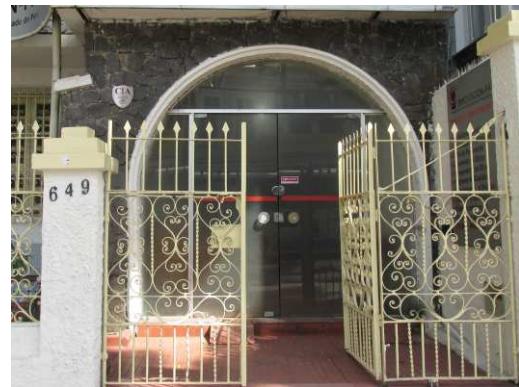
DET. 04: Detalhe de parte da parede onde está localizado o arco de acesso à entrada. A parede possui textura de cimento imitando pedra. Também é possível notar parte do muro de alvenaria e ferro vazado, onde os pilares e a base possuem textura chapiscada assim como o restante das paredes da fachada principal.
