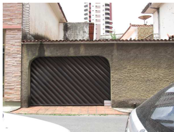
DET. 10: Entrada da garagem presente no recuo posterior, onde o acesso é feito pela Vila Alda Maria.
