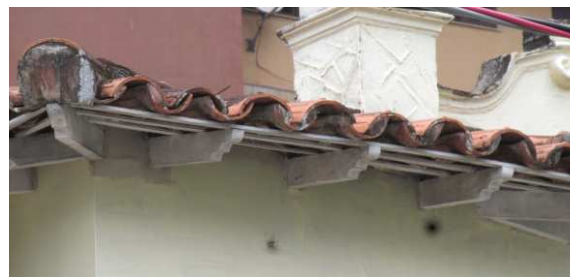
DET. 06: Presença de cachorros no beiral da cobertura. Foto: Bianca Barbosa do Nascimento, 2014.
