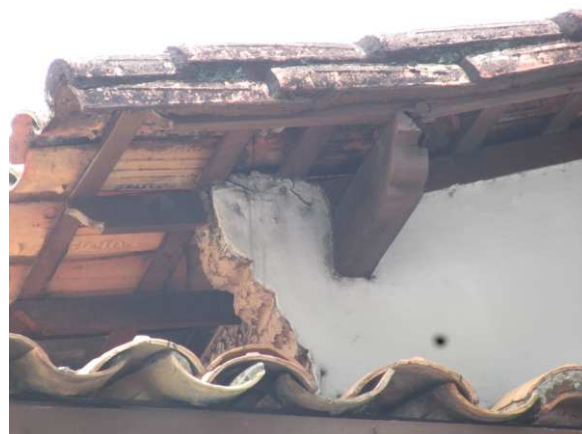
DET. 02: O beiral da residência possui cachorros, além disso, nos cantos superiores da parede da fachada, há um acabamento em alvenaria semelhante ao tipo de cachorro encontrado na residência. Fotos: Bianca Barbosa do Nascimento, 2014.
