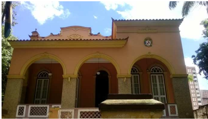
DET. 01: Detalhe de parte da fachada principal, que possui três arcos de volta perfeita de dão acesso ao interior da edificação. As esquadrias da fachada se caracterizam por ser portas de madeira e vidro com duas folhas, na cor branca. Também é possível notar parte da composição de cobertura presente na edificação.
