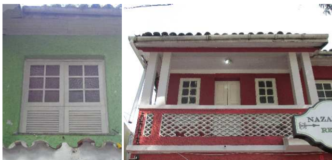
DET. 06 e 07: As esquadrias presentes na residência são, em sua maioria de madeira pintada de branco e vidro. As janelas são estilo venezianas e possuem duas folhas.
