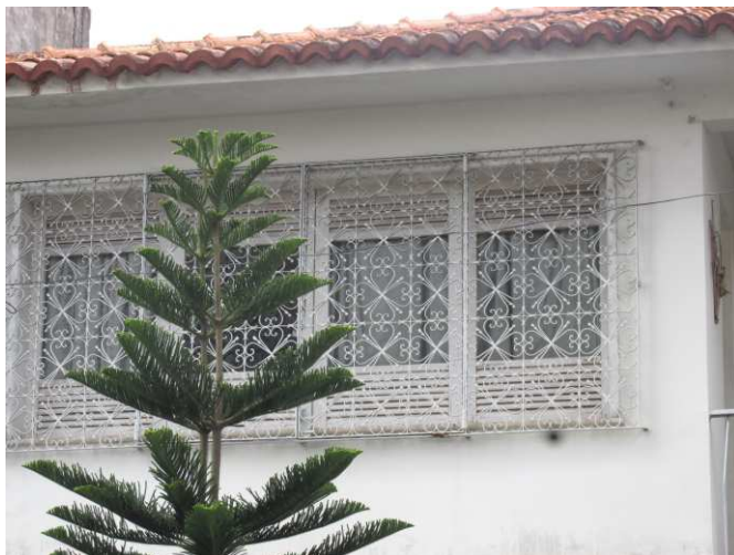
DET. 06: Janela de madeira e vidro, estilo venezianas, com 4 folhas, presente na fachada principal da residência. O gradil de ferro presente na janela possui uma ornamentação rebuscada, além de estar pintado na cor branca, assim como a janela.
