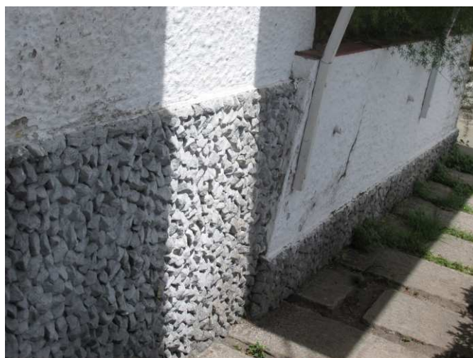
DET. 09: O embasamento da fachada principal é similar ao presente no muro. Entretanto, em determinado ponto da fachada principal, há uma diferença na altura desse embasamento.
