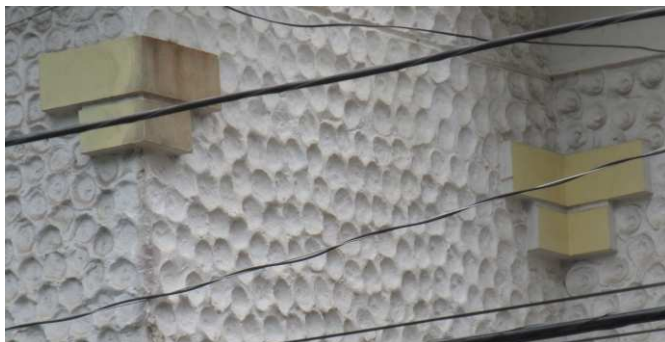
DET. 06: Detalhe em argamassa, presentes nos encontros entre as paredes.
