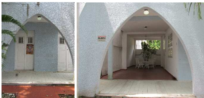
DET. 02 e 03: Detalhe dos dois arcos presentes na fachada principal da edificação, um dá acesso à entrada principal e o outro à garagem da residência. Fotos: Bianca Barbosa do Nascimento, 2014.
