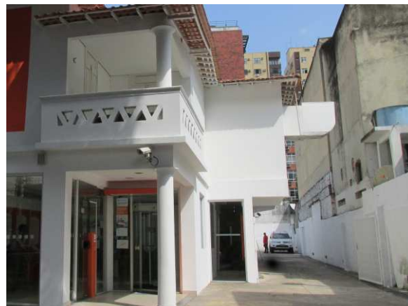
DET. 03 e 04: Comparações entre os recuos laterais da edificação em momentos diferentes. Houve a construção de um anexo embaixo do 1º pavimento, aproveitando os pilares já existentes. Também houve a retirada de esquadrias e gradis de ferro presentes na edificação. Além disso, houve a retirada de toda a textura chapiscada existente na edificação. O telhado existente foi substituído e o madeiramento, incluindo os cachorros presentes nos beirais, foram pintados de branco.
