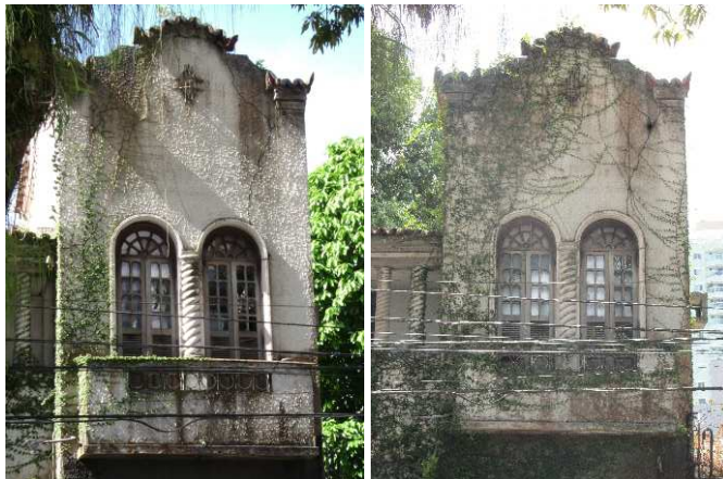
DET. 14 e 15: Fotografias em diferentes momentos de parte da fachada voltada para a Av. Gov José Malcher. Além do processo de deterioração, é possível notar a presença do frontão, que dentre as suas características possui ornamentação com telhas capa canal e rabo de andorinha.
