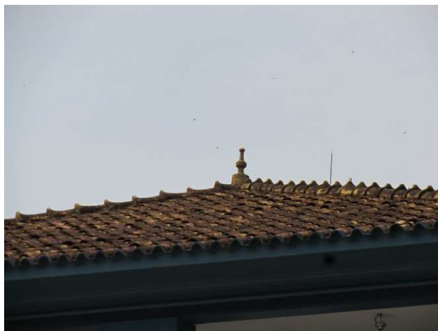
DET. 01: Cobertura com telha capa canal, além da presença de um pináculo.
