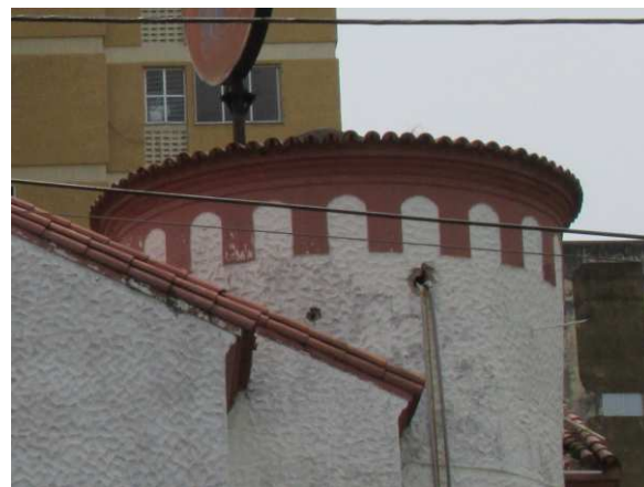
DET. 10: Detalhe dos ornamentos com argamassa, que lembram uma sequência de arcos, presentes na parte superior da torre.
