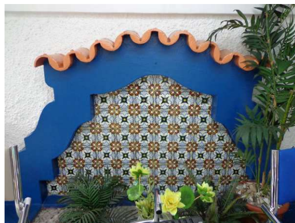
DET. 08: Provável fonte da residência, revestida com azulejos com motivos florais, além da presença da moldura com telhas capa canal. Atualmente o espaço serve como um pequeno jardim interno da loja. Foto: Bianca Barbosa do Nascimento, 2014.
