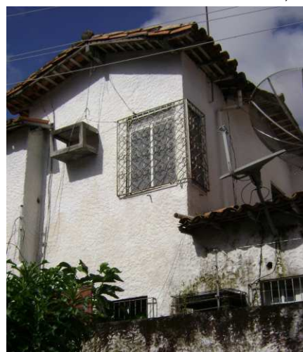
DET. 04: Janelas posicionadas no canto da parede, dando a impressão de que são esquadrias de canto, ideia reforçada pelo gradil de ferro em "L"
