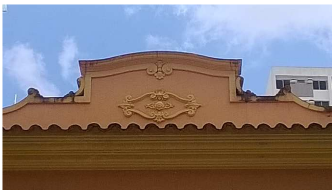
DET. 02: Detalhe do frontão presente na edificação.
