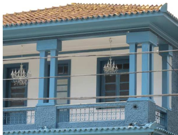
DET. 03: Parte da varanda do edifício. O guarda corpo é feito de alvenaria com gradil de ferro pintado de azul com detalhe. Há também pilares de secção quadrada fazendo o apoio da cobertura.
