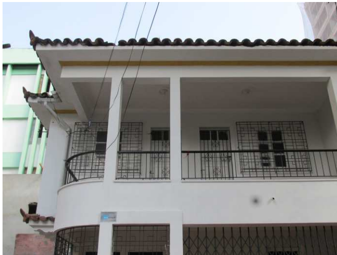
DET. 01: A edificação possui uma varanda com o guarda corpo curvo, sendo este de alvenaria com gradil de ferro vazado sem ornamentação.
