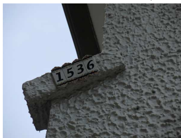
DET. 08: Detalhe da parede chapiscada com a numeração da residência. Foto: Bianca Barbosa do Nascimento, 2014.
