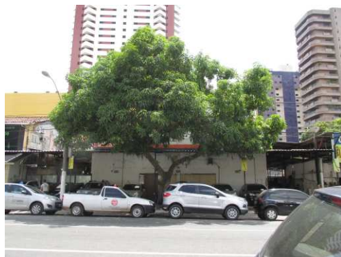
DET. 01: Fachada voltada para a Av. Generalíssimo Deodoro, onde não é possível visualizar a edificação. Foto: Bianca Barbosa do Nascimento, 2014.
