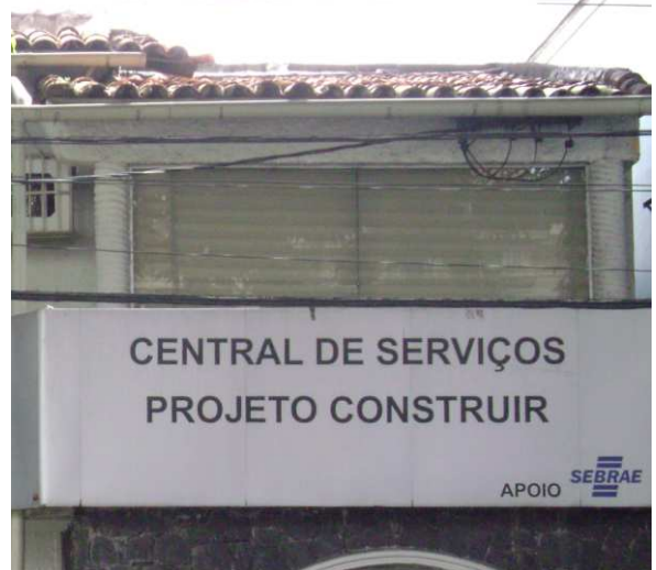
DET. 08: Detalhe de parte da varanda da edificação, que possui duas colunas torsas. Não foi possível obter detalhes acerca do guarda corpo, devido à placa presente na frente da edificação.
