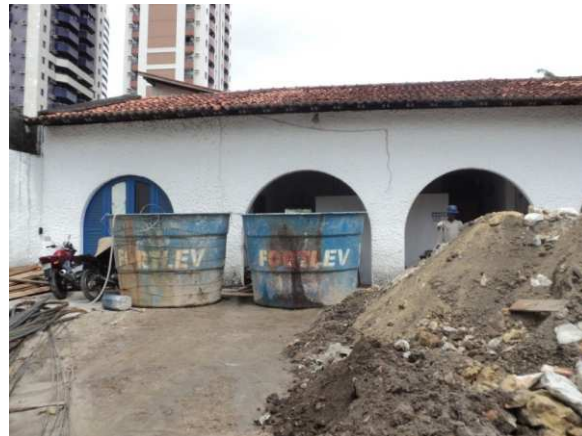
DET. 03: Imagem da edificação durante a construção do anexo. É possível notar que houve uma intervenção na fachada do prédio neocolonial, onde houve a retirada da esquadria que ficava localizada no último arco à esquerda da imagem.
