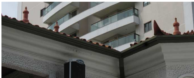
DET. 02: A cobertura da residência é feita por telhas capa canal, além disso os vértices da cobertura possuem rabo de andorinha. Já na parte superior da cobertura, há três pináculos, sendo que um deles está na porção da cobertura correspondente à torre facetada.
