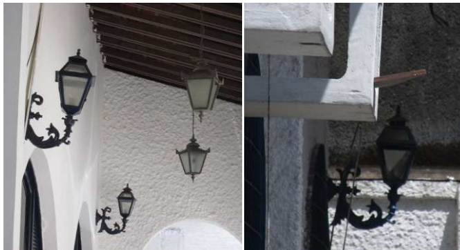
DET. 05 e 06: Arandelas e lustres instalados ao longo da edificação.
