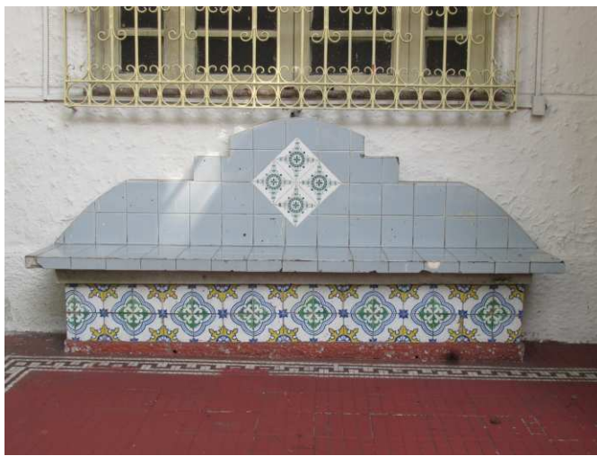
DET. 05: Pannel azulejado que indica a existência de uma fonte no local anteriormente.
