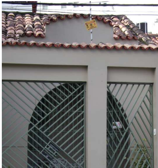
DET. 01: Detalhe da fachada onde se encontra o frontão, o arco de acesso à entrada principal e parte da cobertura com telha capa canal.
