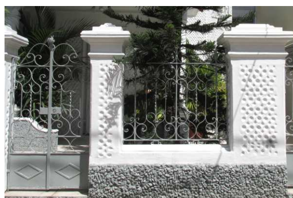
DET. 06: Muro da residência. O muro possui o mesmo tipo de textura que as fachadas da casa. Ele também possui um embasamento de pedras, que lembra textura chapiscada, na cor cinza. Entre os pilares do muro há um gradil com ornamentação simples na cor cinza. Fotos: Bianca Barbosa do Nascimento, 2014.
