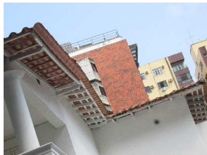
DET. 06 e 07: Detalhe dos beirais da edificação. Eles apresentam cachorros ao longo do beiral. As peças do madeiramento foram pintadas de branco em uma das intervenções que a residência sofreu para se tornar uma agência bancária
