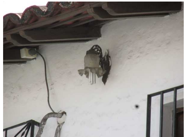
DET. 06 e 07: Lustre e arandela instalados em diferentes pontos da fachada principal.
