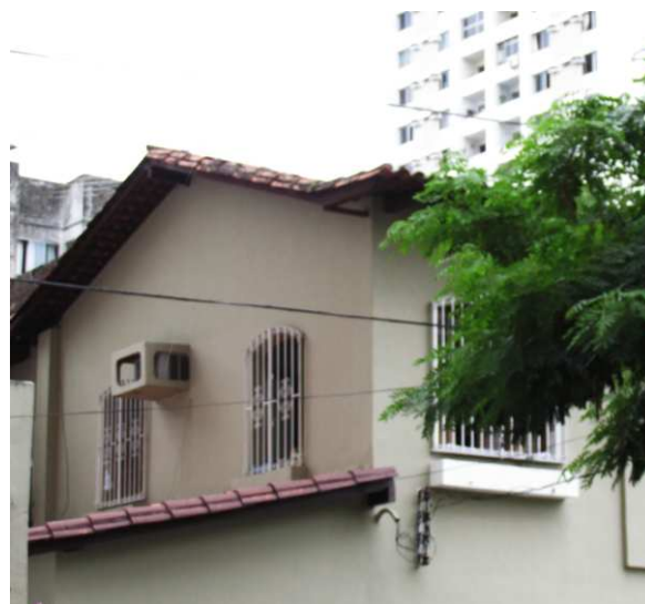
DET. 08: Parte da composição da cobertura, além da presença de duas esquadrias de arco abatido na lateral do prédio.
