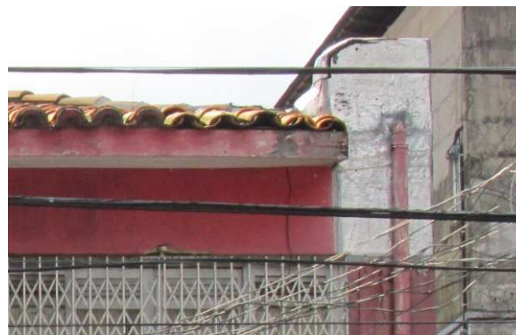
DET. 04: Detalhe de um elemento feito de alvenaria, na cor branca. Este elemento poderia ter sido anteriormente um frontão, o que leva a crer que a residência poderia ter sido geminada originalmente. Foto: Bianca Barbosa do Nascimento, 2014.
