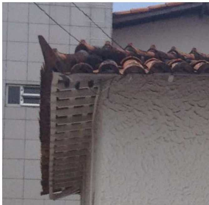
DET. 01: Detalhe da cobertura e de parte da parede na residência. A cobertura possui rabo de andorinha e é constituída por telha capa canal. O beiral da edificação possui cachorros e o madeiramento era pintado de branco. A parede da edificação era da cor branca e possuía textura chapiscada Foto: Acervo DPHAC, 2012.
