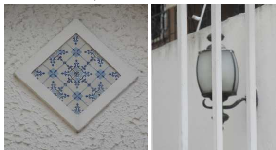
DET. 03 e 04: Detalhes do azulejo presente no centro do frontão e de uma arandela presente na fachada principal da edificação. Fotos: Bianca Barbosa do Nascimento, 2014.
