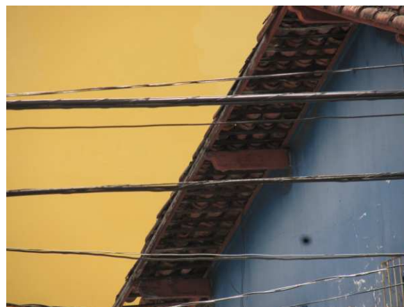
DET. 04: Presença de cachorros ao longo do beiral da residência. Foto: Bianca Barbosa do Nascimento, 2014.
