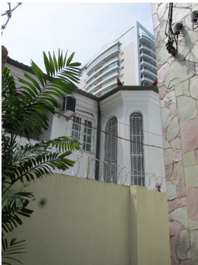
DET. 05: Torre facetada com aberturas vedadas por ferro e vidro. Assim como o restante da edificação, a torre possui textura chapiscada em suas paredes. Fotos: Bianca Barbosa do Nascimento, 2014.
