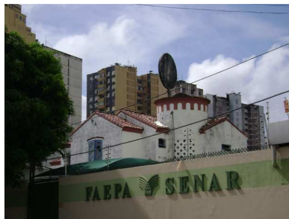
DET. 03: Detalhe de parte da cobertura da residência. Há composição de coberturas e as telhas utilizadas são tipo capa canal
