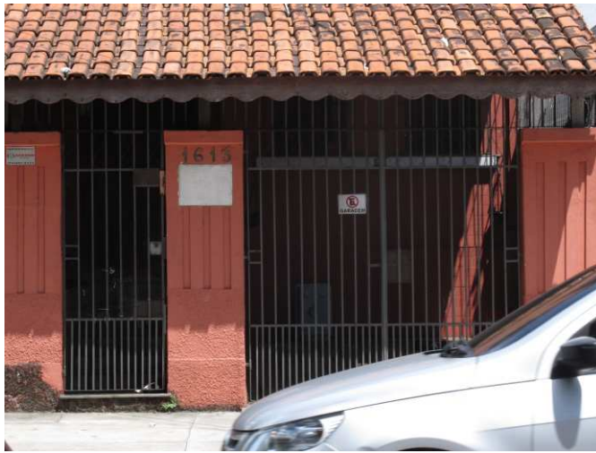
DET. 01: Muro da residência. A ornamentação dos pilares consiste em sulcos feitos na argamassa que reveste o pilar, além disso, o muro possui embasamento com textura chapiscada
