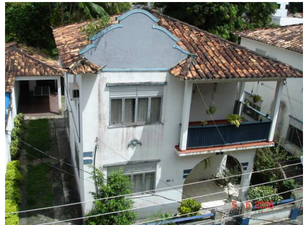
DET. 02: Edificação voltada para a Pass. Salgado Filho. Nela é possível perceber o uso de esquadrias de alumínio com vedação em vidro com quatro folhas, além da presença da varanda e do frontão.
