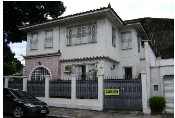
DET. 02: O muro da edificação é alto, composto por uma base e pilares de alvenaria com gradil de ferro vedado, com ornamentação simples. O acesso para a garagem da residência se dá pela Travessa Benjamin Constant.
