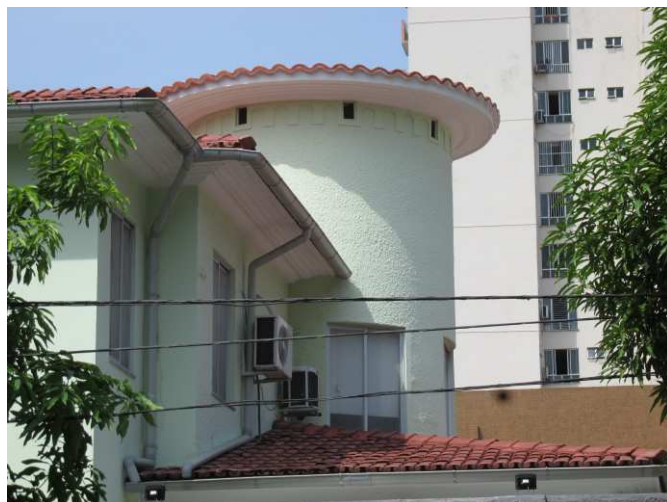
DET. 05: Detalhe da torre circular presente na residência. Apenas as paredes da torre possuem textura chapiscada. As janelas da torre também foram substituídas por esquadrias de alumínio e vidro. O beiral da cobertura da torre é coberto por um forro de argamassa branca.
