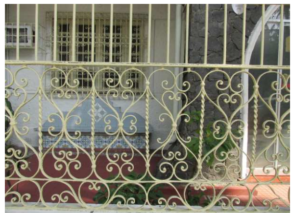
DET. 09: Detalhe de parte do gradil de ferro vazado do muro da edificação.
