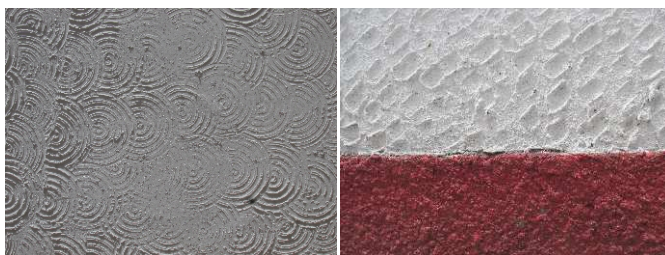
DET. 06 e 07: Diferentes tipos de texturas encontradas na edificação. A textura de aspecto circular foi encontrada nas fachadas lateral e frontal, enquanto a textura chapiscada foi encontrada no muro da residência.
