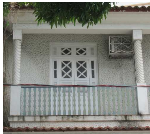
DET. 08: Detalhe de parte da varanda do edifício.
