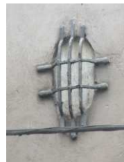
DET. 20: Detalhe de uma das arandelas presentes nas fachadas da residência
