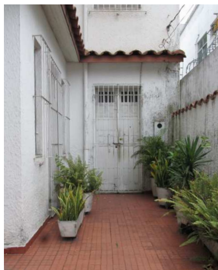
DET. 03: Porta de entrada madeira almofadada, com a presença de vidro.
