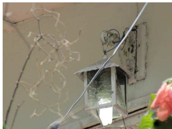
DET. 08: Arandela presente em uma das paredes da fachada principal.
