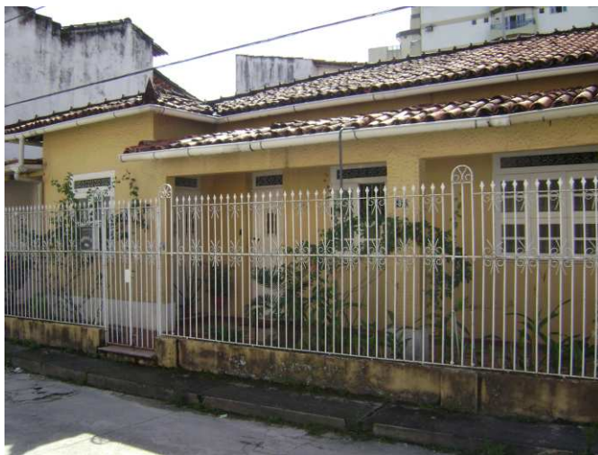
DET. 01: A casa caracteriza-se por ter composição de cobertura, ser composta por telhas capa canal e possuir rabo de andorinha.
