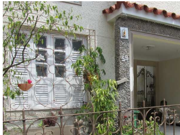
DET. 02: A parede referente à entrada da garagem possui uma textura diferente entre as demais. Em vez do chapisco, a textura é feita com pequenas pedrinhas. Foto: Bianca Barbosa do Nascimento, 2014.
