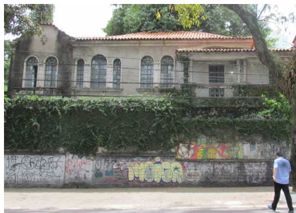
DET. 03 e 04: As fotos da fachada voltada para a Av. Gov. José Malcher tiradas em momentos diferentes demonstram o processo de deterioração que a edificação vem sofrendo ao longo dos anos. É possível também notar as modificações realizadas, como o aumento do muro, a modificação da pintura de amarelo para branco e a retirada de tijolos de vidro (que já se caracterizava como uma modificação contemporânea) da varanda.
