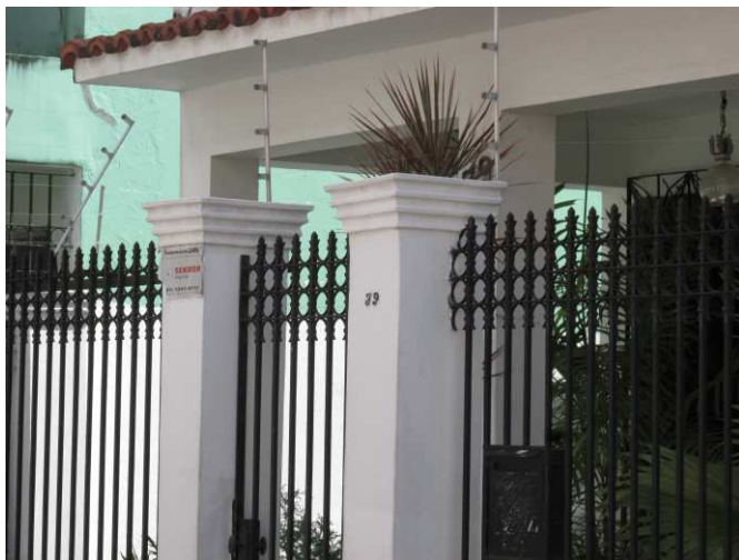
DET. 05: Detalhe do pilar presente no muro da edificação. O muro também possui, ao longo do seu comprimento, gradis de ferro simples pintados de preto.
