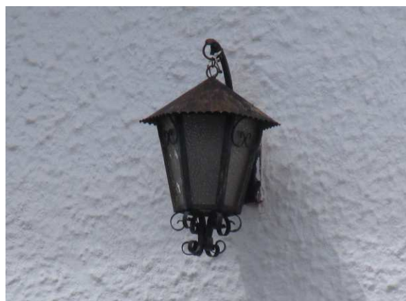
DET. 11: Arandela presente na fachada principal.
