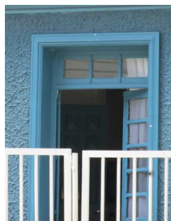
DET. 04: Detalhe de uma das esquadrias presentes na edificação. Esta, assim como as demais, é de madeira pintada de azul, vidro com duas folhas para a abertura.
