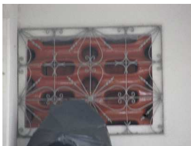
DET. 07: Cobogós cerâmicos presente em uma das fachadas laterais da edificação.
