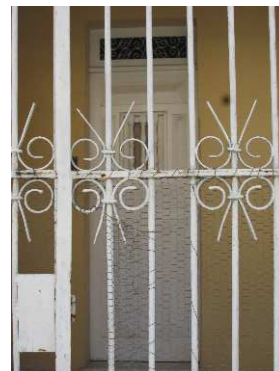
DET. 03 e 04: As esquadrias da edificação são de madeira e vidro e possui uma bandeira com detalhes em ferro.
