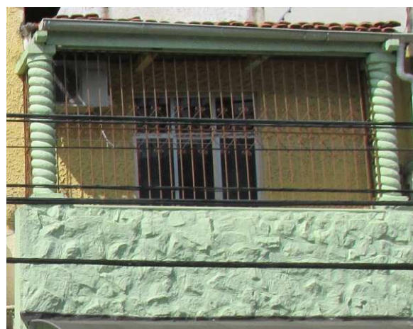
DET. 07: Uma das varanda do edifício. O acesso também se dá por uma porta janela de madeira e vidro. O guarda corpo possui textura de cimento imitando pedra e colunas torsas que fazem a sustentação da cobertura.
