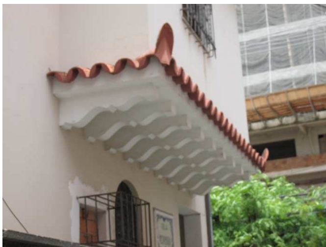
DET. 05: Parte da fachada lateral com elementos que remetem a arquitetura neocolonial, com os azulejos presentes no muro e na parede lateral, na sequência de cachorros abaixo dos detalhes com telha capa canal.
