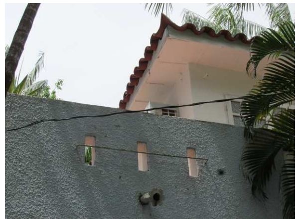
DET. 05: Detalhe do muro da edificação, que possui três elementos vazados, e de parte da cobertura com telha capa canal e rabo de andorinha. Foto: Bianca Barbosa do Nascimento, 2014.
