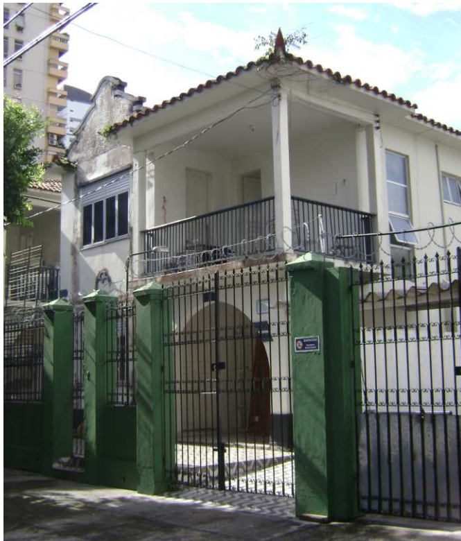
DET. 01: Residência voltada para a Rua João Balbi. Assim como as outras casas da vila, esta possui um arco na fachada principal, varanda, frontão curvilíneo e cobertura com telha capa canal. O diferencial desta residência em relação às outras está na presença do rabo de andorinha presente na extremidade da cobertura.
