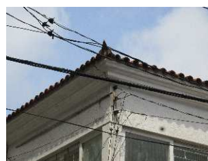
DET. 05: Detalhe da cobertura da edificação. Há a utilização de telhas capa canal e o uso de rabo de andorinha.
