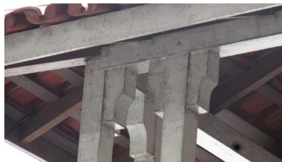
DET. 11: Detalhe em madeira presente no topo dos pilares localizados na varanda.
