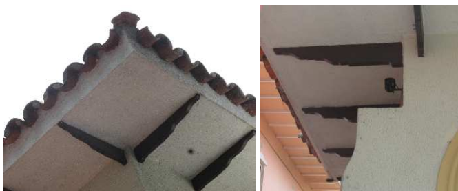
DET. 02 e 03: Detalhes do beiral da cobertura. É possível notar a presença de cachorros no beiral. O desenho dessas peças é diferenciado em relação aos cachorros presentes em outras residências neocoloniais. No DET. 04 nota-se um recorte no canto superior da parede da fachada principal.
