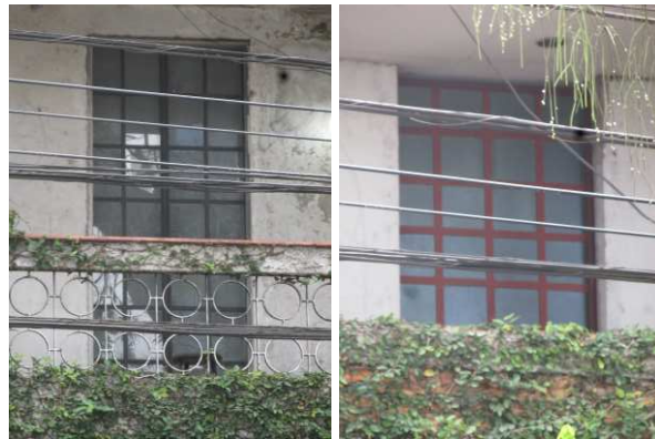
DET. 11: Indícios de intervenções realizadas nas esquadrias, como a troca do tipo de vidro e do material da estrutura.
