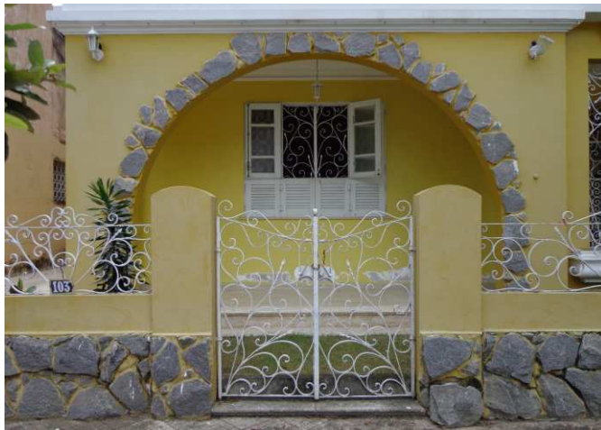
DET. 01: Muro baixo com embasamento em pedra e gradil em ferro vazado e pintado de branco. Ao fundo é possível notar a ornamentação do arco de acesso com cimento imitando pedras. O gradil da esquadria ao fundo, tem a mesma ornamentação do gradil do muro. Foto: Amanda de Paula Bentes Pessoa, 2014.
