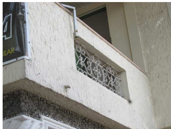
DET. 03: Detalhes de parte do guarda corpo que ainda está visível. A ornamentação do vão é feita por um gradil de ferro ornado e pintado de branco.
