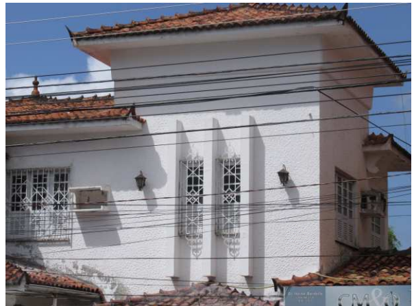
DET. 03: Detalhe de duas esquadrias de madeira e vidro, com uma folha, entre pilastras que funcionam como quebra-sóis. Além de duas arandelas presentes na fachada Foto: Bianca Barbosa do Nascimento, 2014.
