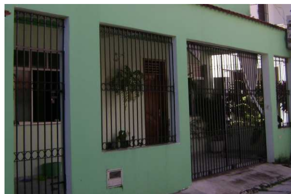
DET. 03: As esquadrias são feitas de materiais variados, sendo que as janelas são de alumínio e vidro, e as portas são de madeira com venezianas na parte superior. Foto: Bianca Barbosa do Nascimento, 2014.
