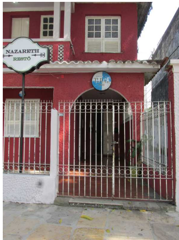
DET. 11: Muro com base de alvenaria e grade de ferro com ornamento simples, pintada de branco.
