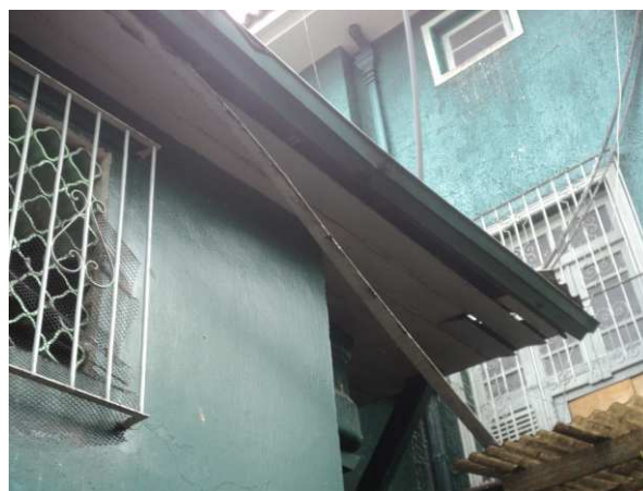
DET. 05: Em algumas esquadrias, o gradil está instalado do lado externo da residência. Existem também, em algumas fachadas, esquadrias basculantes.
