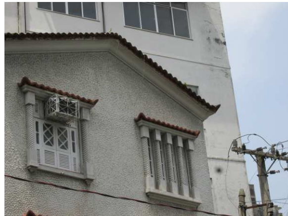
DET. 07: Detalhe de parte da fachada voltada para a Tv. Dr. Moraes, onde há uma variação do caimento do telhado, que tem em suas extremidades o rabo de andorinha
