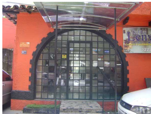
DET. 03: O arco possui uma moldura em argamassa, contudo após intervenções, o vão foi vedado com uma esquadria de alumínio e vidro na cor preta. É possível perceber na imagem o embasamento com textura chapiscada da parede onde o arco se encontra. Foto: Giovana Maria do Nascimento Silva, 2014.
