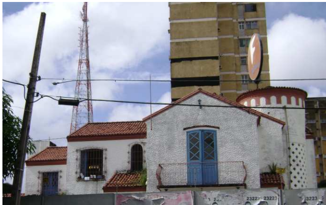
DET. 05: A edificação possui uma pequena sacada com guarda corpo simples de ferro vazado. Com exceção da porta janela que dá acesso a sacada, as demais esquadrias possuem grades de ferro simples na cor vermelha.
