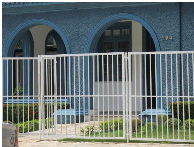
DET. 02: Arcos que dão acesso à entrada principal da edificação. Percebe-se também que a fachada possui textura chapiscada.
