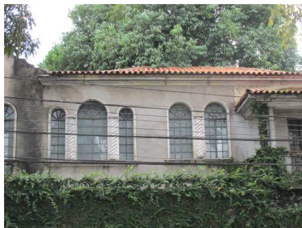
DET. 11: Indícios de intervenções realizadas nas esquadrias, como a troca do tipo de vidro e do material da estrutura.
