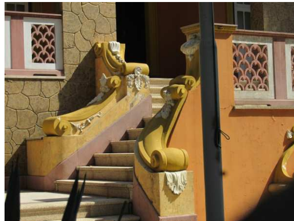
DET. 03: Detalhe de parte da escada que dá acesso à entrada principal. O corrimão possui detalhes em argamassa semelhante a volutas.
