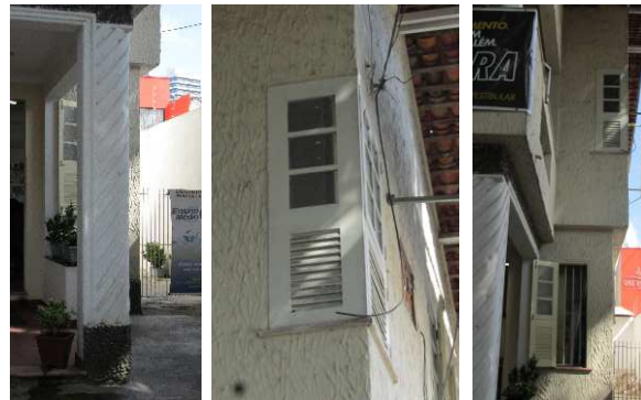
DET. 08, 09 e 10: O DET. 08 se refere a um pilar com textura remetendo a uma coluna torsa, localizado na fachada principal. Já os DET. 09 e 10 referem-se a esquadrias presentes na fachada. A janela localizada no térreo possui uma folha, enquanto a esquadria do 1º pavimento é uma esquadria de canto. Ambas são de madeira e vidro e possuem persianas. No caso da janela do térreo, esta possui uma grade de ferro simples. Fotos: Bianca Barbosa do Nascimento, 2014.
