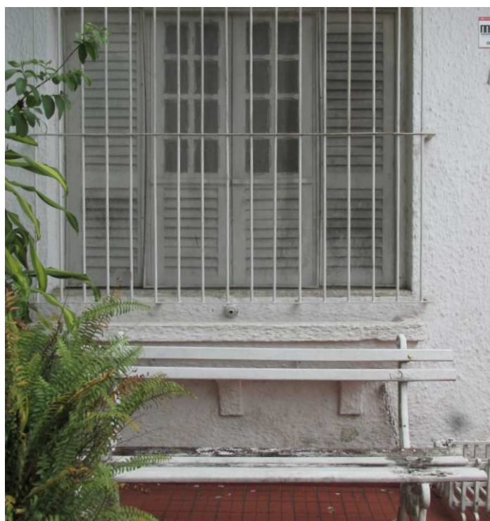
DET. 05: Esquadria estilo veneziana de madeira e vidro, presença de uma floreira e um banco de madeira e ferro, além do detalhe da parede externa da residência chapiscada e de coloração branca. Foto: Bianca Barbosa do Nascimento, 2014.
