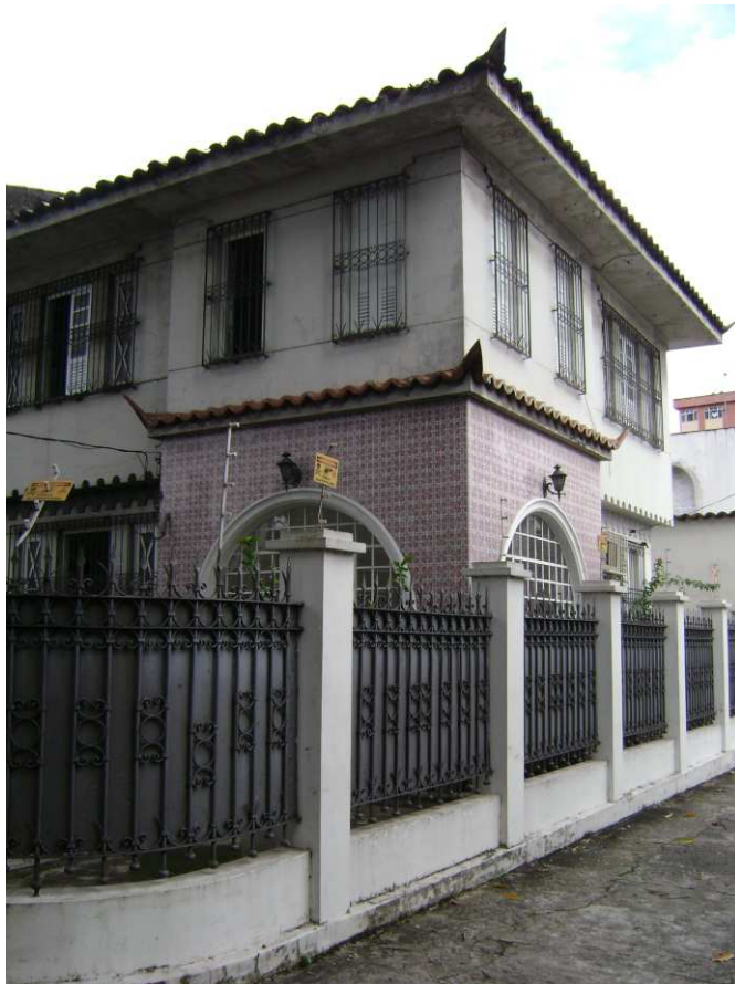
DET. 01: A residência possui dois pavimentos, e entre esses pavimentos há uma ornamentação com telha capa canal, que se assemelha a uma cobertura, fazendo a composição com o telhado da edificação.
