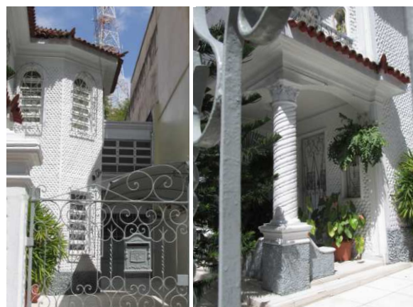
DET. 04 e 05: Detalhe dos elementos laterais da edificação. No DET. 04, a residência possui apenas recuo lateral em um dos lados. No DET. 05, uma das duas colunas torsas que sustentam a varanda presente na fachada principal. Foto: Bianca Barbosa do Nascimento, 2014.
