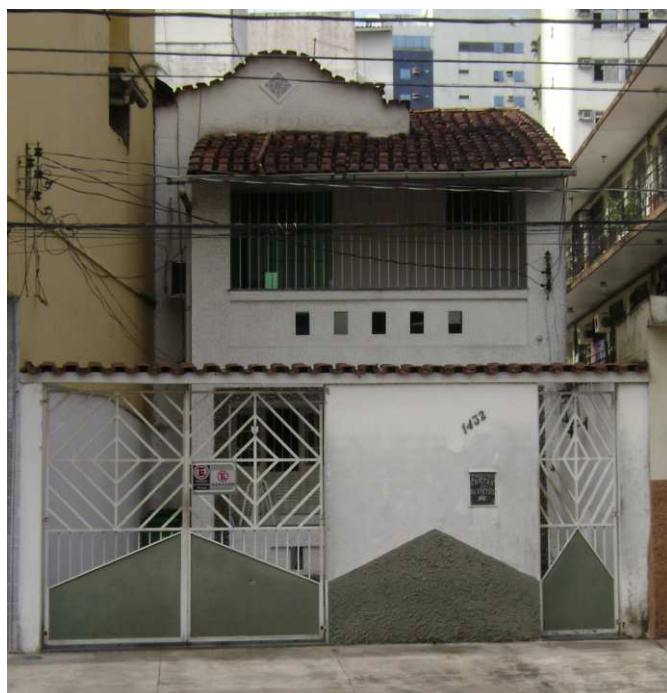
FOTO 01: Fachada principal da residência de dois pavimentos, apresentando recuo frontal. Pelas características que apresenta, o muro existente é uma intervenção atual. Quanto as telhas utilizadas na cobertura, presume-se que houve uma intervenção no telhado que substituiu as telhas originais por telhas plan. Foto: Felipe Moreira Azevedo, 2013.
