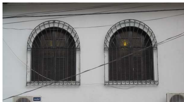
DET. 08: Retirada completa da textura e substituição desta por uma textura chapiscada e de coloração branca. Foto: Bianca Barbosa do Nascimento, 2014.
