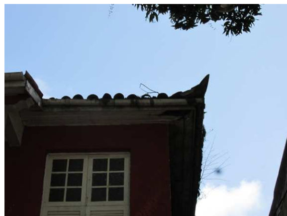
DET. 04: Detalhe do canto da cobertura. A cobertura é composta por telhas capa canal e rabo de andorinha nas extremidades. O beiral é forrado com forro de madeira pintado de branco.
