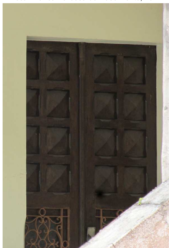
DET. 07: Porta de entrada da edificação. É feita de madeira não pintada, possui almofadas e alguns detalhes com gradil de ferro. Foto: Bianca Barbosa do Nascimento, 2014.
