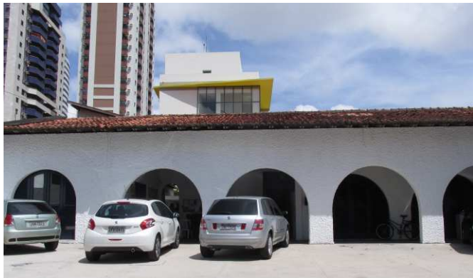
DET. 01: A edificação é térrea e possui um grande recuo frontal que serve de estacionamento. Ela possui 5 arcos de volta perfeita que dão acesso à uma área de circulação, que por sua vez dá acesso ao interior do edifício. Ao fundos está localizado o anexo da Escola de Música, construído recentemente.
