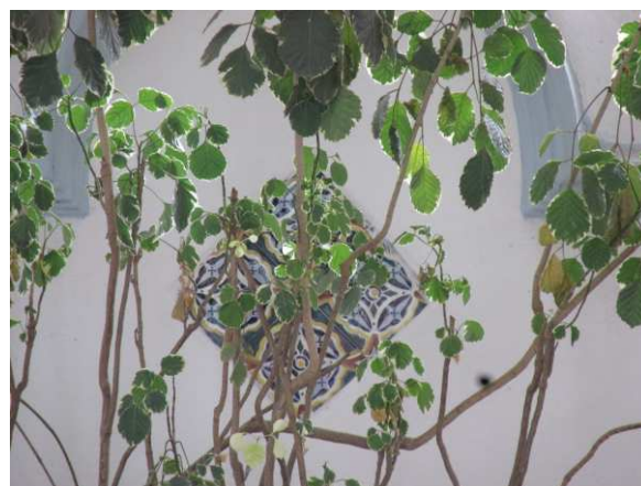
DET. 09: Pequeno painel de azulejos presente na fachada principal.
