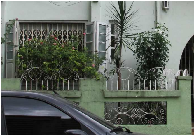
DET. 01: Detalhe do muro liso e baixo, com a presença de um gradil de ornamentação simples entre os pilares.
