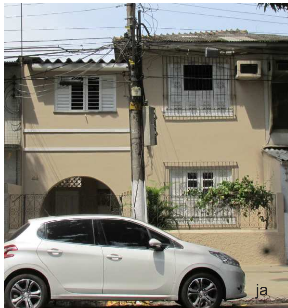
DET. 02: Residência fotografada em 2014. Não houve mudanças significativas na edificação em um período de 2 anos. Nota-se na imagem a existência de arborização no recuo frontal, além de duas faixas pintadas de branco, sobressalentes de cimento, acima do arco, na fachada principal. Foto: Bianca Barbosa do Nascimento, 2014.
