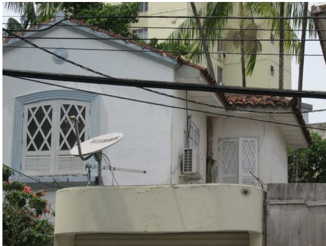
DET. 01: Janelas presentes no 1º pavimento da edificação. As janelas são de madeira e vidro, estilo treliçado, pintadas de branco e com duas folhas. Foto: Bianca Barbosa do Nascimento, 2014.
