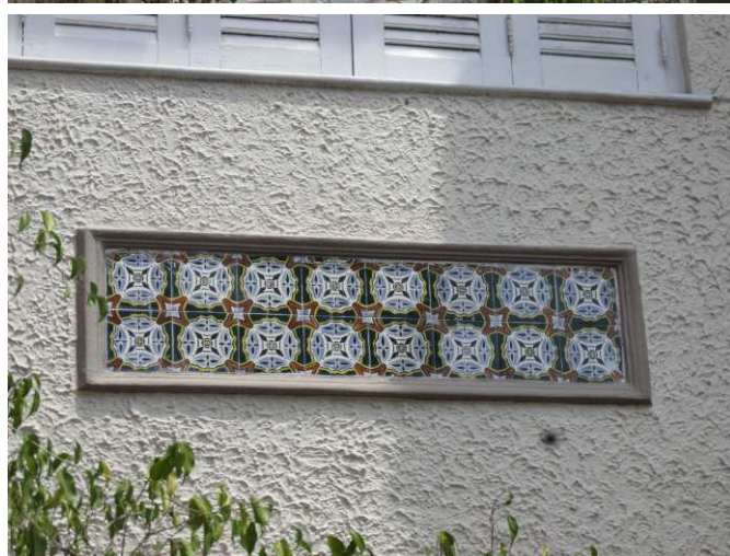
DET. 04 e 05: Detalhe de parte da fachada principal, onde há um pequeno painel de azulejos. Fotos: Bianca Barbosa do Nascimento, 2014.
