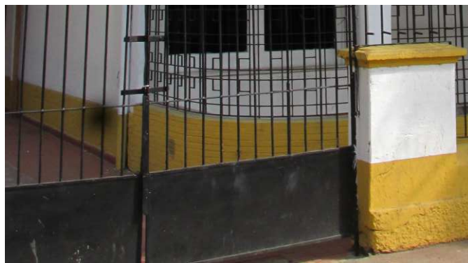
DET. 04: O embasamento presente na fachada principal remete a blocos de alvenaria cerâmica, enquanto no resto da edificação e no muro, o embasamento presente é de textura chapiscada.. Foto: Bianca Barbosa do Nascimento, 2014.
