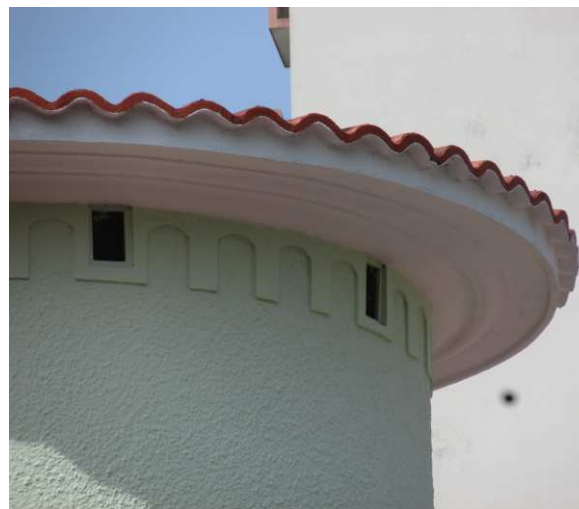
DET. 06: Detalhe dos elementos de ornamentação da torre próximos ao beiral. São desenhos de vários arcos feitos com argamassa.
