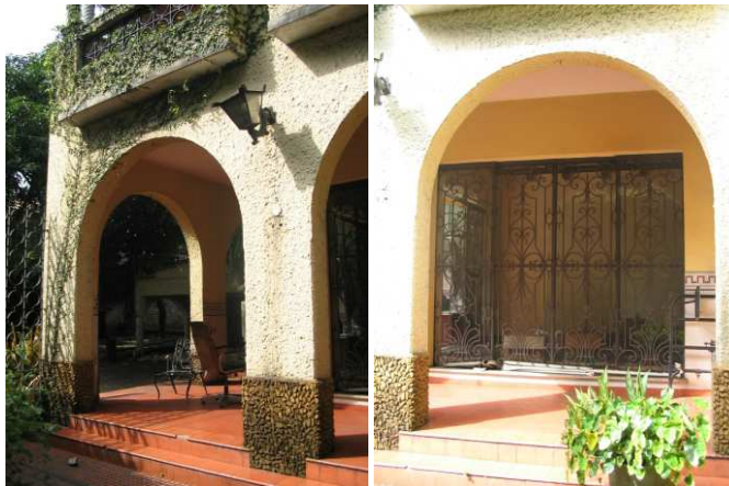
DET. 05 e 06: Presença de quatro arcos distribuídos em duas fachadas, cujas as paredes são chapiscadas. O embasamento é feito de pedrinhas que formam uma textura chapiscada. Esquadrias de vidro e ferro pintadas de preto, além de arandelas presentes em algumas fachadas.
