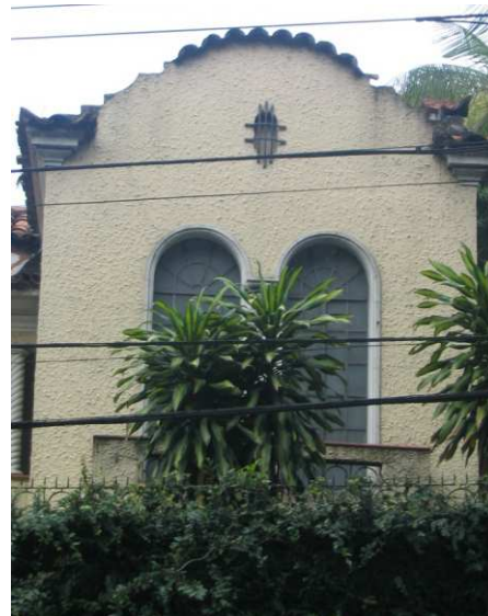
DET. 18: Detalhe de parte da fachada voltada para a Av. Alcindo Cacela, onde também existe um frontão com ornamentação utilizando telha capa canal e rabo de andorinha, porém o desenho deste frontão é diferenciado em relação ao das outras fachadas.
