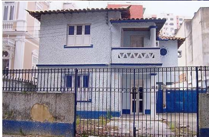
DET. 01 e 02: Imagens que demonstram como era a edificação antes da intervenção sofrida. A residência possuía textura chapiscada, cores nos tons de azul, esquadrias de madeira, cobertura com telha capa canal, muro com textura chapiscada e gradil de ferro com ornamentação simples.
