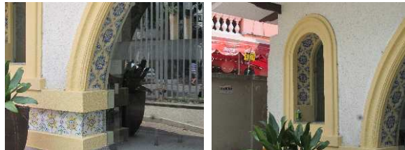
DET. 04 e 05: Presença de azulejos revestindo os arcos de acesso à casa e os arcos presentes nas esquadrias. Há também azulejos na fachada principal, formando uma espécie de embasamento.
