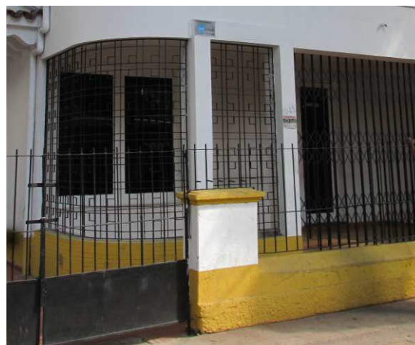
DET. 07: No térreo, a área correspondente à varanda foi vedada com dois tipos de grades de ferro, um com detalhes geométricos e outro que se assemelha a grades sanfonadas. A porta e a janela presentes no térreo são de madeira e vidro. A janela possui duas folhas de correr, enquanto a porta possui uma folha. Foto: Bianca Barbosa do Nascimento, 2014.
