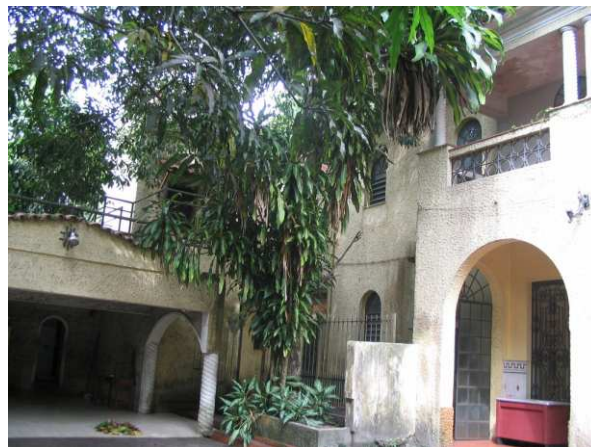
DET. 19: Parte de uma das fachadas voltadas para dentro do terreno e da garagem. Assim como a residência, a garagem possui elementos característicos das edificações neocolônias, como um frontão simples ornamentado com telha capa canal, arcos e colunas torsas.
