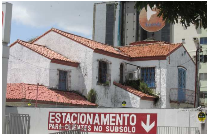
DET. 01: Atualmente a residência está abandonada, contudo antes dessa condição a edificação também funcionou com escola de idiomas.
