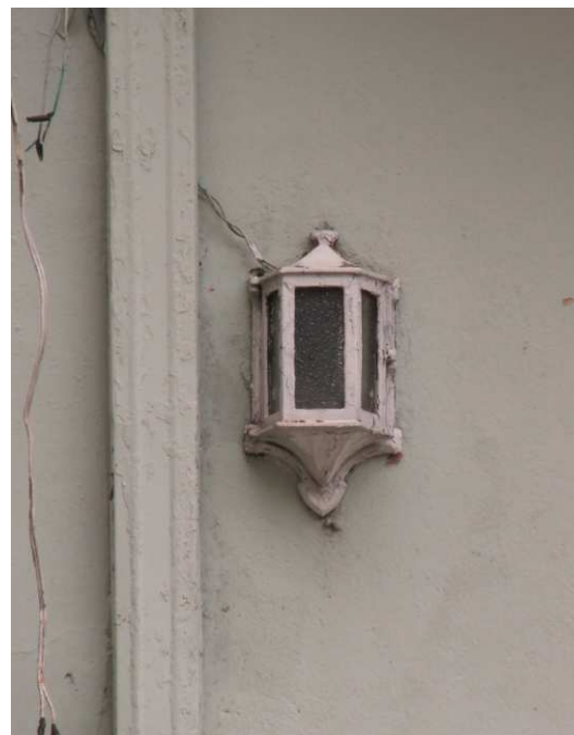
DET. 08: Arandela presente na fachada principal da residência.
