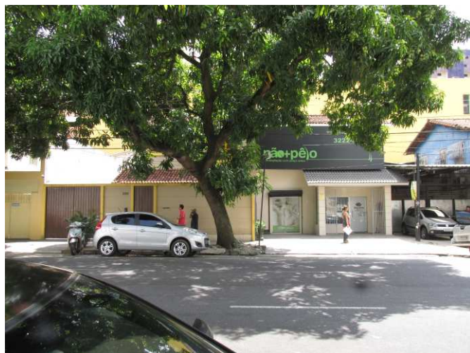
FOTO 01: Fachada principal das edificações geminadas. Ambas passaram por intervenções que descaracterizaram a fachada completamente.
