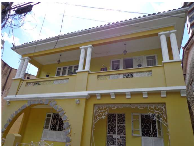
DET. 05: Presença de seis colunas toscanas, distribuídas ao longo da varanda. Também é possível perceber o beiral em gesso. As esquadrias presentes na edificação são, em sua maioria, estilo venezianas de madeira e vidro.
