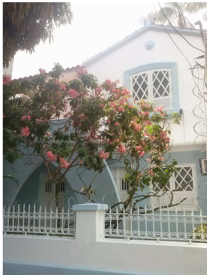
DET. 06: Detalhe de parte da fachada principal, onde é possível ver um detalhe geométrico de argamassa na empena da parede.
