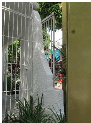
DET. 02: Desenho presente na parede da fachada principal da residência. O desenho da parede possui curvas que lembram as curvas dos frontões das casas neocoloniais.
