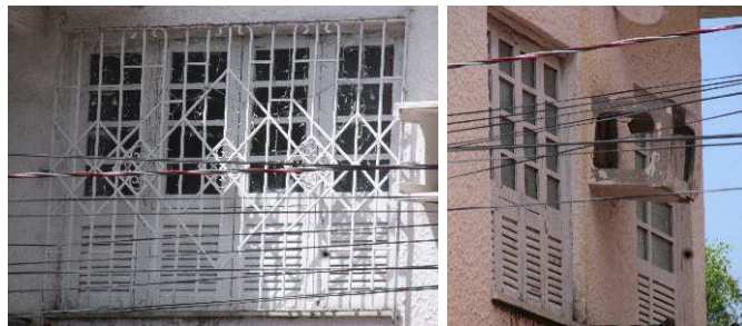
DET. 05 e 06: Detalhe das esquadrias para janelas presentes na edificação. Ambas as imagens apresentam janelas de madeira e vidro, da cor branca, estilo venezianas, com duas folhas fixas e duas móveis. O diferencial entre elas se encontra na grade de ferro presentes, em sua grande maioria, nas esquadrias da fachada principal
