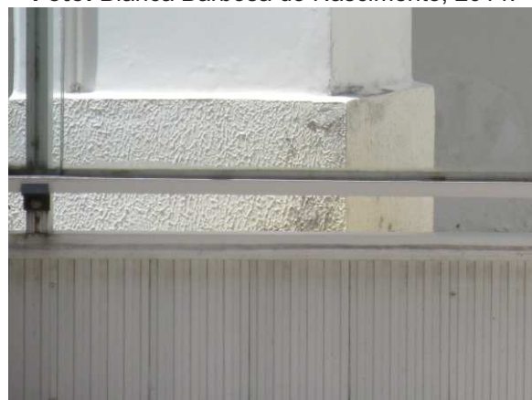
DET. 03: Detalhe do embasamento ainda presente em uma das paredes onde o arco está localizado. O embasamento possui textura chapiscada na cor branca. Este embasamento está presente em apenas uma parte da fachada principal. Foto: Bianca Barbosa do Nascimento, 2014.
