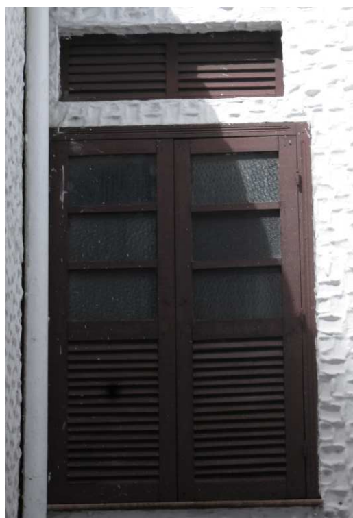
DET. 08: Uma das janelas presente na fachada. A esquadria de madeira e vidro possui duas folhas além de venezianas. Na parte superior dessa esquadria, há uma abertura com venezianas para aumentar a ventilação
