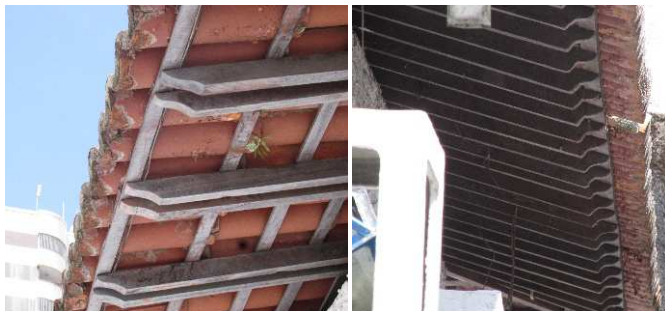
DET. 08 e 09: Detalhe dos cachorros presentes na fachada principal e lateral, respectivamente. Na fachada principal, os cachorros estão agrupados em 2 exemplares, enquanto no beiral da fachada lateral, eles estão posicionados e dispostos normalmente.
