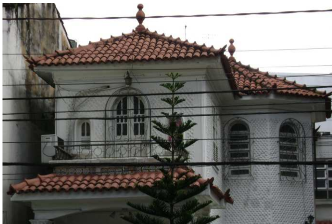
DET. 10: Composição de cobertura, com o uso de telhas capa canal. A cobertura possui rabo de andorinha e dois pináculos
