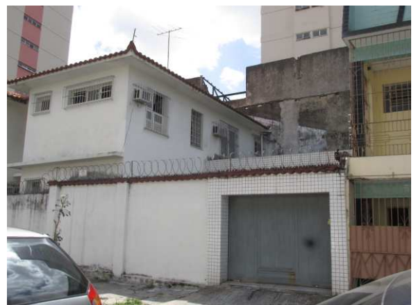
DET. 10: A garagem da residência está localizada no recuo posterior que esta possui. O acesso se dá pela Rua Tiradentes. Através do muro da garagem é possível perceber que a residência passou por intervenções para a adaptação para algum tipo de uso específico, como a garagem.
