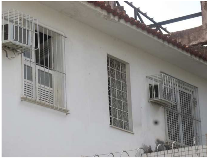
DET. 05: Esquadrias presentes na fachada posterior da residência. Uma delas é de madeira e vidro, com venezianas, enquanto a outra é apenas de madeira. Ambas estão pintadas de branco e possuem gradil de ferro pintado de branco.
