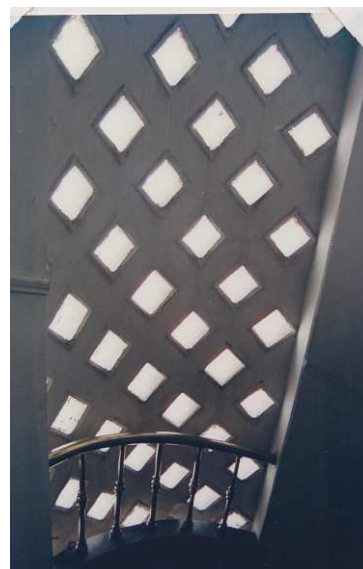
DET. 11: Elementos vazados em formato de losangos em grande parte da parede da torre.
