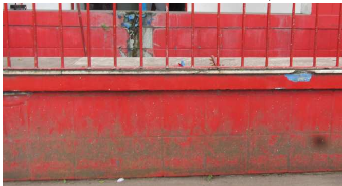
DET. 02: O embasamento da fachada principal, assim como o revestimento da base de alvenaria do muro, é feito com revestimento cerâmico da cor vermelha..
