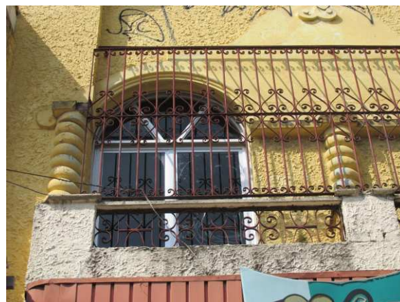
DET. 06: Porta janela de madeira e vidro presente na fachada principal, que dá acesso à sacada cujo o guarda corpo é de alvenaria com detalhes em ferro.
