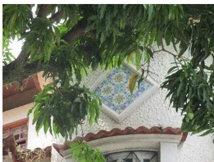
DET. 06: Detalhe do azulejo presente na torre da edificação.
