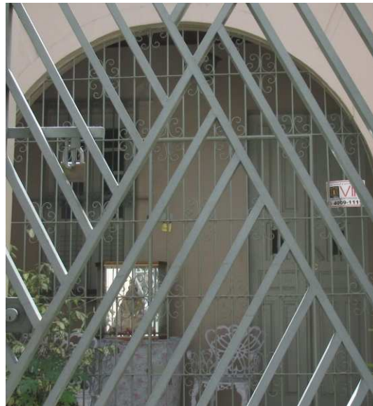
DET. 03: Parte das esquadrias presentes na edificação. A porta possui duas folhas de madeira pintada de branco e com almofadas.
