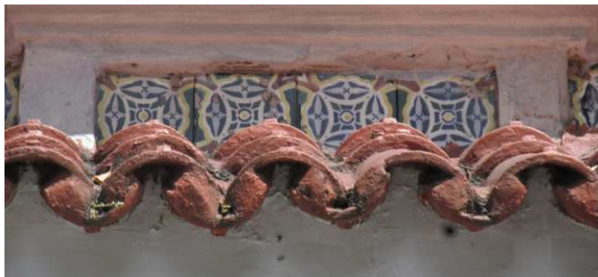
DET. 09: Detalhe dos azulejos presentes no guarda corpo da sacada da residência.
