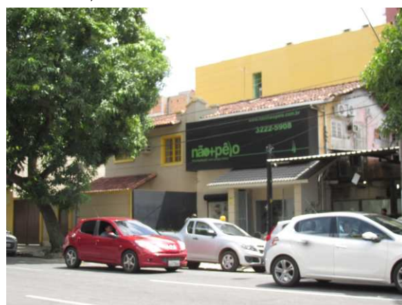
DET. 02: As edificações possuem dois pavimentos e, no centro da cobertura há um frontão com detalhes geométricos e uma pequena voluta.
