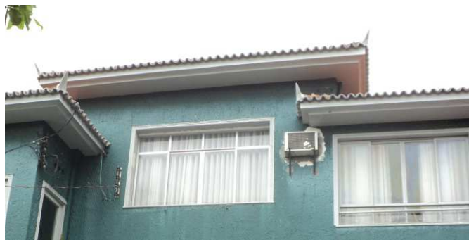
DET. 01: Composição de cobertura, uso de telha capa canal e rabo de andorinha. Presença de esquadrias com folhas de correr, sendo a estrutura de ferro e a vedação de vidro.
