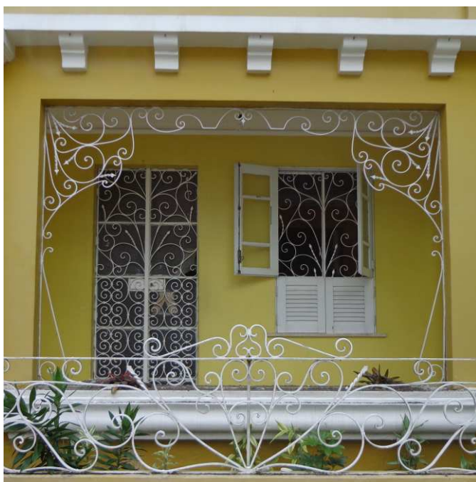
DET. 06: Detalhe de uma parte do gradil de ornamentação do muro, da esquadria e da porta.
