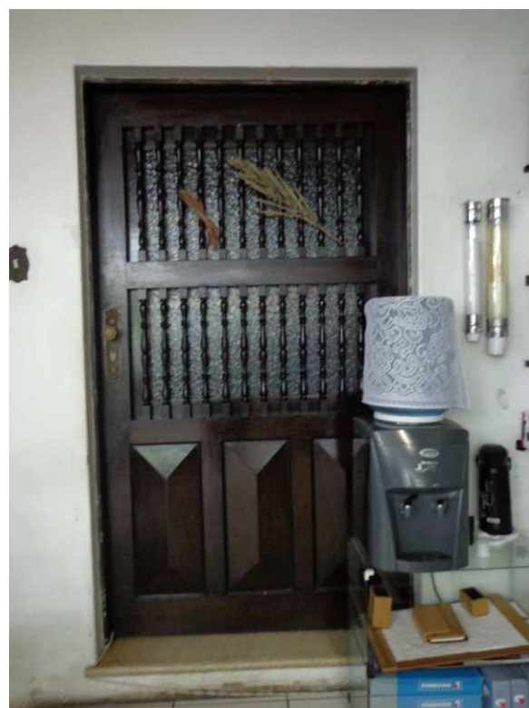
DET. 09: Porta de entrada original da residência. A esquadria é de madeira, não é pintada, possui almofadas e é em parte vedada por vidro. Foto: Bianca Barbosa do Nascimento, 2014.
