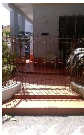
DET. 02: Detalhe das grades de ferro presentes no muro da edificação. O gradil é simples com pouca ornamentação e pintado de vermelho.
