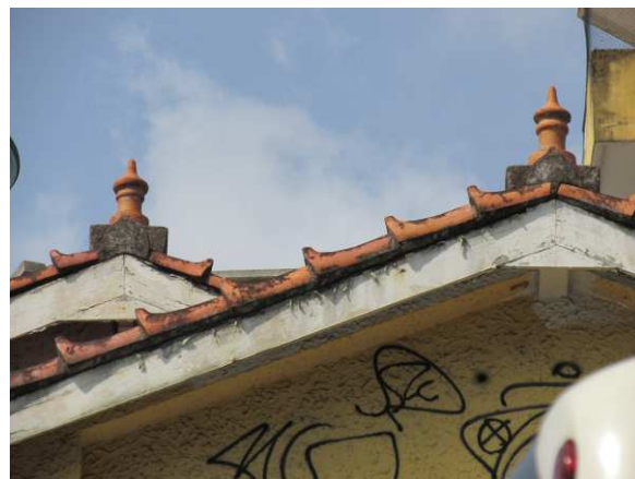
DET. 01: Detalhe da parte da cobertura feita com telha capa canal e com a presença de pináculos.
