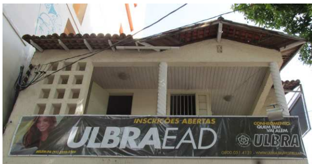
DET. 01: Detalhes da fachada onde está localizada a varanda. Há a presença de elementos vazados, além de duas colunas torsas e uma arandela no centro da empena.
