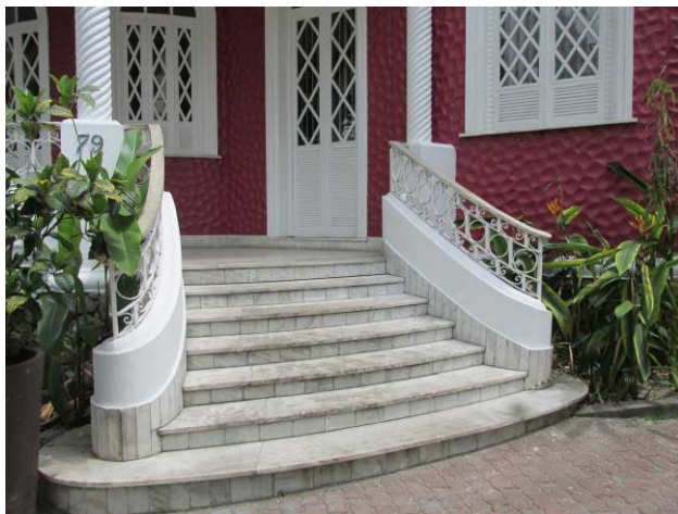
DET. 07: Escada de acesso a entrada principal. Foto: Bianca Barbosa do Nascimento, 2014.
