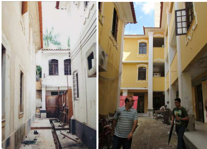
DET. 12 e 13: Diferentes momentos de intervenções feitas para ampliação dos prédios. Ambas as fotos retratam intervenções realizadas nos anexos.
