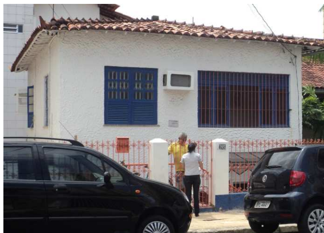
FOTO 01: Fachada principal da residência nº 916. A edificação possuía várias características da arquitetura neocolonial, como textura na parede, esquadrias de madeira, coberturas com telha capa canal, entre outros. Contudo, a edificação passou por uma grande intervenção que a descaracterizou completamente. Foto: Acervo DPHAC, 2012.
