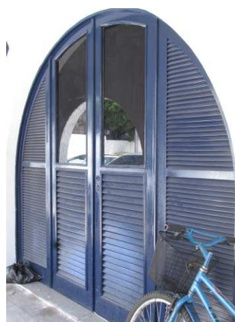
DET. 12: Exemplo das esquadrias presentes na residência. Elas são de madeira e vidro, estilo venesianas, na cor azul marinho. O formato delas é compatível com os arcos existentes na fachada principal.
