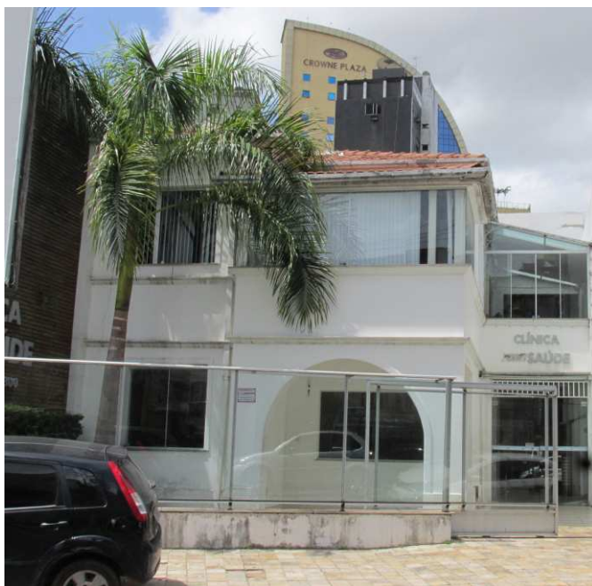
FOTO 01: Fachada principal da edificação que atualmente funciona como uma clínica médica. O edifício já passou por várias intervenções, e hoje em dia, já não apresenta mais as esquadrias originais, sendo estas substituídas por esquadrias de vidro. Foto: Bianca Barbosa do Nascimento, 2014.
