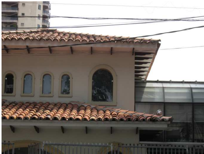
DET. 01: Detalhes do jogo de cobertura, com o uso de telha capa canal, presente na fachada principal da edificação.
