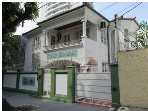
DET. 07: O muro da edificação passou por modificações para atender à sua nova função. Foram instalados portões de ferro e cercas elétricas para atender de necessidades previstas. Foto: Bianca Barbosa do Nascimento, 2014.
