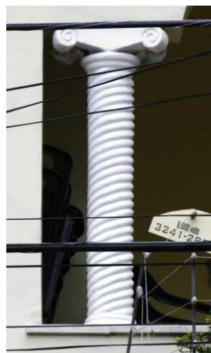
DET. 09: Coluna torsa de base simples e capitel jônico. Foto: Bianca Barbosa do Nascimento, 2014.
