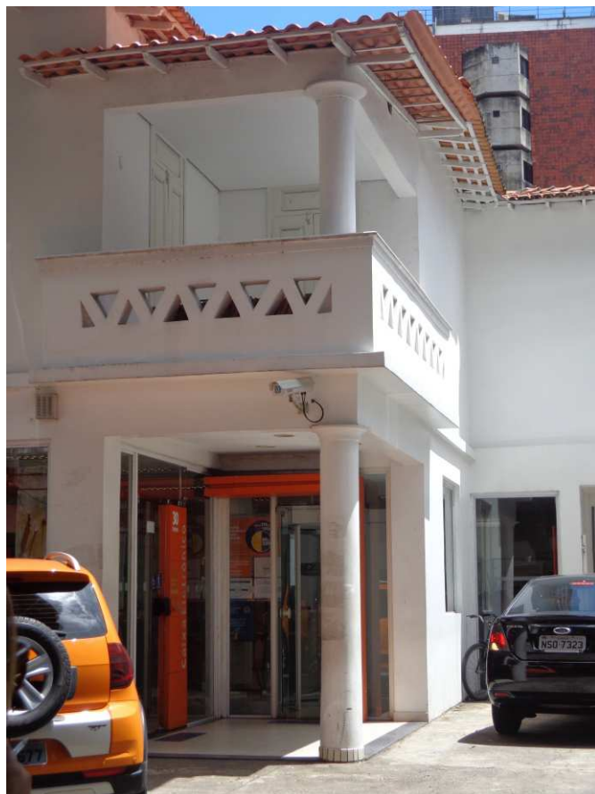
DET. 05: Há duas colunas toscanas na fachada principal da edificação, uma no térreo e a outra na varanda do 1º pavimento. A varanda possui um guarda corpo de alvenaria com alguns elementos vazados em formato triangular.
