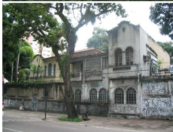
DET. 12 e 13: Exemplos das tipologias de esquadrias utilizadas na fachada. A maioria delas se apresenta com a estrutura de madeira ou ferro pintado de branco ou preto, com a vedação em vidro
