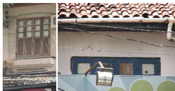
DET. 03 e 04: Esquadrias semelhantes presentes nas duas edificações. São janelas de madeira (a da edificação nº 1523 é pintada de azul) e vidro, estilo venezianas, com quatro folhas. Abaixo dessas esquadrias, há uma floreira.
