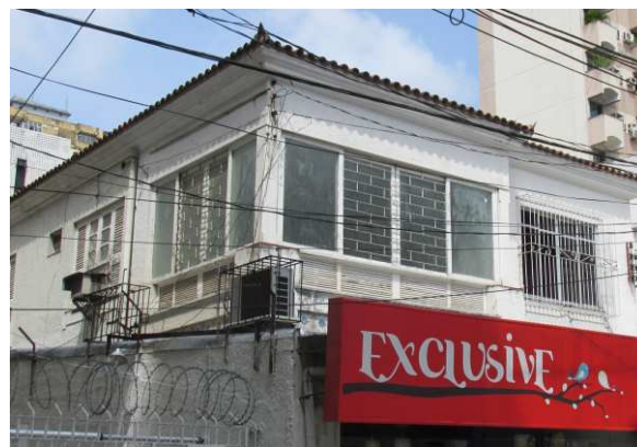
DET. 03: Esquadrias do 1º pavimento da edificação. A maior parte das janelas possui de duas a quatro folhas e são de correr. Quanto ao material, apenas uma das janelas é de madeira e vidro em estilo venezianas, as restantes dão de alumínio e vidro. A maioria das janelas possui um gradil de ferro simples usado para a proteção.
