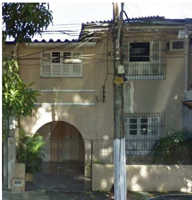
FOTO 01: Fachada principal da residência. A edificação é geminada, e já passou por algumas intervenções. Possui janelas de quatro folhas estilo venezianas, um arco que dá acesso ao interior do edifício e um muro composto por uma base de alvenaria com textura chapiscada e um gradil de ferro vazado simples na cor preta. Foto: Google Street View, 2012.
