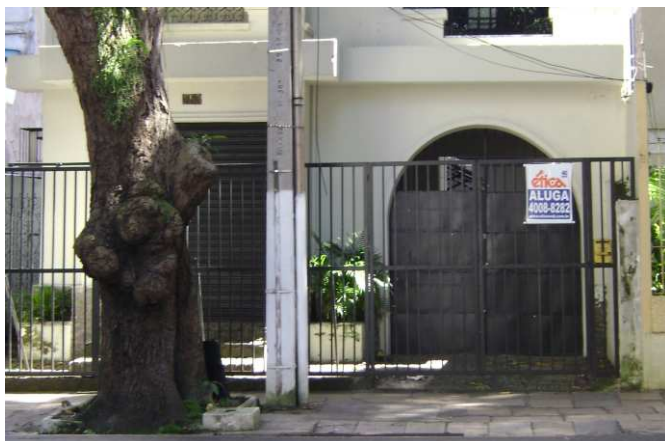
DET. 01: A edificação possui recuo frontal e um arco que dá acesso ao interior da edificação no pavimento térreo.
