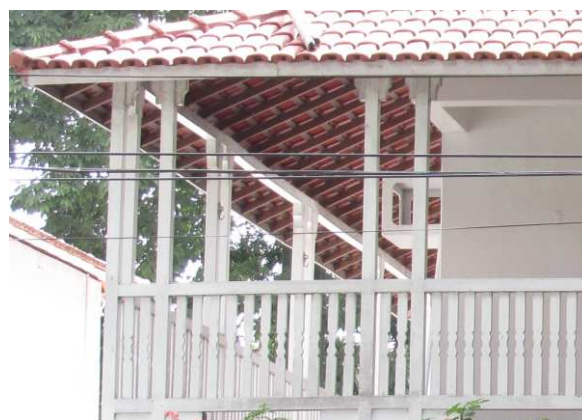
DET. 10: Detalhe da varanda e de seu guarda corpo. A madeira utilizada ao longo do guarda corpo possui um desenho curvilíneo na metade da sua extensão. Os pilares de sustentação do guarda corpo também são em madeira.
