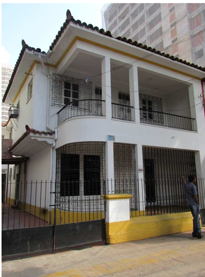
FOTO 01: Fachada principal da residência geminada. O muro da edificação é composto por uma base de alvenaria, com embasamento de textura chapiscada, com grades de ferro simples sem ornamentação.
