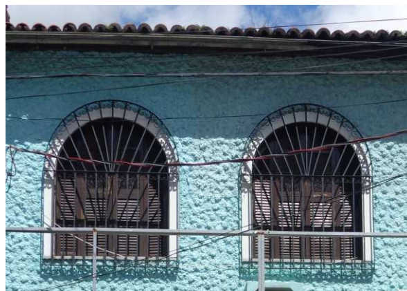
DET. 02: Presença de janelas com arcos e esquadrias de madeira, estilo venezianas, com gradil de ornamentação simples. Também é perceptível, na cobertura, o uso de telha capa canal
