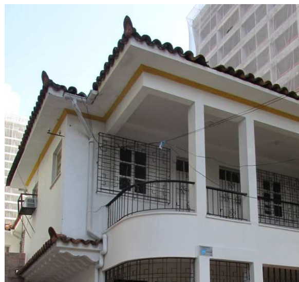
DET. 06: A cobertura da residência é feita com telhas capa canal, além disso possuem rabo de andorinha em cada ponta. Foto: Bianca Barbosa do Nascimento, 2014.
