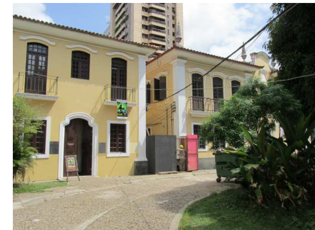
DET. 05 e 06: Prédio pioneiro e o anexo em momentos diferentes. Além da cor dos edifícios, houve pequenas mudanças na fachada do anexo, como a retirada da molduras da esquadrias do 1º pavimento e o acréscimo de sacadas com guarda corpo feito com gradil de ferro simples.
