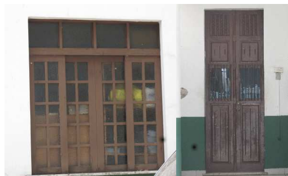
DET. 03 e 04: Esquadrias presentes na fachada principal. Ambas são de madeira e vidro, sendo que uma delas apresenta quatro folhas e almofadas de vidro, enquanto a outra possui duas folhas, almofadas trabalhadas de madeira e alguns detalhes em vidro. Fotos: Bianca Barbosa do Nascimento, 2014.
