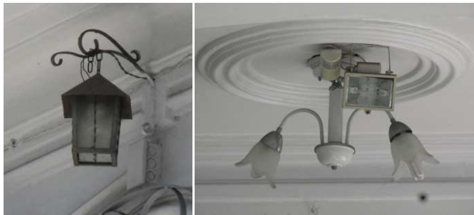
DET. 07 e 08: Arandela e lustres presentes na edificação.
