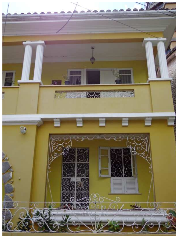
DET. 07: Presença de um detalhe do gradil no parapeito da varanda, além de uma floreira no térreo.
