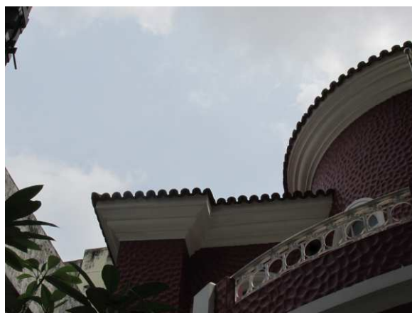
DET. 10: Composição de cobertura com telha capa canal da residência. Foto: Bianca Barbosa do Nascimento, 2014.
