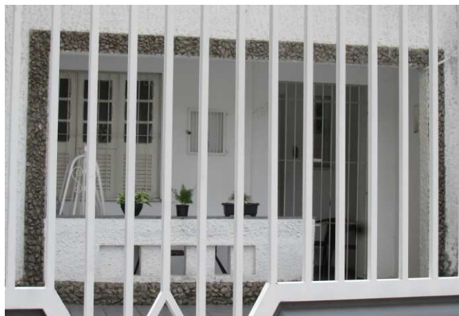
DET. 01: Parte da fachada principal, onde está localizado o térreo. É possível notar na imagem a moldura de pedrinhas que envolve a entrada principal. A esquadria presente é de madeira e vidro, estilo veneziana, juntamente com um gradil de ferro simples pintado de branco. Além disso, os elementos vazados presentes no guarda corpo do térreo também estão presentes no guarda corpo da varanda. Foto: Bianca Barbosa do Nascimento, 2014.
