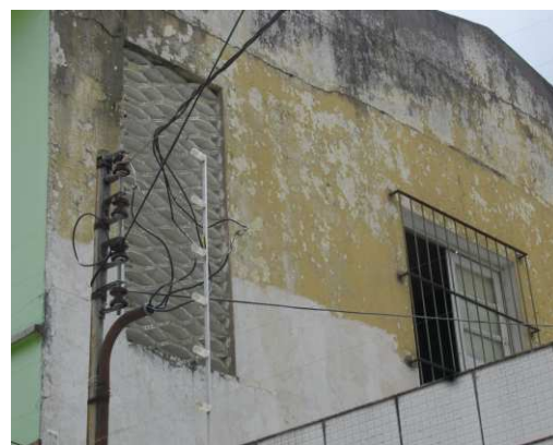
DET. 04: Detalhes de uma fachada lateral, onde há a existência de cobogós diferentes dos utilizados no guarda corpo da varanda. Ao lado, uma esquadria de madeira e vidro com gradil de ferro.
