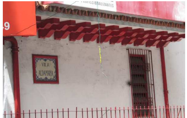
DET. 03: Lateral da edificação com ornamentos abaixo do balanço. Esses ornamentos são feitos por telhas capa canal e cachorros que aparentam suportar a carga do balanço. Abaixo disso, há uma placa de azulejos indicando o nome da vila da qual a edificação fica na esquina. E, próximo à placa, há uma esquadria basculante de ferro e vidro.
