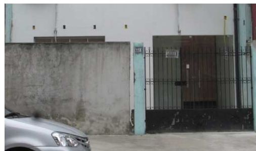
DET. 07: Modificação na fachada principal com a substituição do arco por uma entrada com porta de vidro, modificação do muro e perda da garagem. Foto: Bianca Barbosa do Nascimento, 2014.
