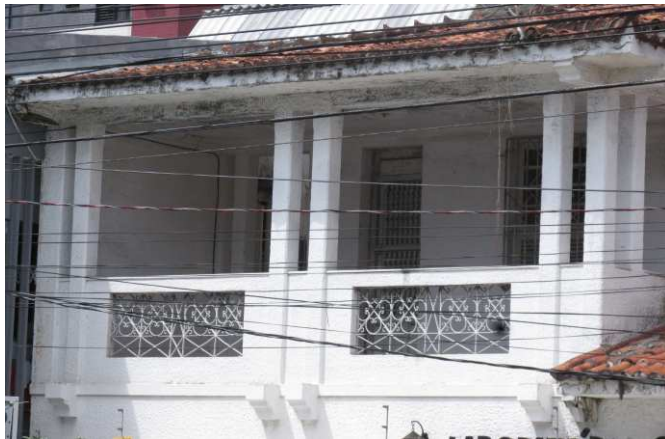
DET. 02: Detalhe da varanda com pilares que remetem a colunas toscanas e guarda corpo ornamentado com gradil de ferro pintado de branco. Abaixo do guarda corpo, existem quatro cachorros. Assim como as paredes da fachada vertical, os pilares e o guarda corpo são chapiscados.
