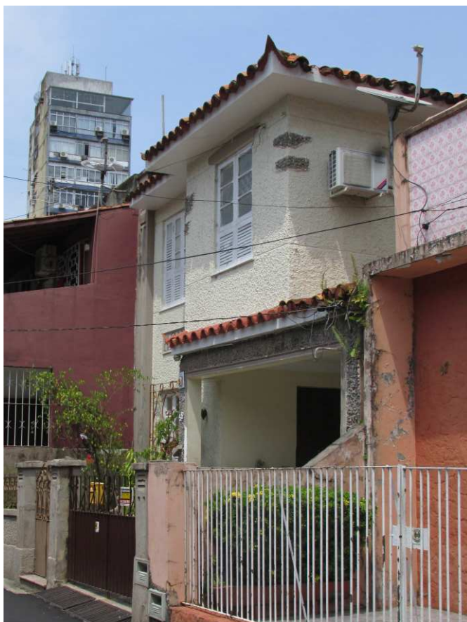
FOTO 01: Fachada principal da edificação que ainda mantém sua característica de edificação residencial. A casa possui bastante elementos da arquitetura neocolonial, como a textura na parede e as esquadrias de madeira e vidro, estilo venezianas e composição de cobertura.
