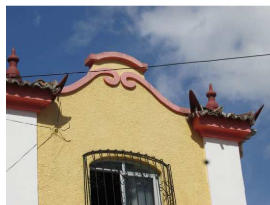
DET. 04: Detalhe do frontão presente na fachada principal. Ele possui duas volutas de argamassa e está entre dois pilares ornamentados com telhas capa canal, também presentes na cobertura, rabos de andorinhas e pináculos.
